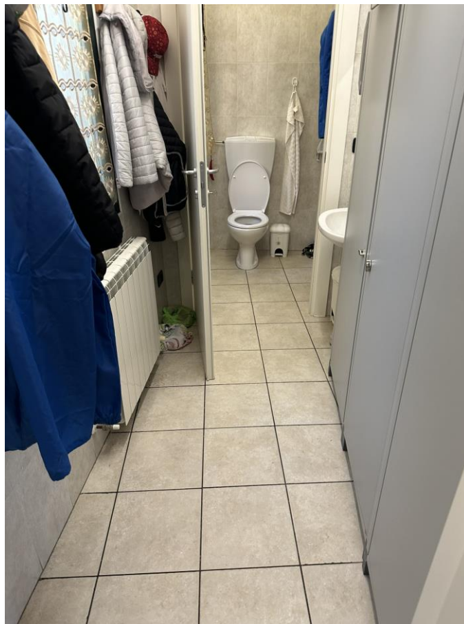
Foto n.49 Lotto n.7 (sub. 320) – P.T. – Antibagno n.2
