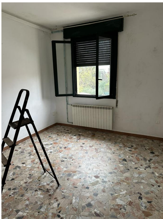
Foto n.16 – Lotto n.2 (sub. 313) – P.I.° – Soggiorno
