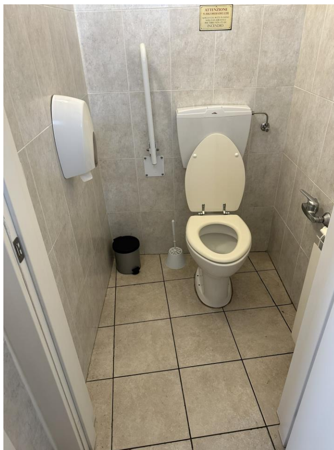
Foto n.48 Lotto n.7 (sub. 320) – P.T. – Bagno n.1
