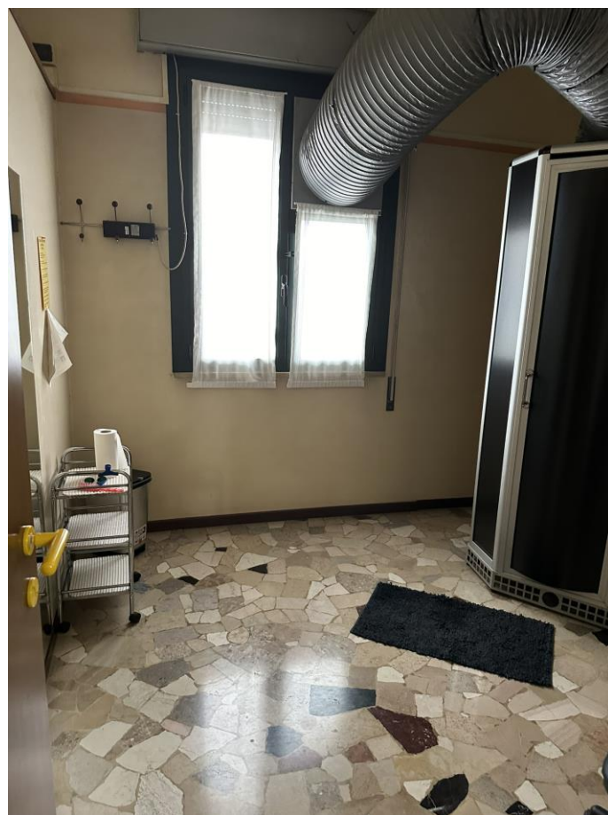
Foto n.30 - Lotto n. 4 (sub. 317) – P.I.° – Cabina trattamento
