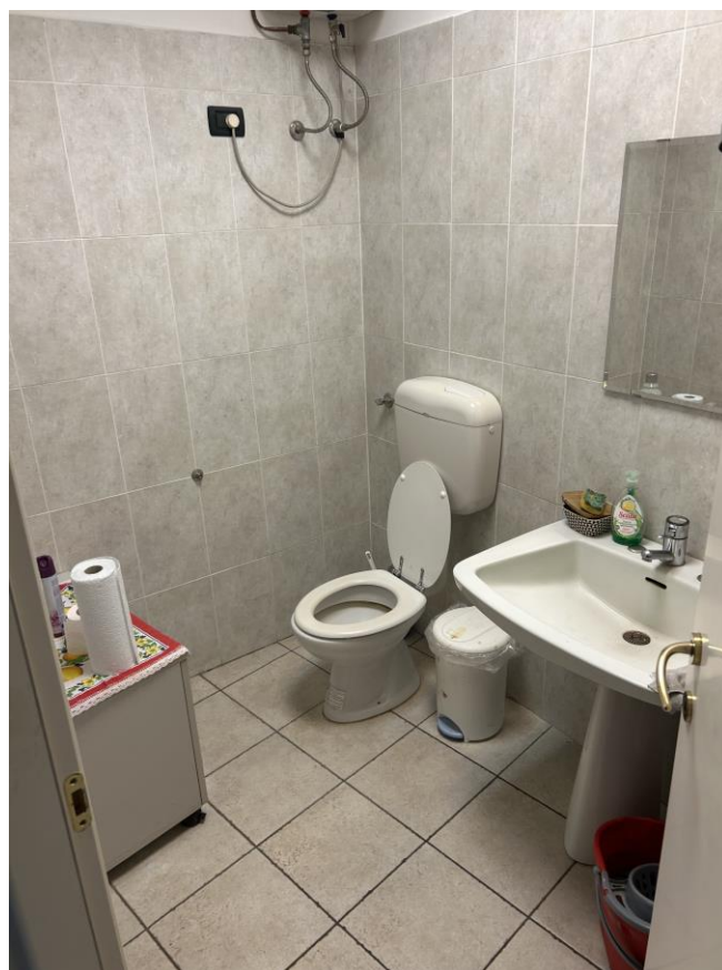
Foto n.10 – Lotto n.1 (sub. 312) – P.T. – Bagno
