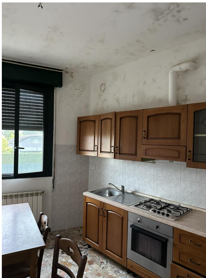
Foto n.15 – Lotto n.2 (sub. 313) – P.I.° – Cucina
