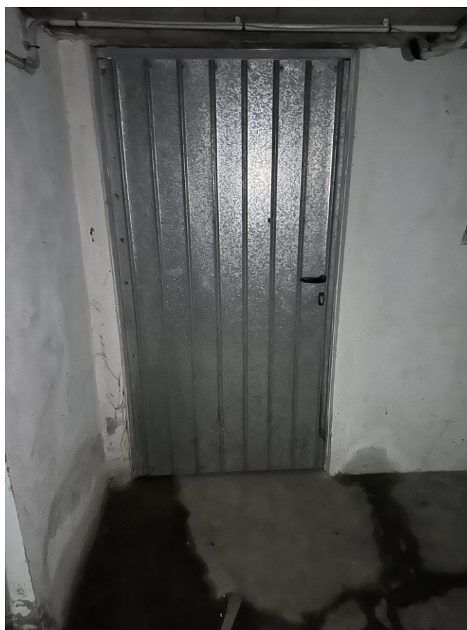
Foto n.62 Lotto n.10 (sub. 323) – P.S. – Ingresso Cantina
