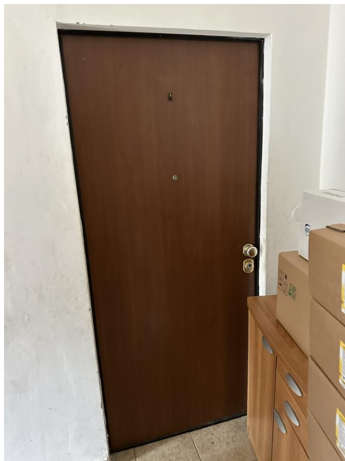
Foto n.14 – Lotto n.2 (sub. 313) – P.I.° – Ingresso unità immobiliare
