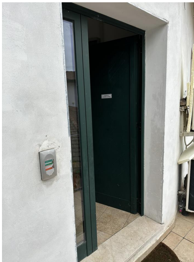
Foto n.12 – Lotto n.2 (sub. 313) – P.I.° – Ingresso disimpegno comune (sub 314)
