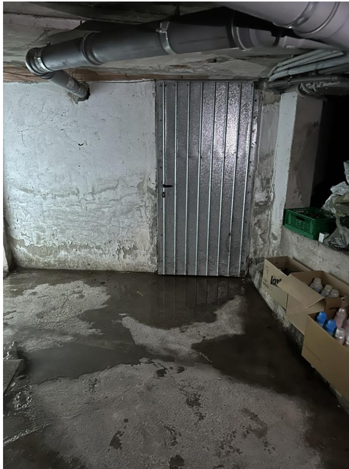
Foto n.60 Lotto n.9 (sub. 322) – P.S. – Ingresso Cantina
