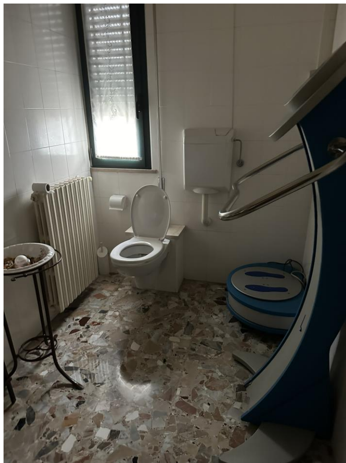
Foto n.32 - Lotto n.4 (sub. 317) – P.I.° – Bagno n. 2
