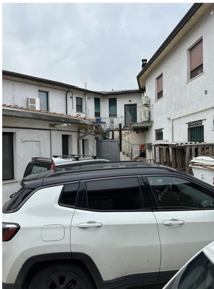
Foto n.6 – parte vista posteriore 1
