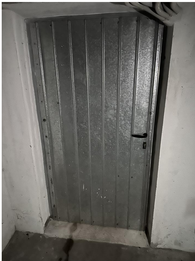
Foto n.58 Lotto n.8 (sub. 321) – P.S. – Ingresso locale di deposito
