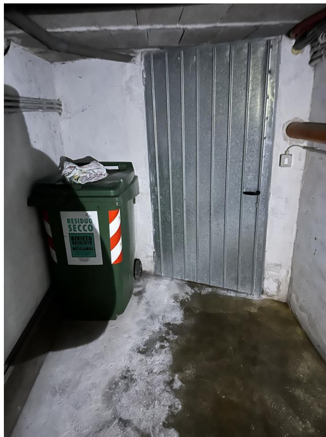
Foto n.52 Lotto n.7 (sub. 320) – P.S. – Ingresso locale di deposito
