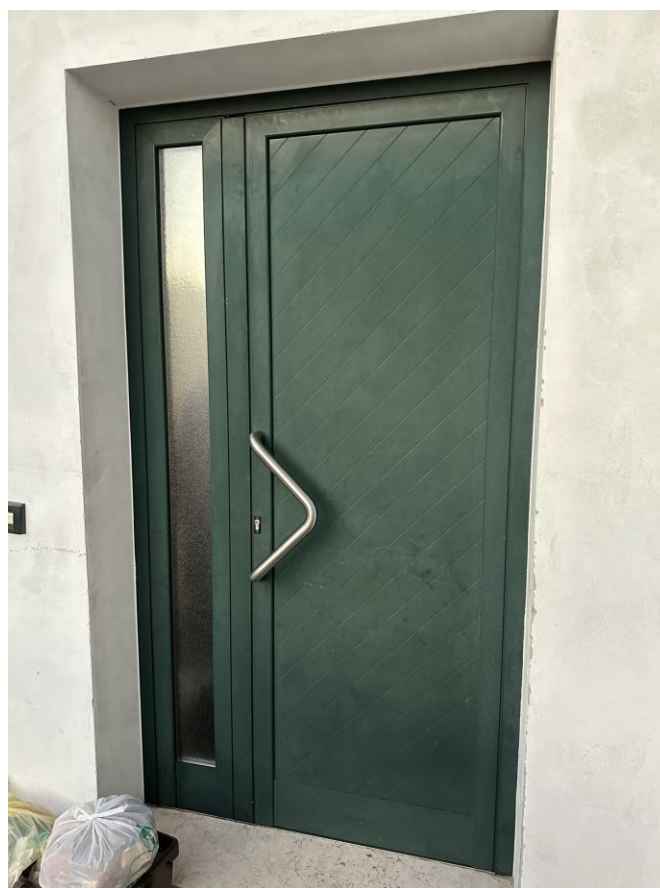
Foto n.20 – Lotto n.3 (sub. 316) – P.I.° – Ingresso unità immobiliare
