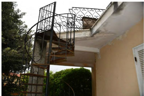
Particolare della scala a chiocciola e dell'accesso al lastrico solare
