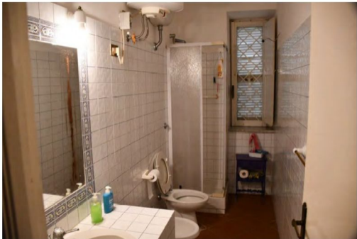
Particolare del bagno
