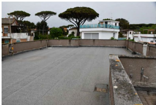
Particolare del lastrico solare
