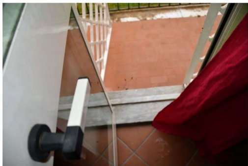
Particolare dell'ingresso laterale, sulla terrazza
