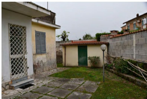
Particolare del retrospetto e della cantina in aderenza al confine
