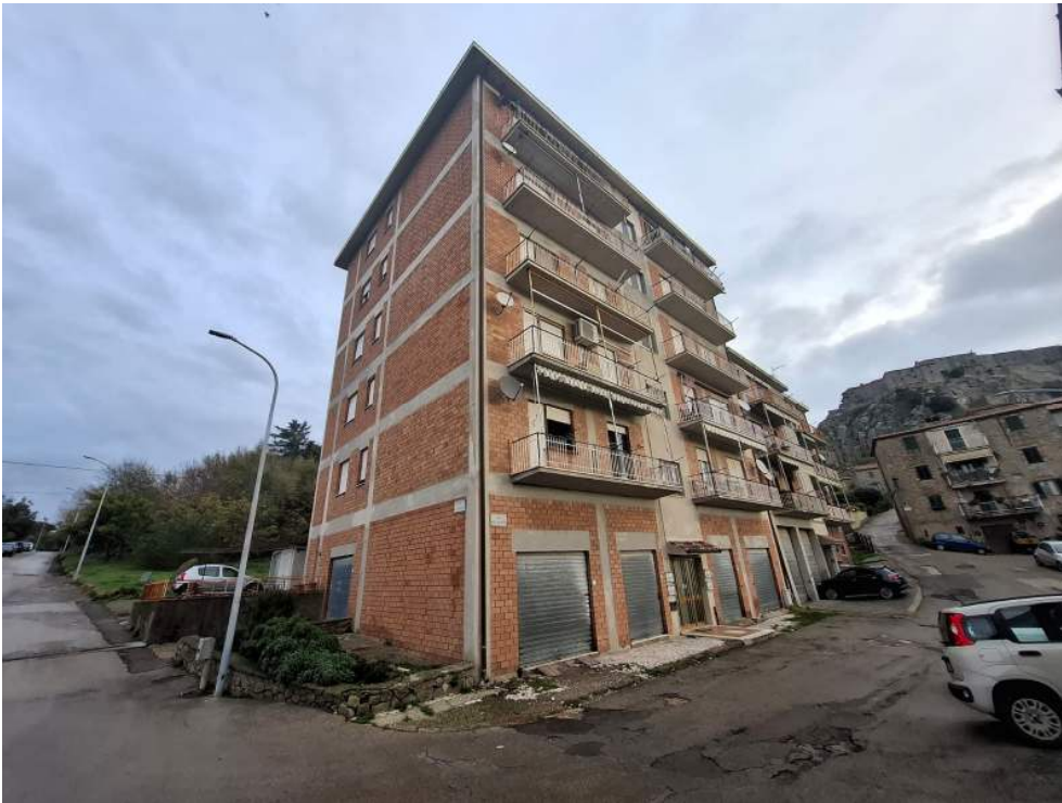
FOTO 1 Veduta del fabbricato da Via della Fonte
