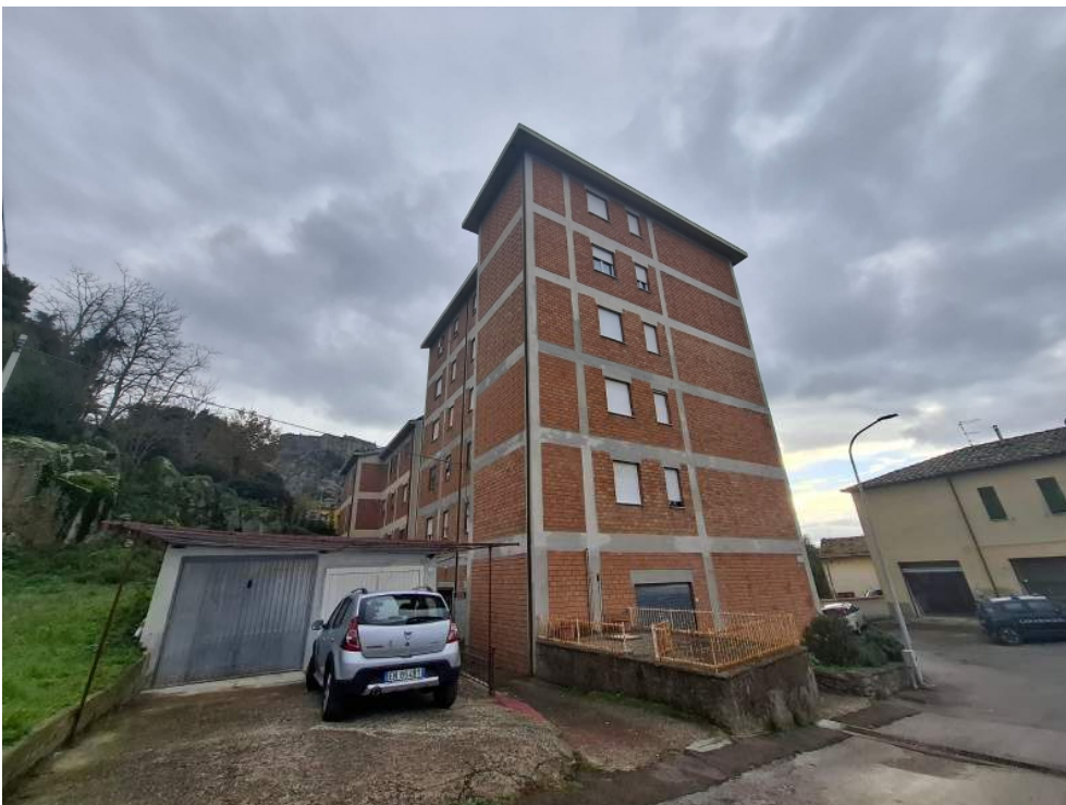
FOTO 2 Veduta del fabbricato da Via Giosuè Carducci
