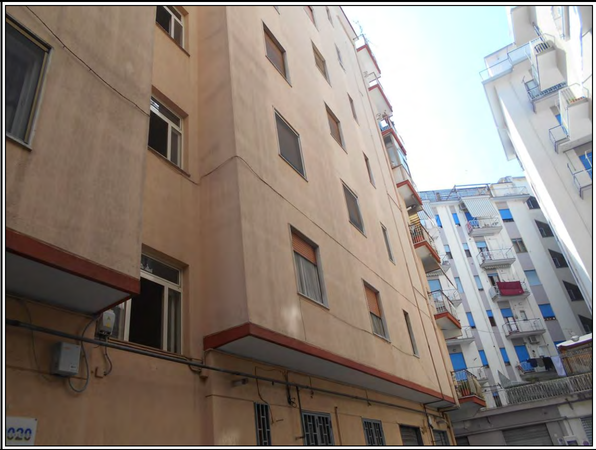
Foto n.3: Prospetto del fabbricato su Via Bartolomeo Eustachio.
