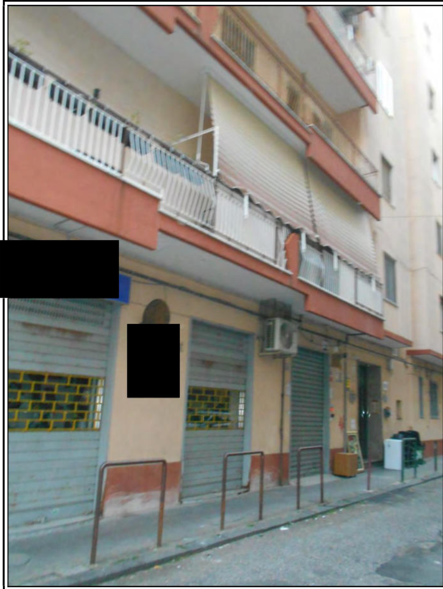
Foto n.1: Via Bartolomeo Eustachio vista da sud-est
