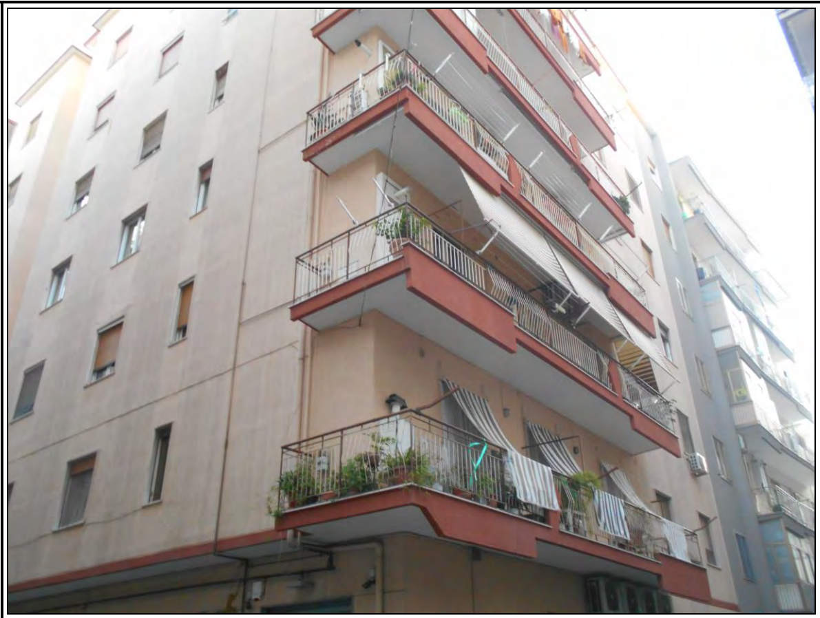
Foto n.4: Prospetto del fabbricato su corte privata
