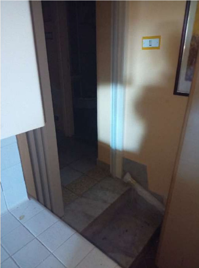
Fotografia 23 – Interno – P.T. scala cucina. Bene 2 – Abitazione, p.lla n. 1558
