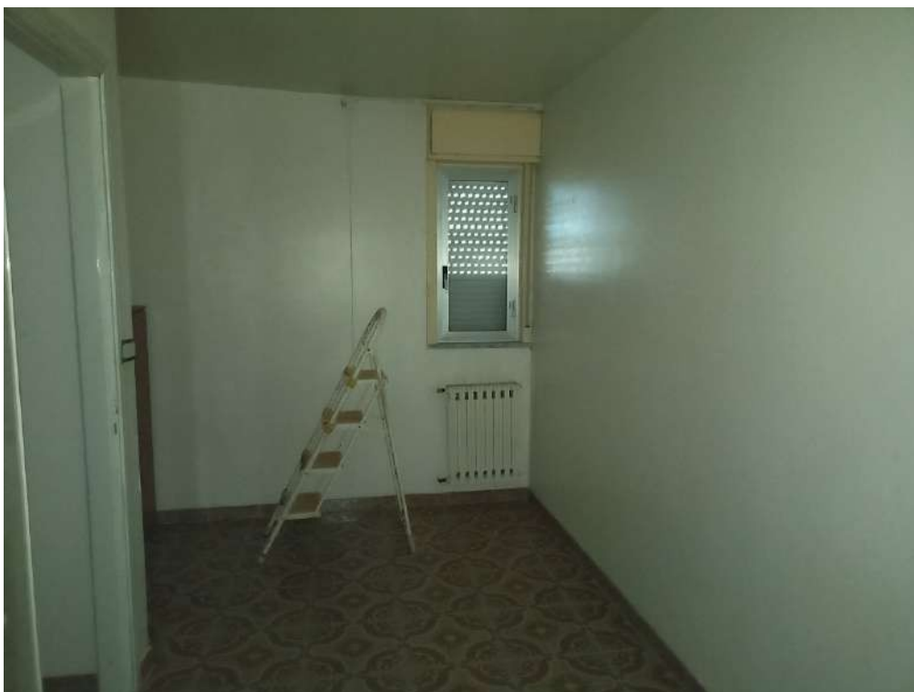
Fotografia 38 – Interno – P.I. Letto 4. Bene 2 – Abitazione, p.lla n. 1558
