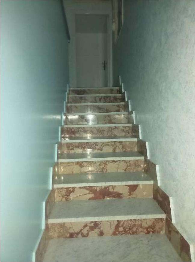
Fotografia 27 – Interno – vano scala.
