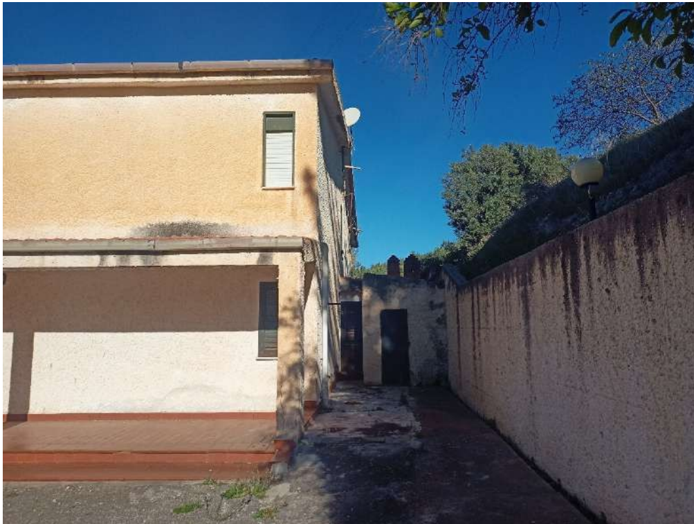
Fotografia 42 – Prospetto laterale su corte p.lla 1557. Bene 2 – Abitazione, p.lla n. 1558 – Bene 3 - Corte p.lla n. 1559 Lotto UNICO – Imm. identif. al N.C.T. del Comune di Termini Imerese (PA), fg. n.57, part.lle nn. 1557 – 1559 – Imm. identif. al N.C.E.U. del Comune di Termini Imerese (PA), fg. n.57, part.lle nn. 1558 – 1560.
