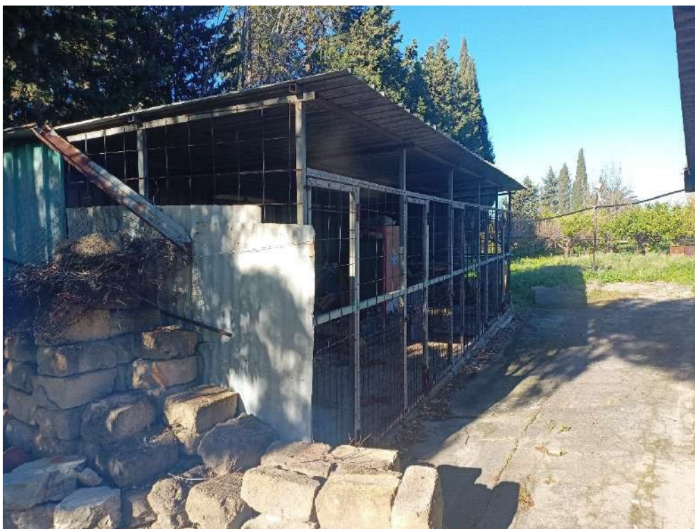
Fotografia 50 – Tettoia. Bene 4 – Magazzino p.lla n. 1560
