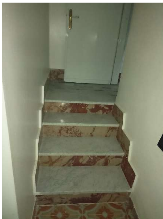
Fotografia 34 – Interno – P.I. scale disimpegno. Bene 2 – Abitazione, p.lla n. 1558
