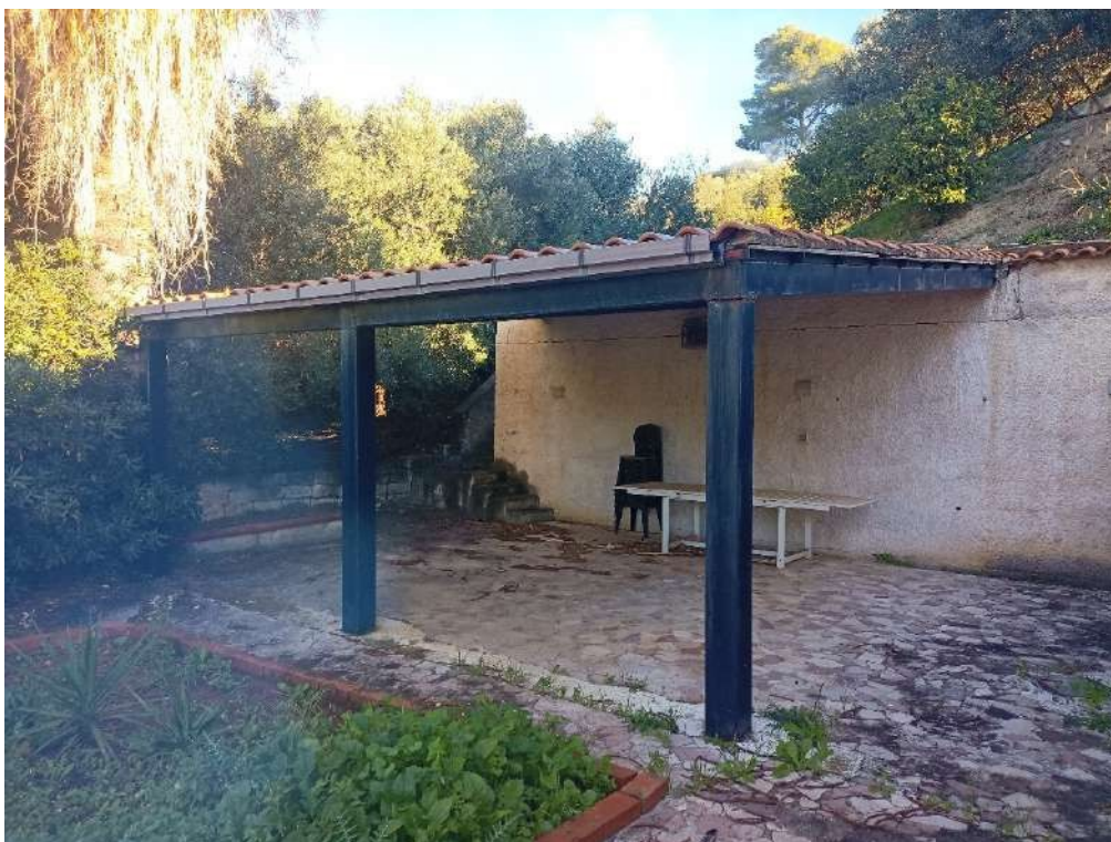
Fotografia 15 – Tettoia. Bene 1 - Corte, p.lla 1557
