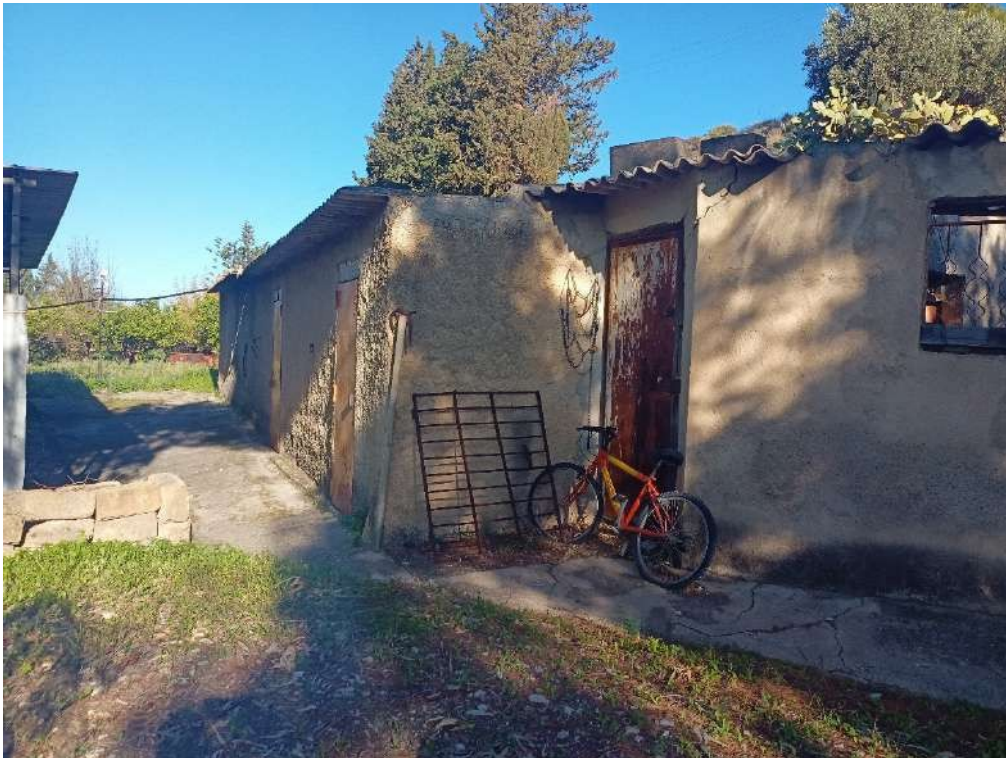
Fotografia 47 – Prospetto magazzino. Bene 4 – Magazzino p.lla n. 1560
