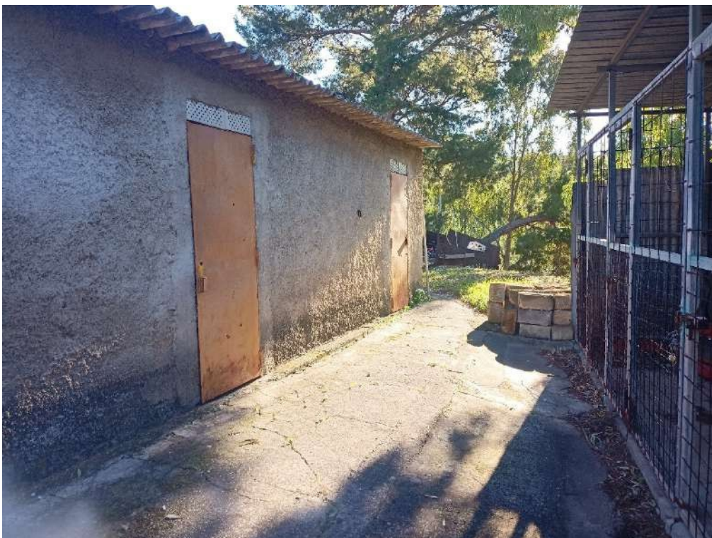
Fotografia 48 – Prospetto magazzino. Bene 4 – Magazzino p.lla n. 1560
