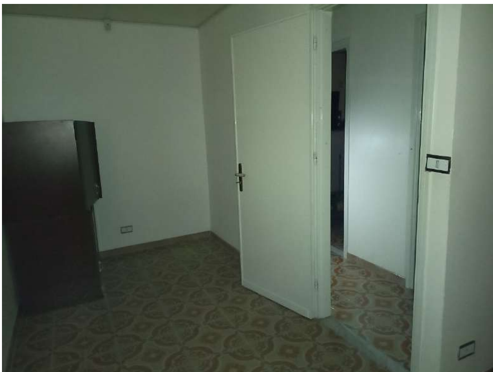
Fotografia 37 – Interno – P.I. Letto 4. Bene 2 – Abitazione, p.lla n. 1558
