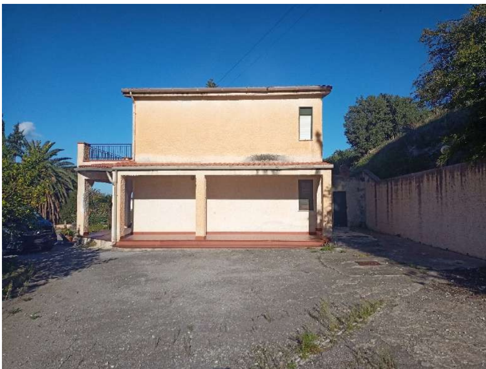
Fotografia 41 – Prospetto laterale su corte p.lla 1559. Bene 2 – Abitazione, p.lla n. 1558 – Bene 3 - Corte p.lla n. 1559 Lotto UNICO – Imm. identif. al N.C.T. del Comune di Termini Imerese (PA), fg. n.57, part.lle nn. 1557 – 1559 – Imm. identif. al N.C.E.U. del Comune di Termini Imerese (PA), fg. n.57, part.lle nn. 1558 – 1560.
