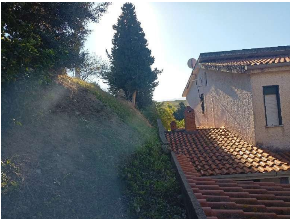
Fotografia 12 – Prospetto posteriore. Bene 2 – Abitazione, p.lla n. 1558
