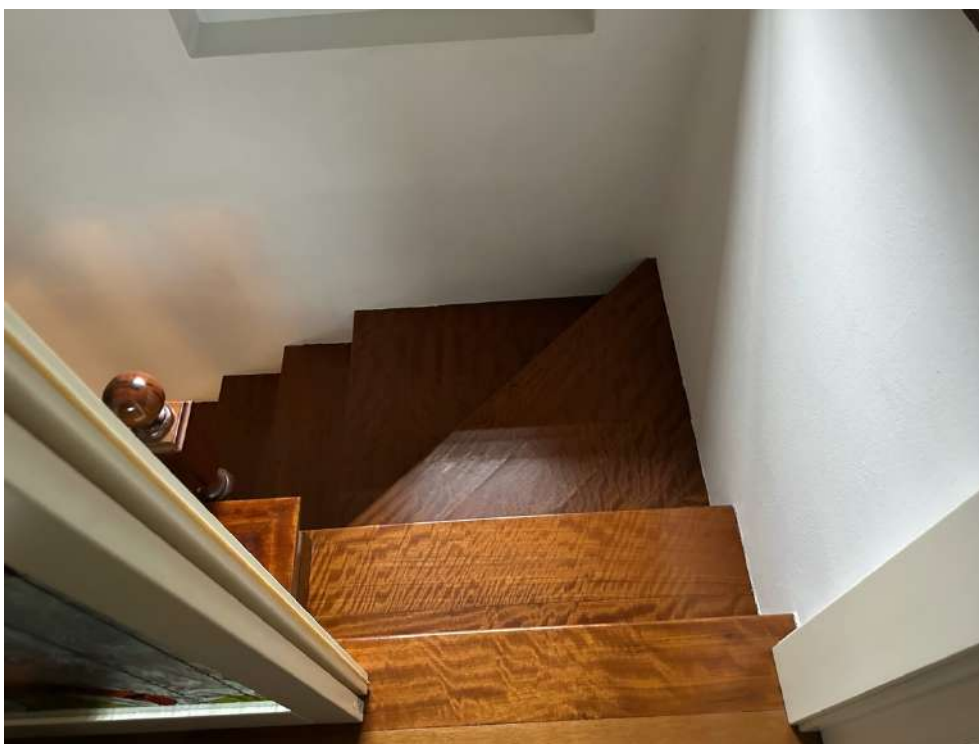
Scala interna a piano primo.
