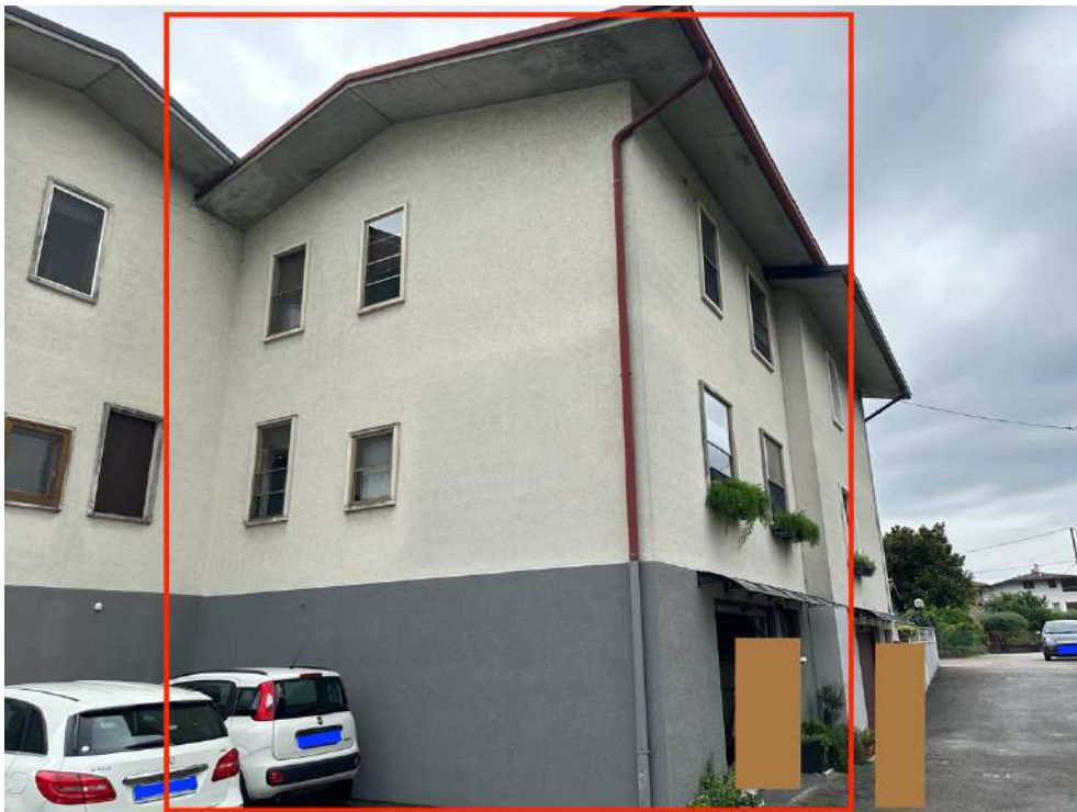
Vista del retro (lati nord-est e nord-ovest).
