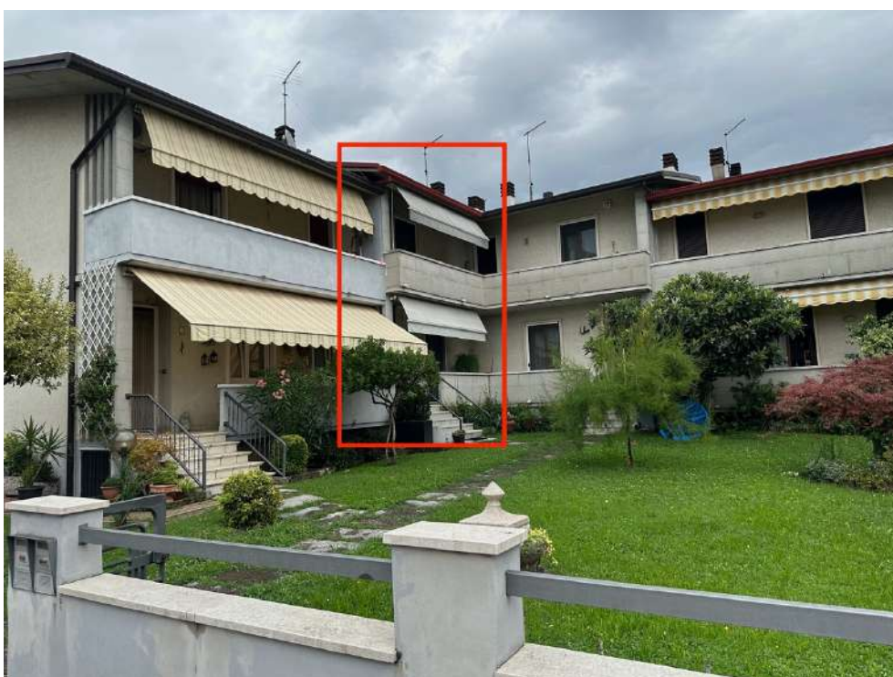
Fronte principale (lato sud-est).
