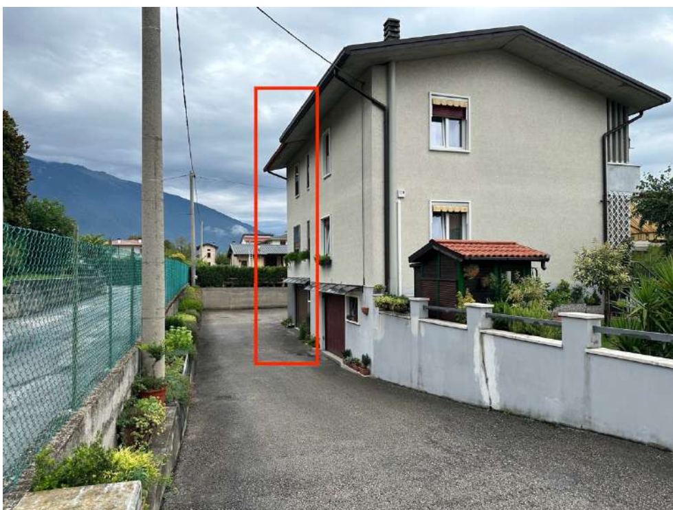
Vista del retro (lato nord-ovest).
