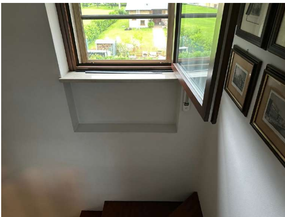
Dettaglio finestra vano scala a piano primo.
