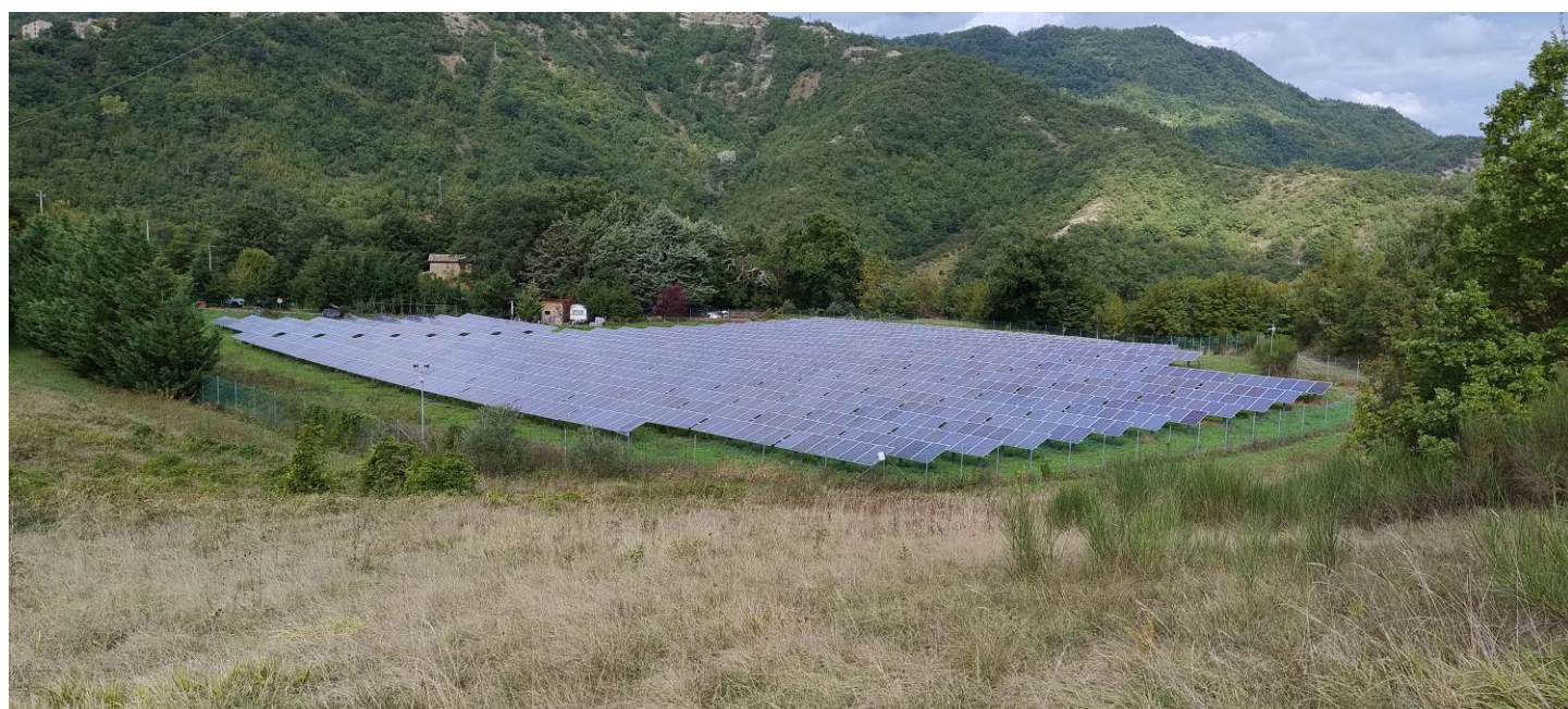
FOTO 2 Vista da SE impianto fotovoltaico
