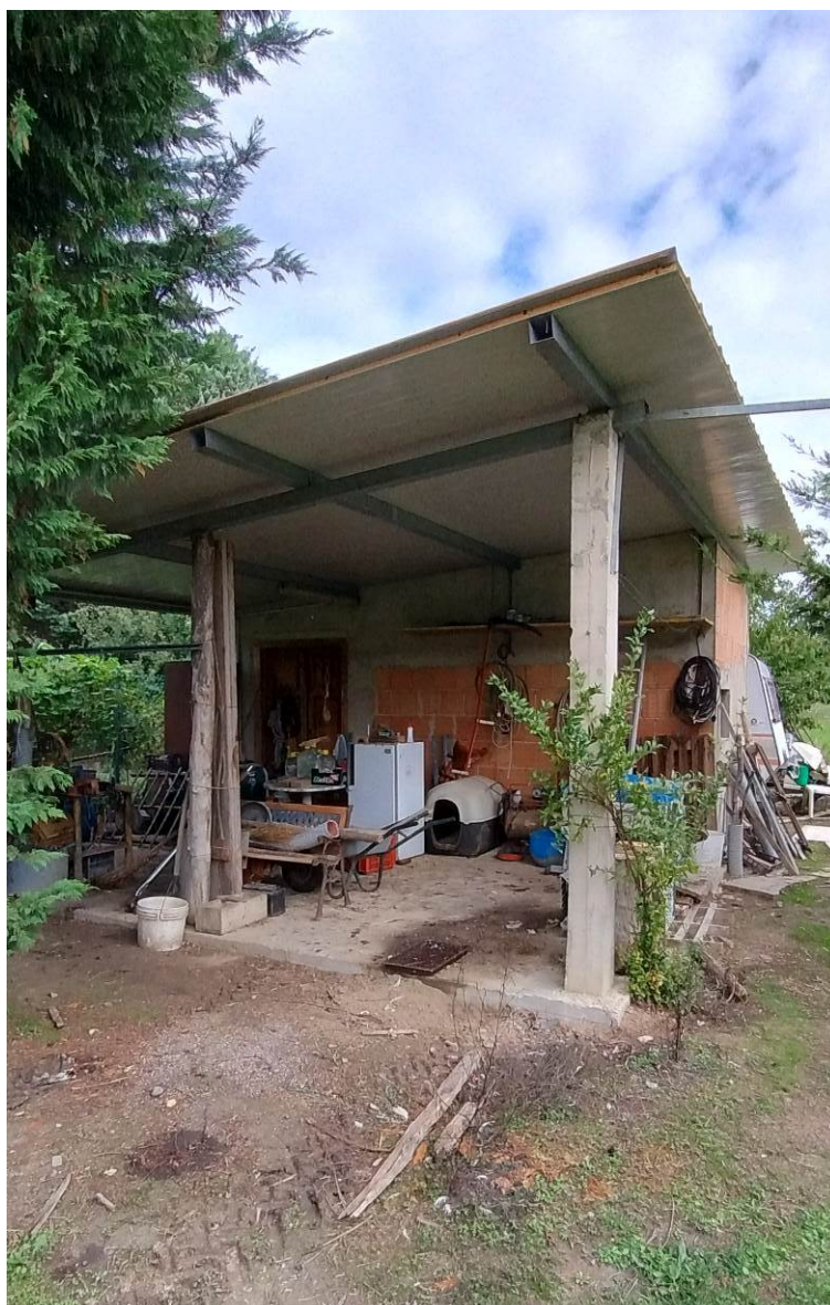
FOTO 4 Vista lato S manufatto abusivo
