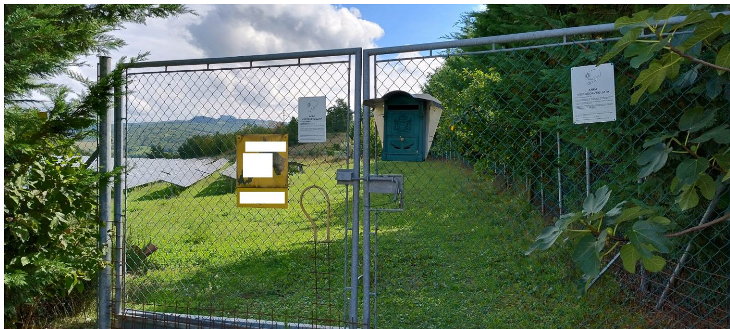
FOTO 1 Vista accesso area recintata impianto fotovoltaico
