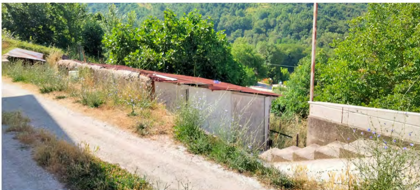
Foto 24 – Corte esterna – Particella 706 con annessi abusivi
