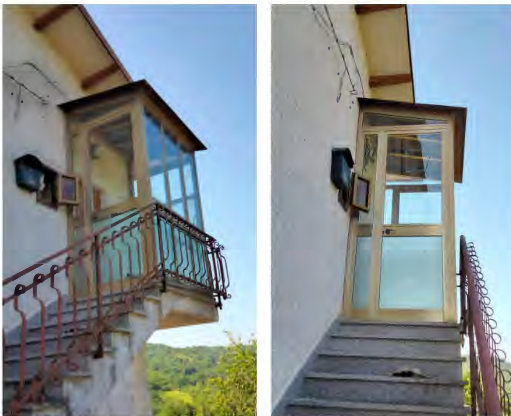
Foto 6 – Bussola di ingresso al piano primo
