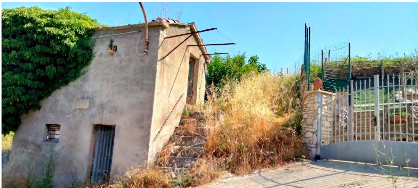
Foto 23 – Corte esterna – Particella 335 vista dal basso/accesso
