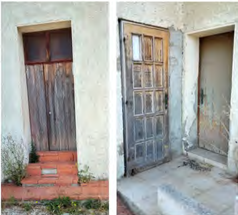
Foto 5 – Porte esterne al piano terra
