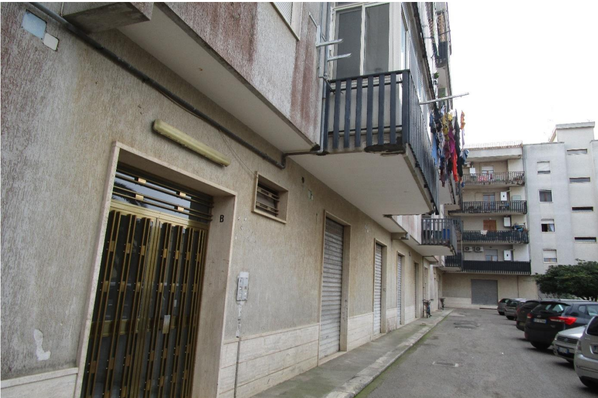
FOTO 4 – INGRESSO DALL'INTERNO – VIA MORO ANGOLO VIA TURATI
