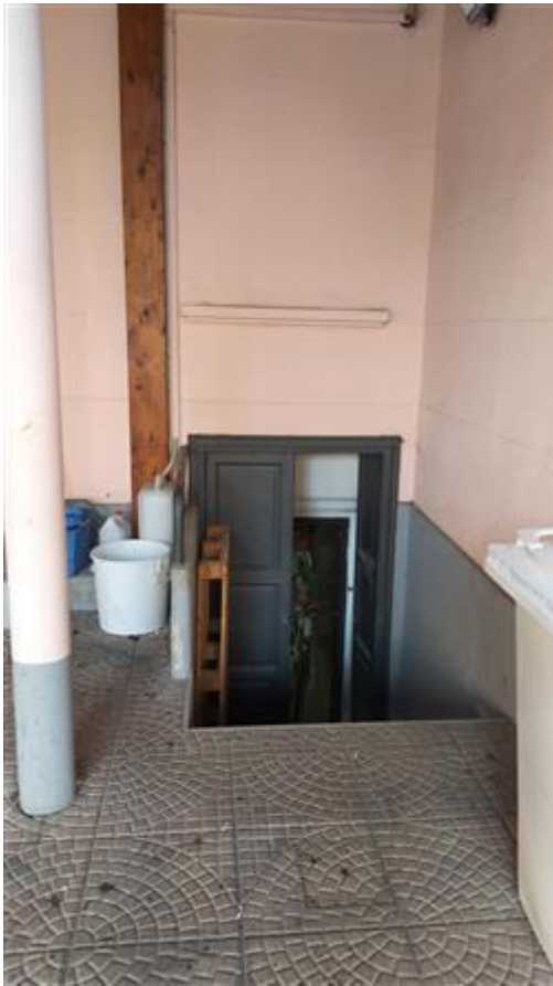
ingresso del seminterrato uso deposito/laboratorio
