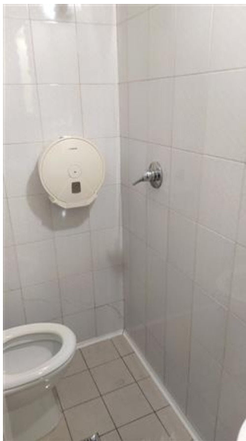
interno locale bagno
