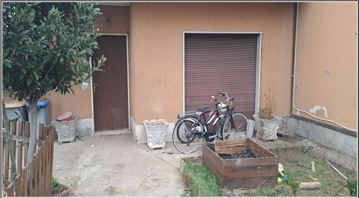
Prospetto SUD – Ingresso - Piano Terra
