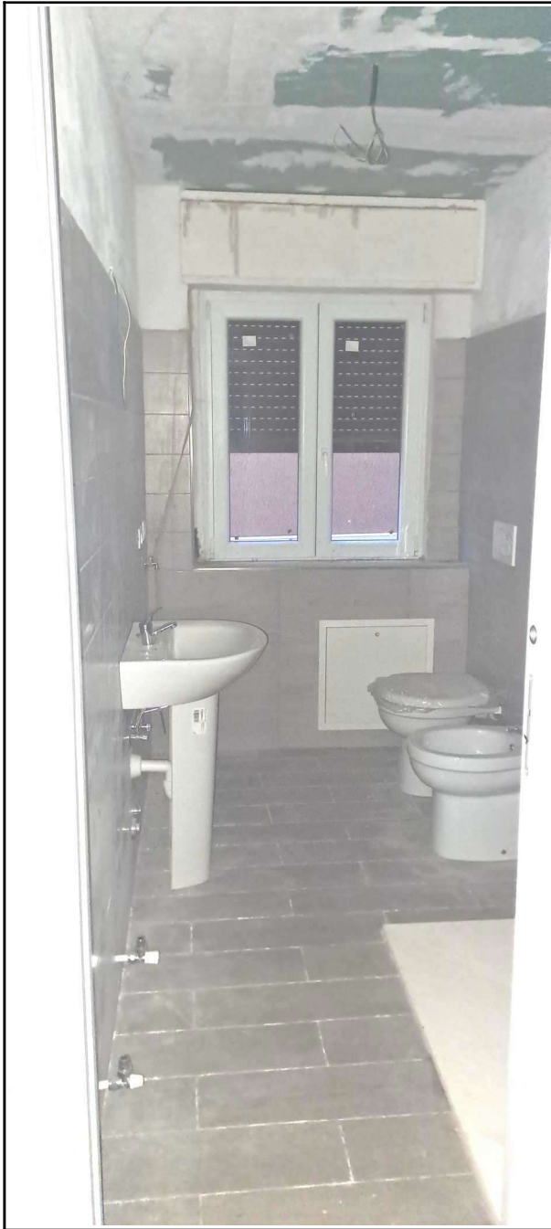
Bagno - Piano Terra
