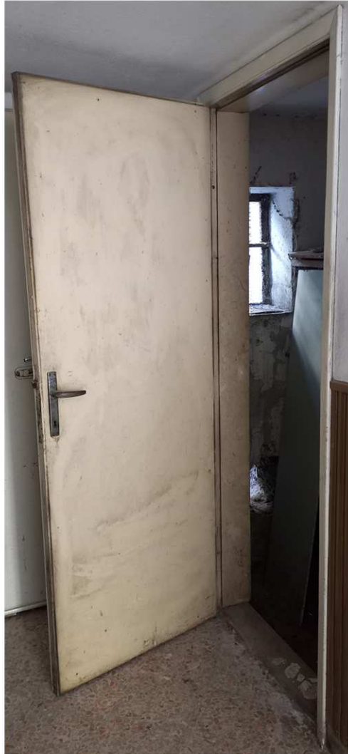
Interno ripostiglio sottoscala
