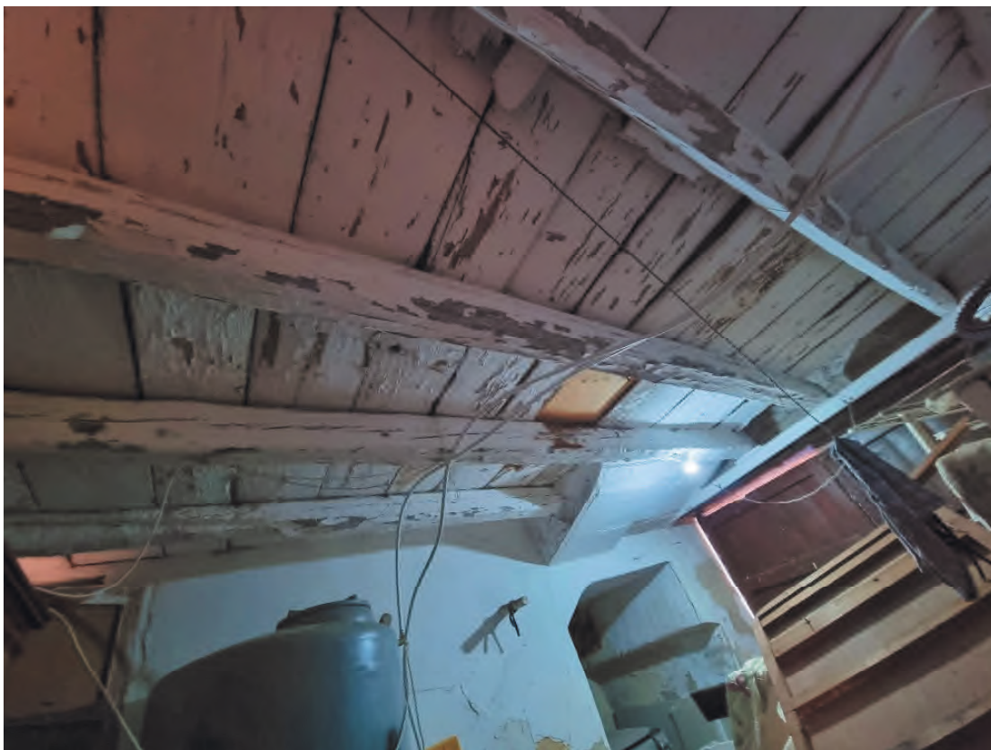
Foto 5. Particolare del soffitto
