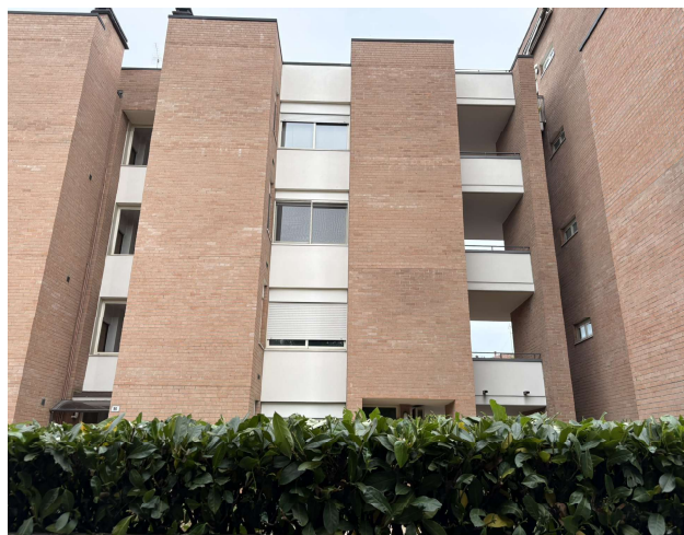
Fronte del fabbricato su Via Piave civ.96
