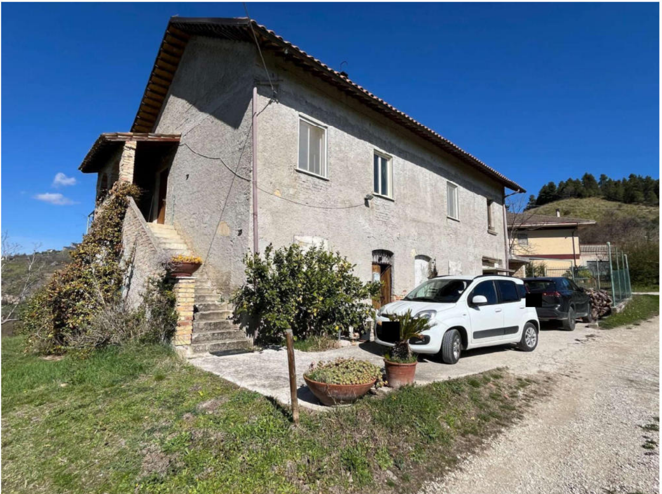
ESTERNO LATO EST
