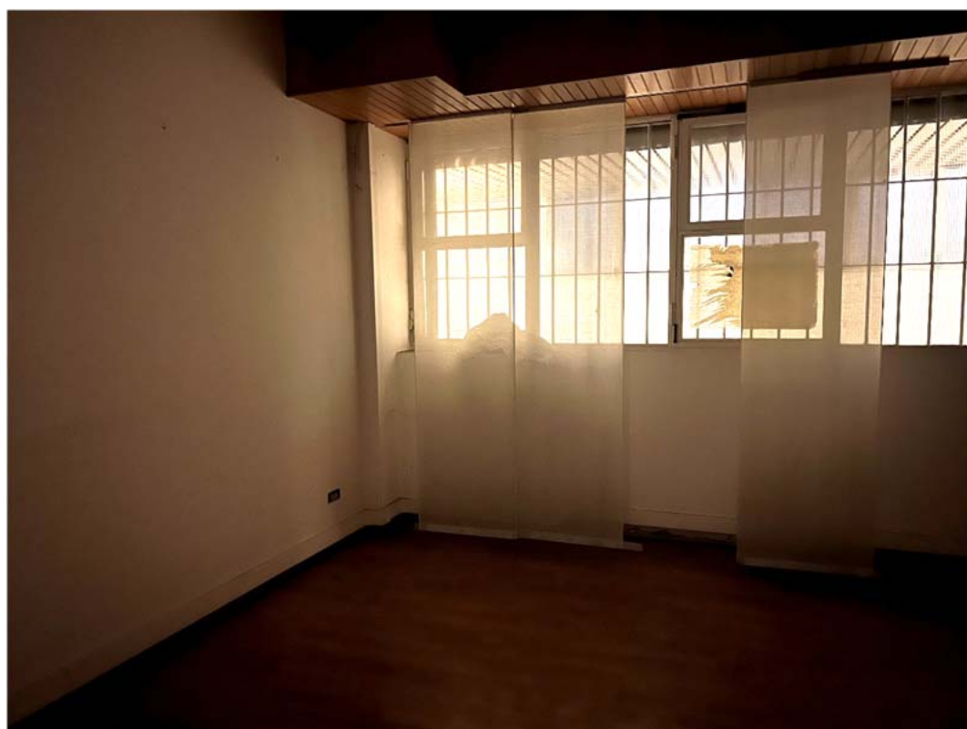
Locale retrostante al piano interrato
