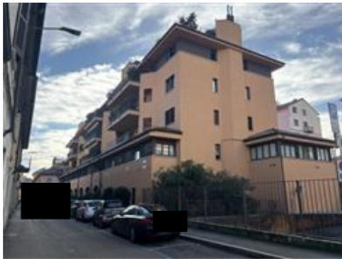
Vista su Via Ramazzotti in cui insiste negozio
