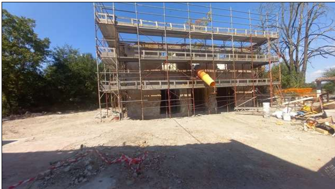
Foto 7: Porzione centrale del fabbricato demolita (sub. 1 parte) e porzione in fase di cantiere: ad uso ufficio (sub. 1 parte) e porzione abitativa (sub. 2)
