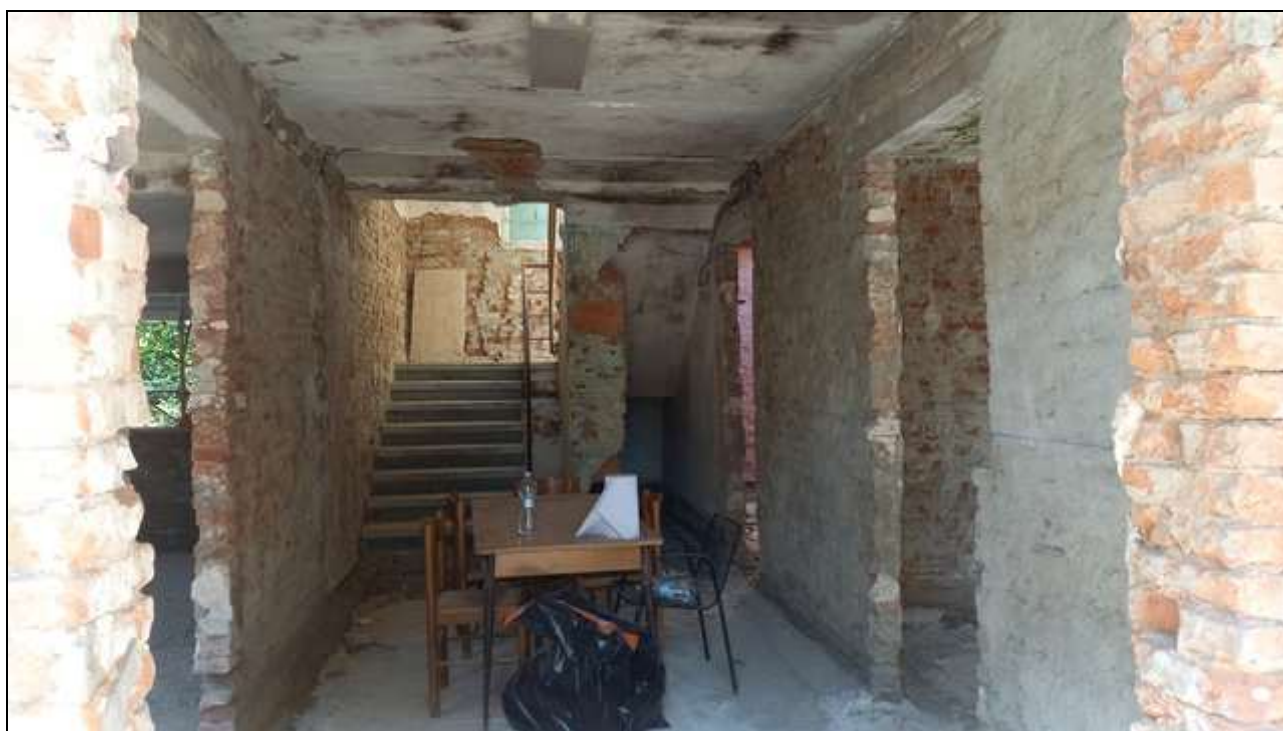
Foto 8: Porzione in fase di cantiere
