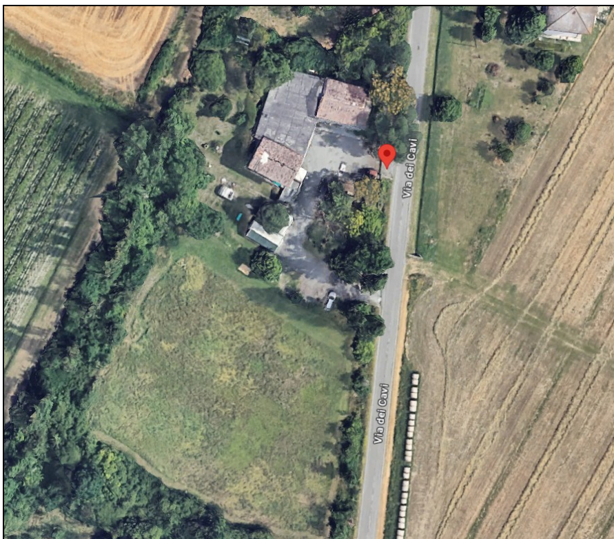
Foto 1: Vista area del fabbricato
