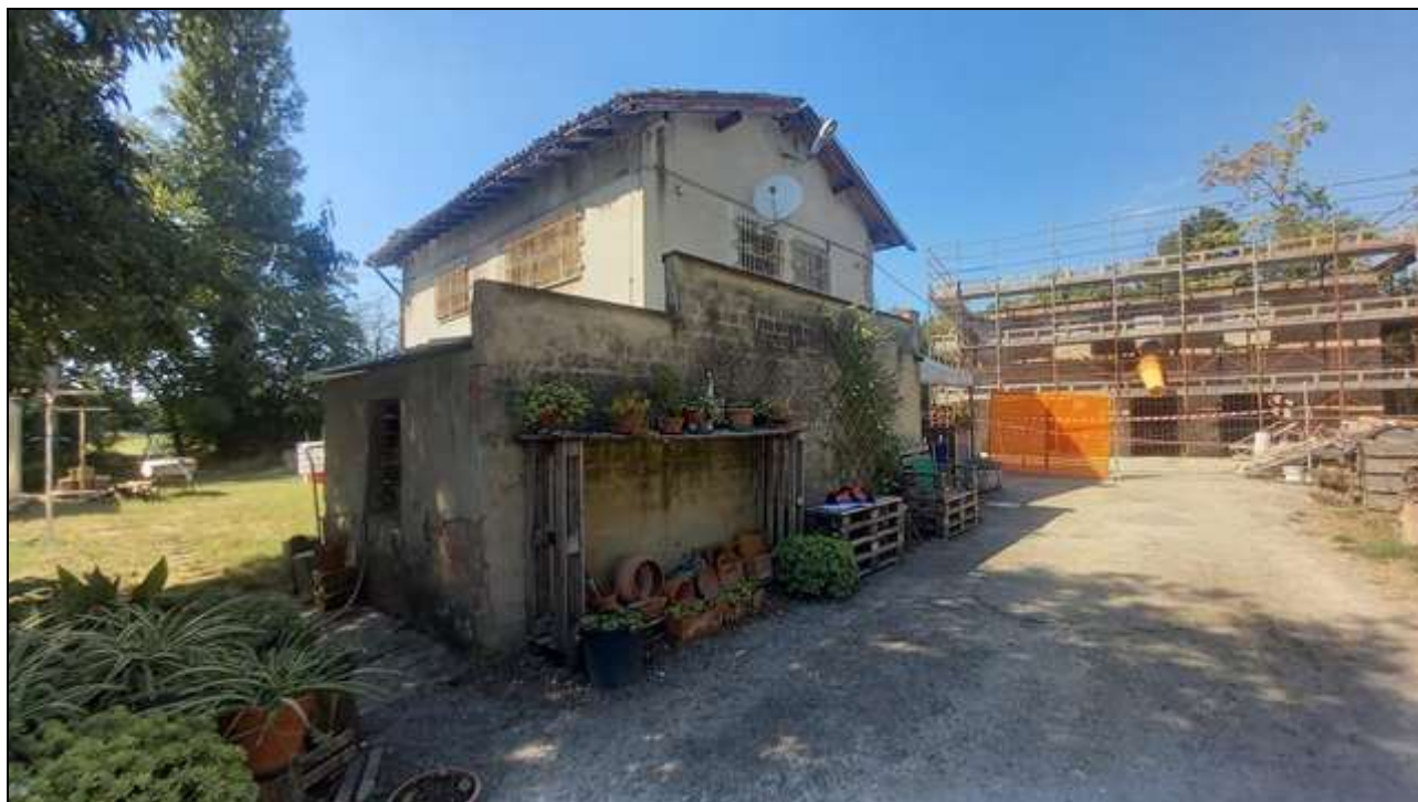
Foto 3: Porzione del fabbricato inagibile laboratorio con servizi ed autorimessa (sub. 1 parte), uso ufficio (sub. 1 parte) ed abitazione (sub. 2) in fase di cantiere
