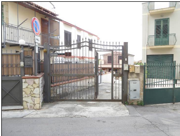
Ingresso alla corte scoperta afferente alla particella 1237, posto al civico n. 3 di via Falsomiele
