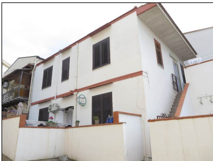
Unità immobiliare oggetto di pignoramento
