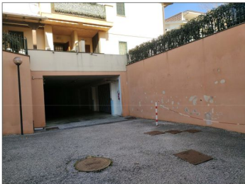
Fotografia numero 15 – Vista accesso Area Condominiale dove c'è il Garage al Piano seminterrato oggetto di Esecuzione Immobiliare.
