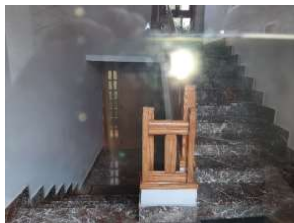
Foto 19 Particolare Vano scala (sub 2 Bcnc)
