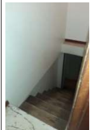
Foto 17 Particolare scala collegamento Piano Seminterrato
