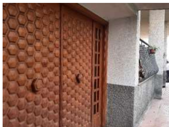
Foto 18 Particolare ingresso Vano scala (sub 2 Bcnc)
