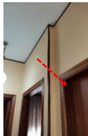
Foto 16 Particolare porta di accesso alla scala PT-Piano Seminterrato
