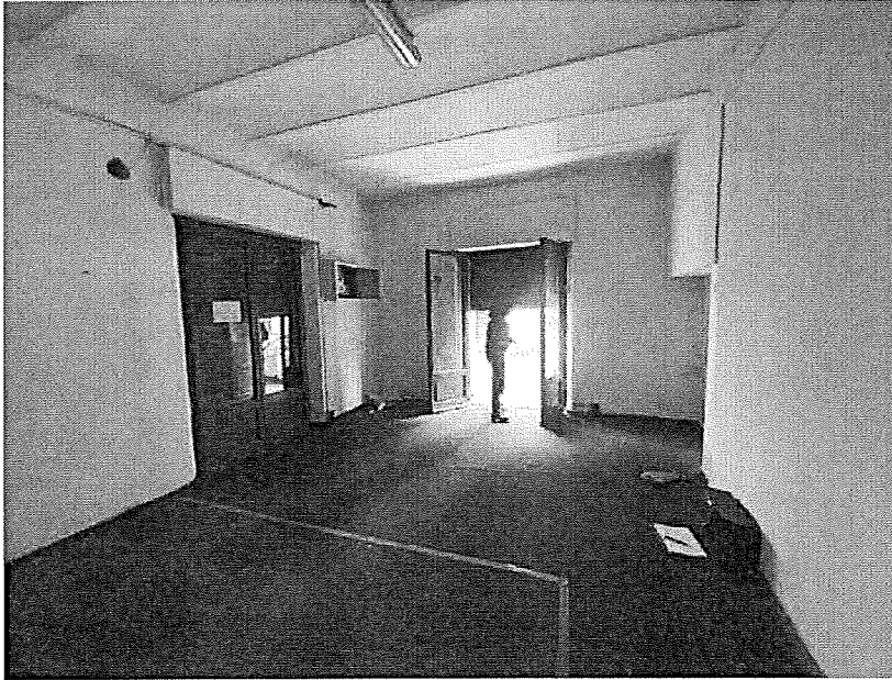
Foto n. 4 Sostituzione serratura per accesso forzoso
