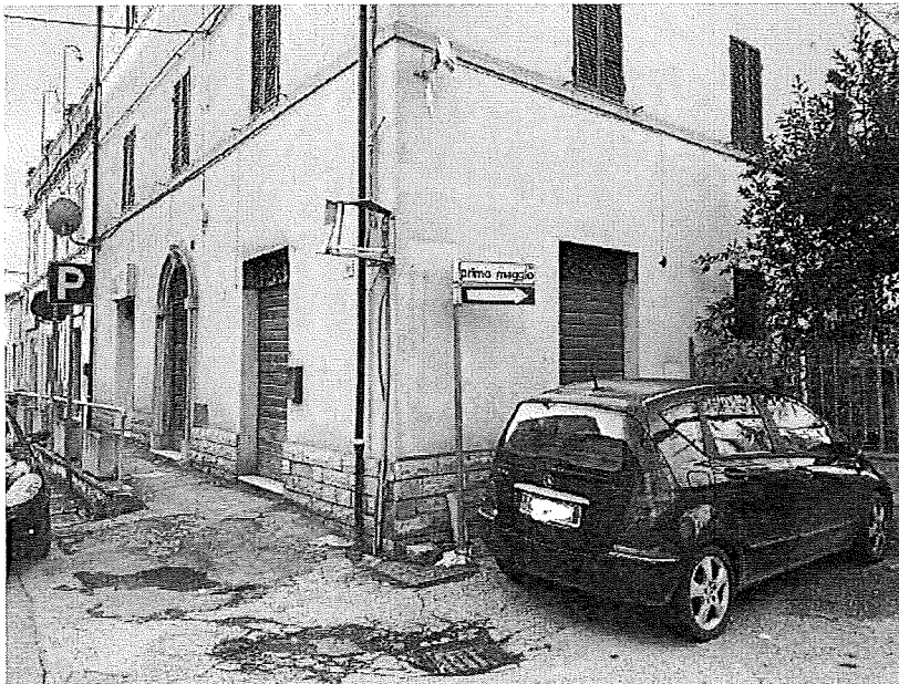
Foto n. 2 Portoni di ingresso
