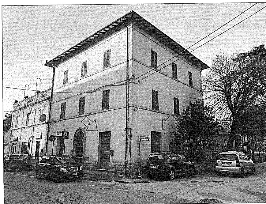
Edificio via Deruta, il negozio ha le due saracinesche indicate
