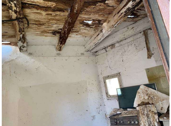
viste degrado della cucina con primo solaio in parte crollato
