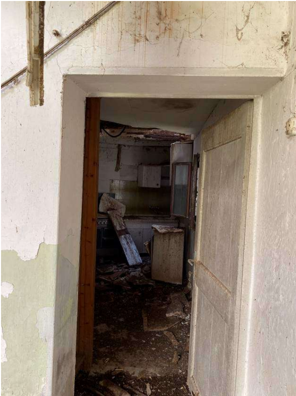
viste degrado della cucina con primo solaio in parte crollato
