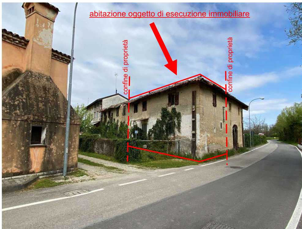
vista prospetto lato Sud-Est
