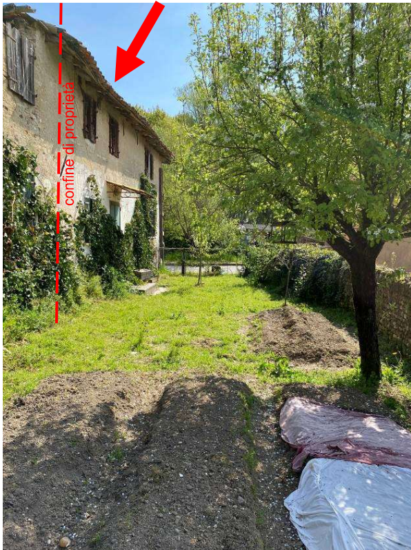
vista prospetto lato Sud
