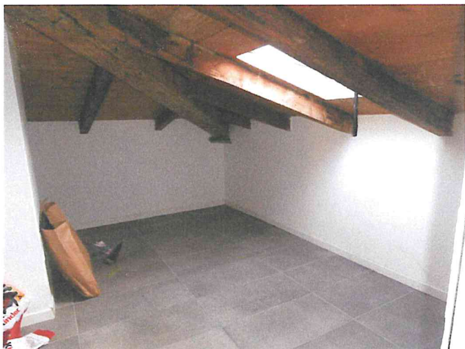
Foto 37 - Solaio angolo S.JPG
