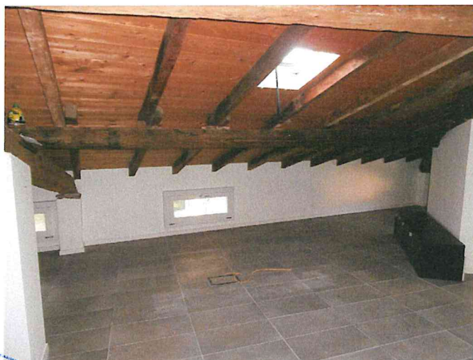
Foto 46 - Solaio angolo N-O.JPG
