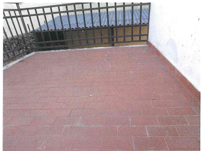
Foto 24 - Balcone camera S-E.JPG
