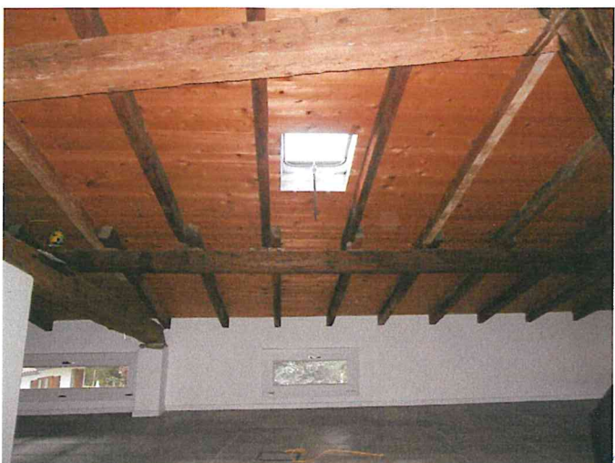
Foto 45 - Solaio lato O.JPG
