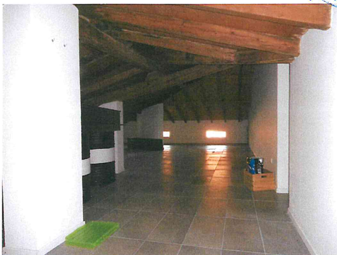
Foto 41 - Solaio porzione centrale.JPG
