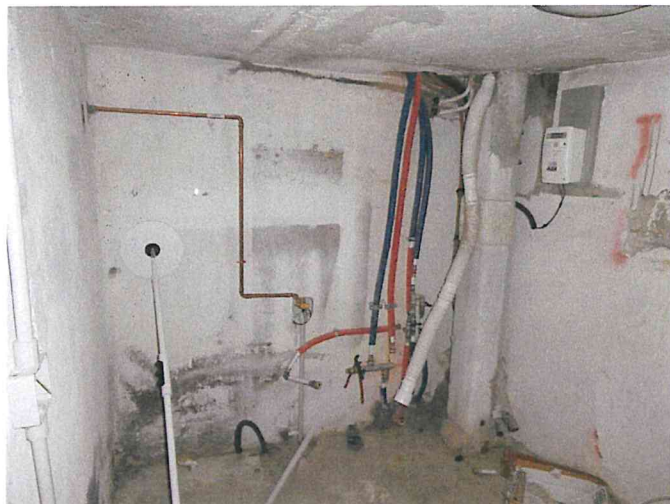
Foto 50 - Locale centrale termica.JPG
