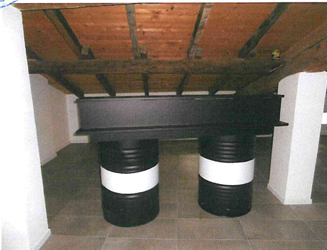
Foto 42 - Solaio angolo S-O.JPG
