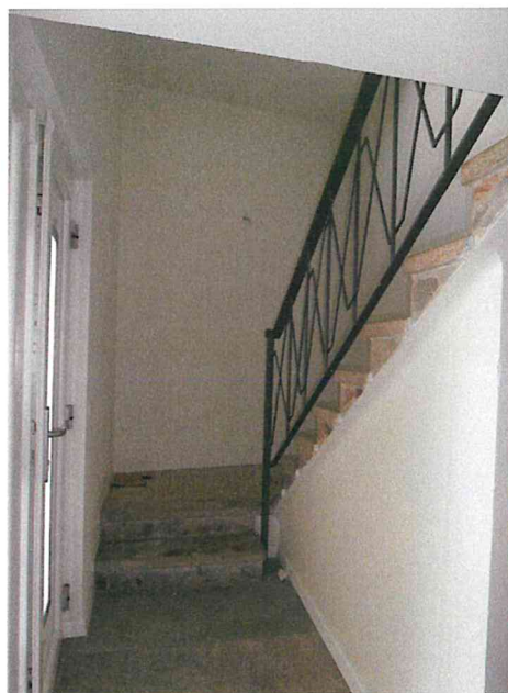
Foto 18 - Vano scala I rampa.JPG
