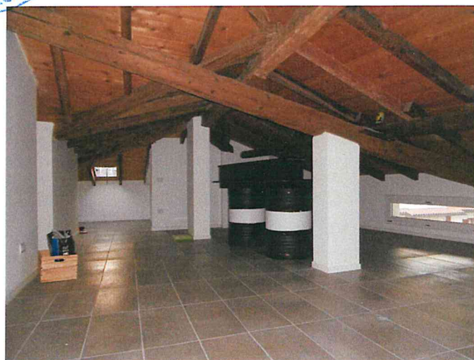
Foto 48 - Solaio porzione centrale.JPG
