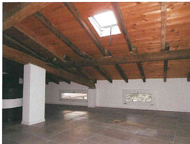
Foto 44 - Solaio lato O.JPG
