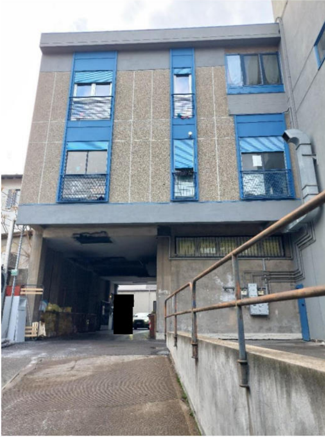
Figura 1 - Prospetto est dell'edificio con vista delle tre finestre dell'appartamento al piano primo
