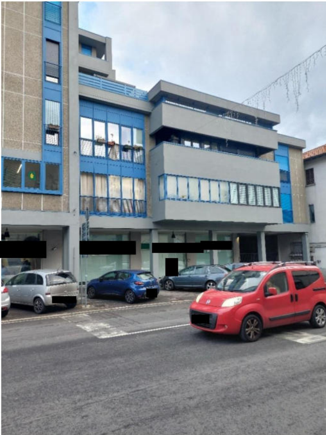
Figura 2 - Prospetto ovest dell'edificio
