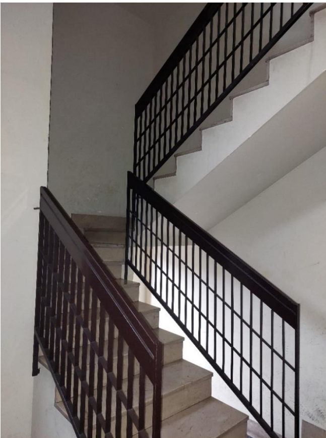
Figura 18 - Vista del vano scale
