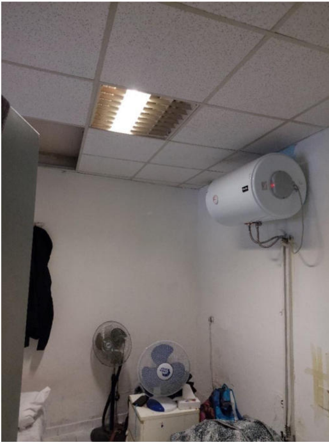
Figura 13 - Vista dell'altro ripostiglio a sud usato come camera
