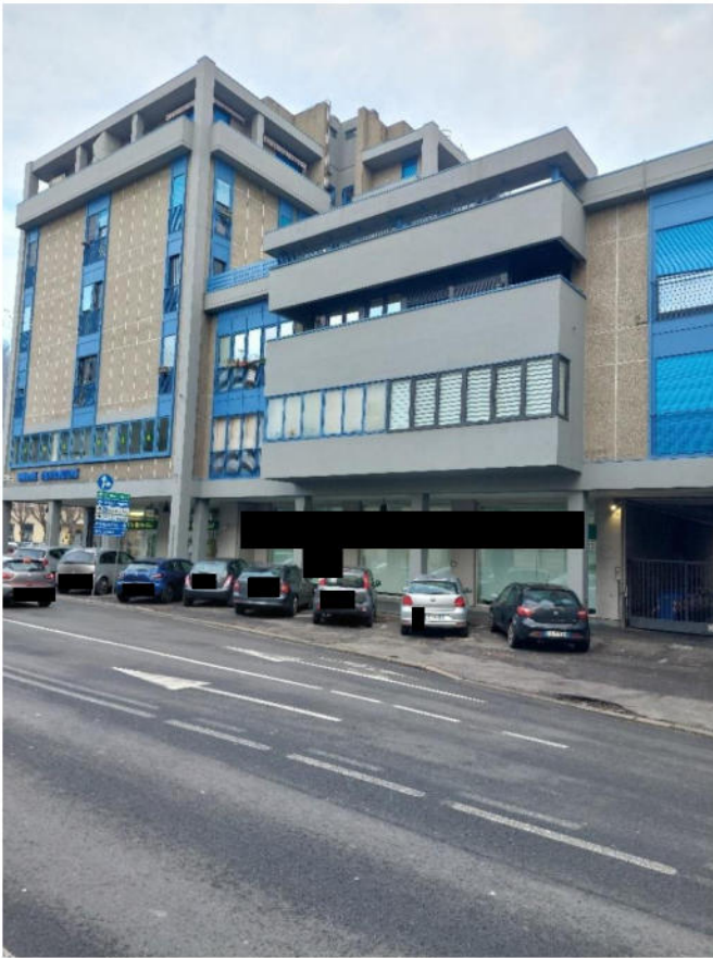
Figura 3 - Prospetto ovest dell'edificio con vista del porticato
