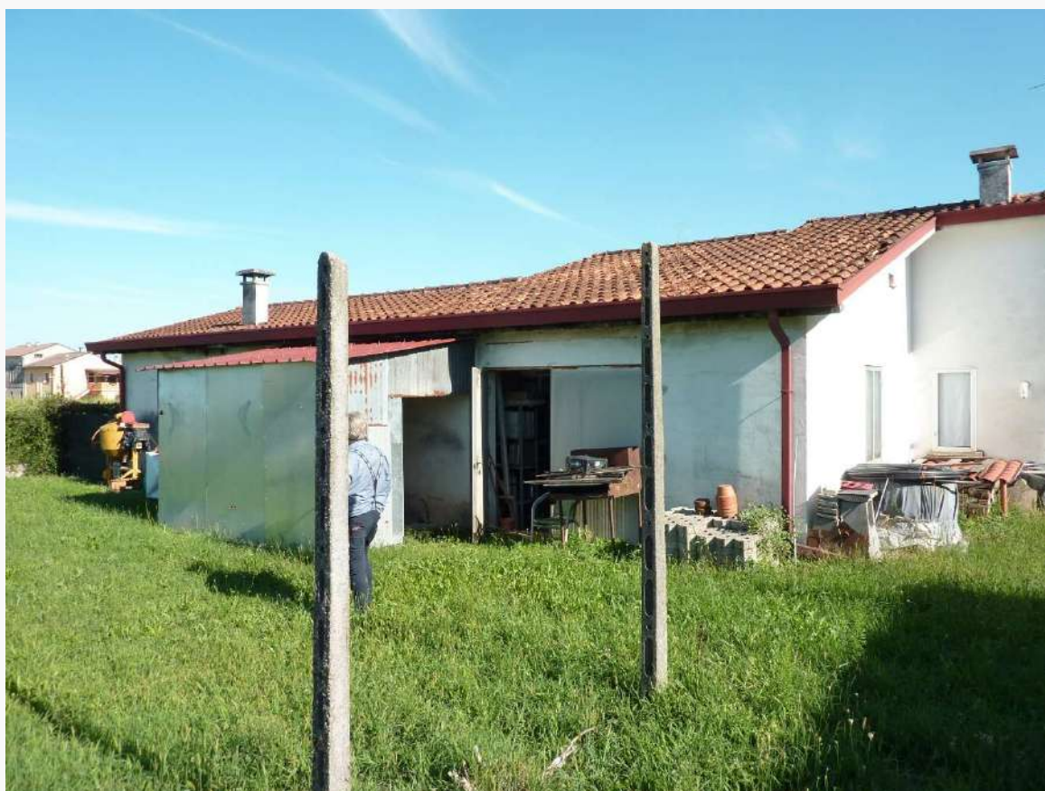
FOTO 18 _ DETTAGLIO RETRO DEL COMPLESSO IMMOBILIARE – PROSPETTO NORD
