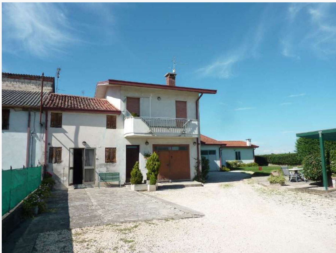
FOTO 6 _ DETAGLIO FRONTE PRINCIPALE DEL COMPLESSO DALLA CORTE PERTINENZIALE - PROSPETTO SUD
