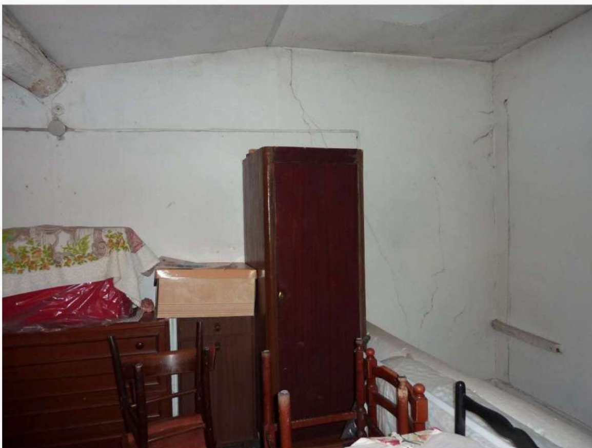
FOTO 11 _ VISTA INTERNA – CAMERA 01 APPARTAMENTO SUB 5 – PIANO PRIMO
