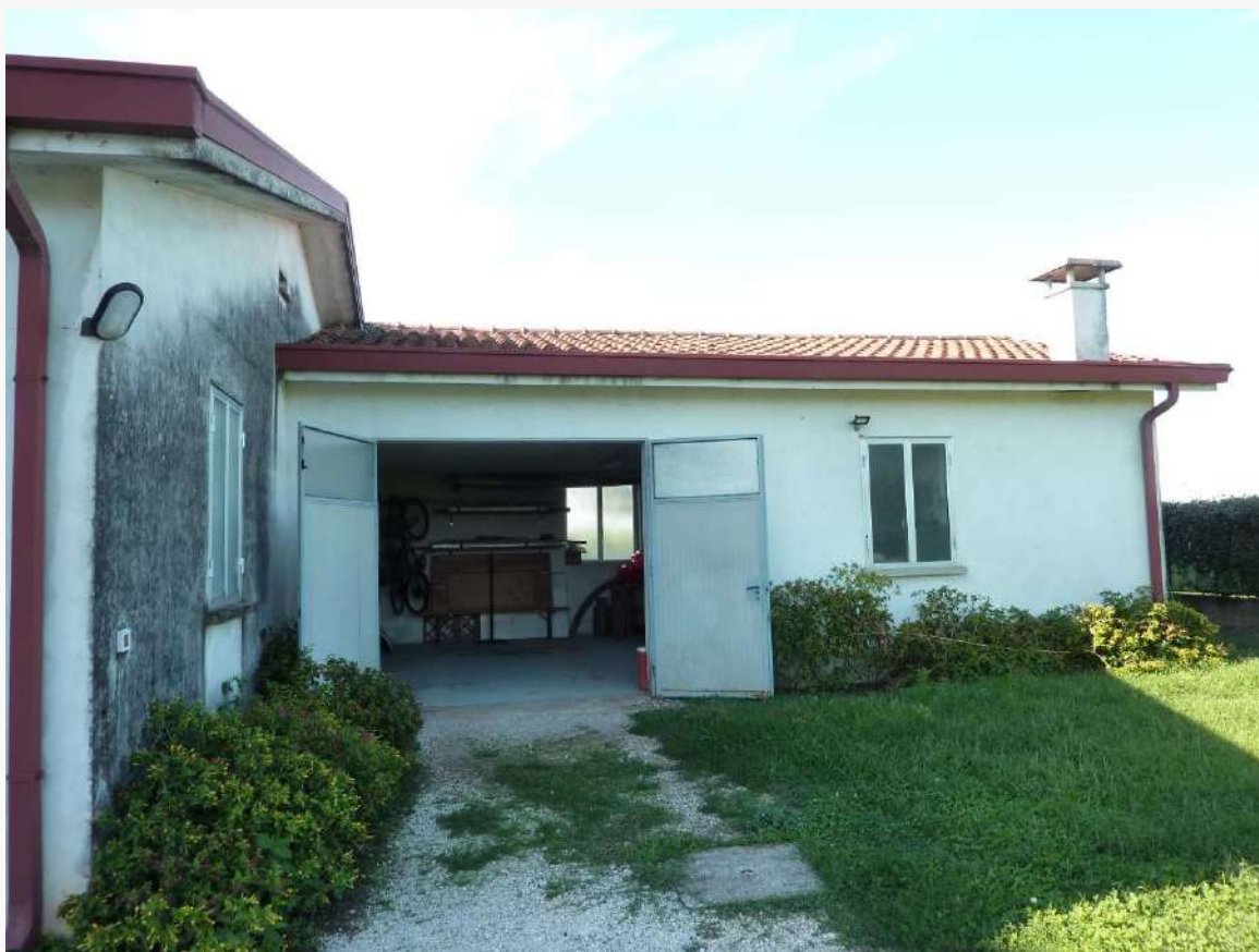
FOTO 13 _ DETTAGLIO FRONTE SUD DELL'IMMOBILE SUB 8 DALL'AREA ESTERNA PERTINENZIALE ESCLUSIVA
