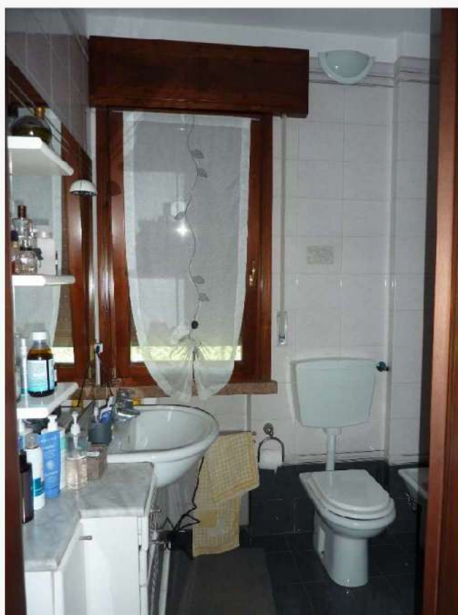
FOTO 26 _ VISTA INTERNA – BAGNO APPARTAMENTO SUB 6 – PIANO PRIMO
