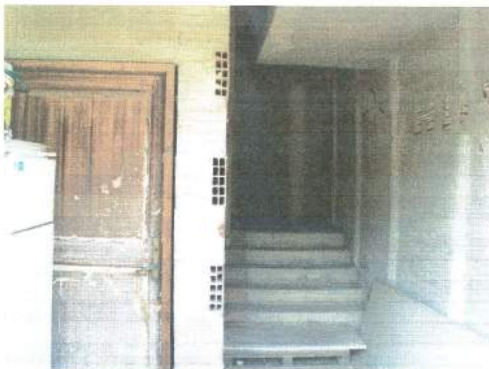
Figura 26 ingresso corpo scala
