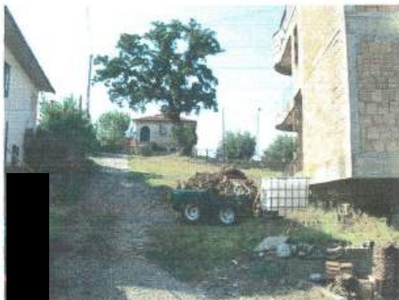
Figura 1 accesso al fabbricato
