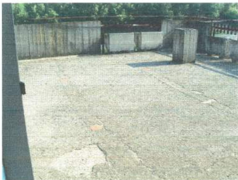
Figura 23 terrazzo adiacente locale sottotetto
