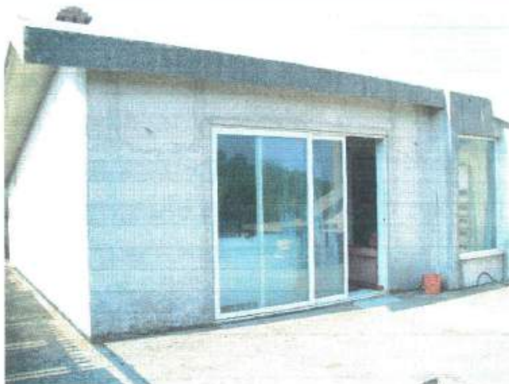
Figura 16 vista locale al sottotetto adibito ad abitazione
