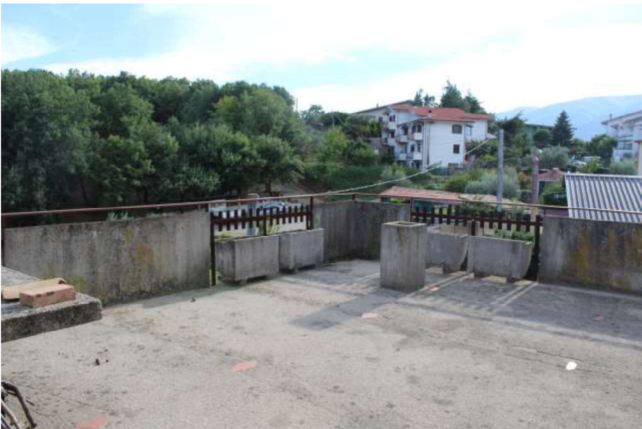
vista terrazzo piano sottotetto
