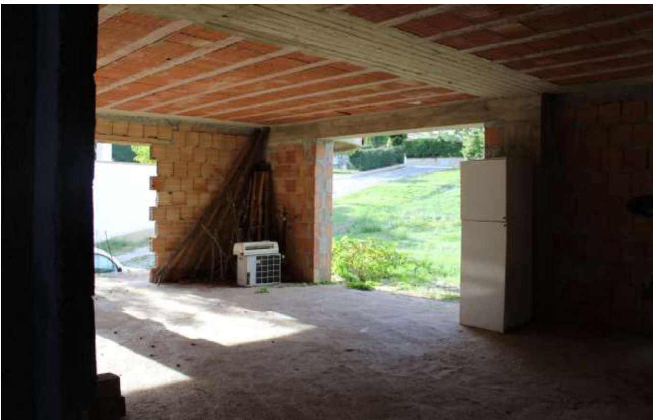
vista stato piano terra
