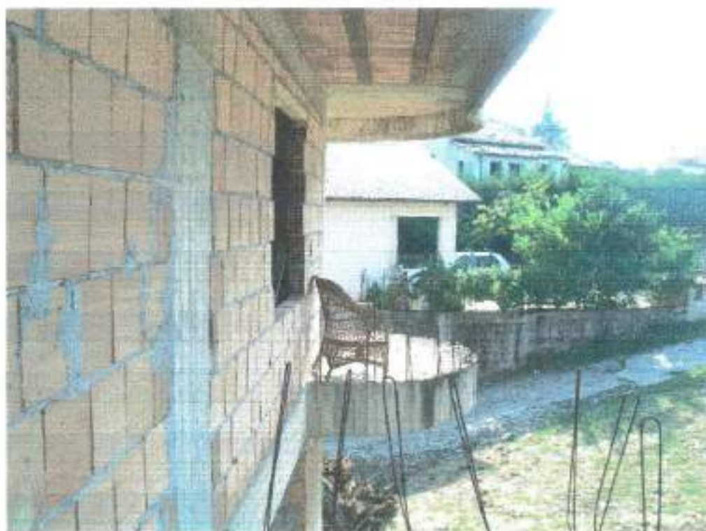
Figura 11 vista esterna sub 11
