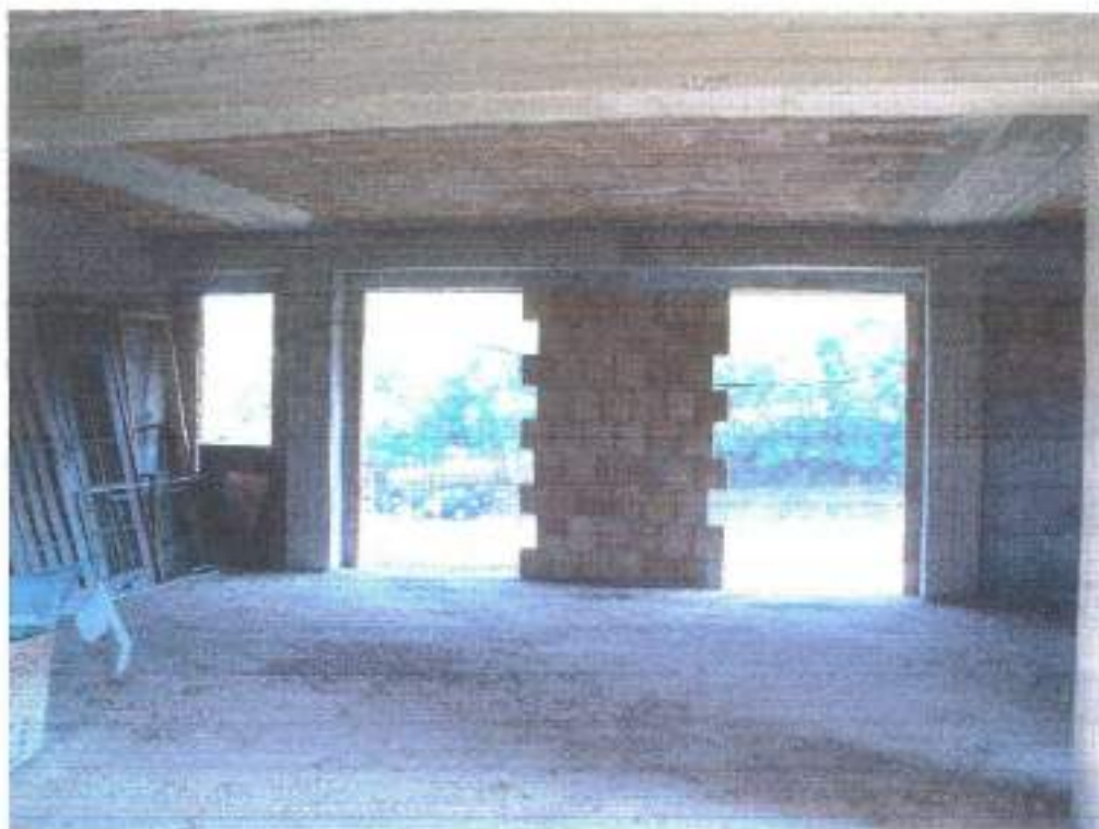
Figura 10 vista interna sub 11
