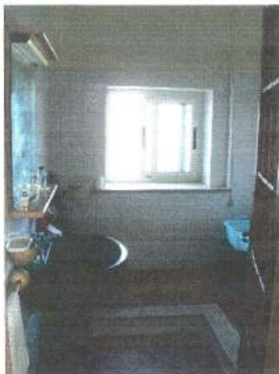
Figura 20 servizio igienico locale sottotetto
