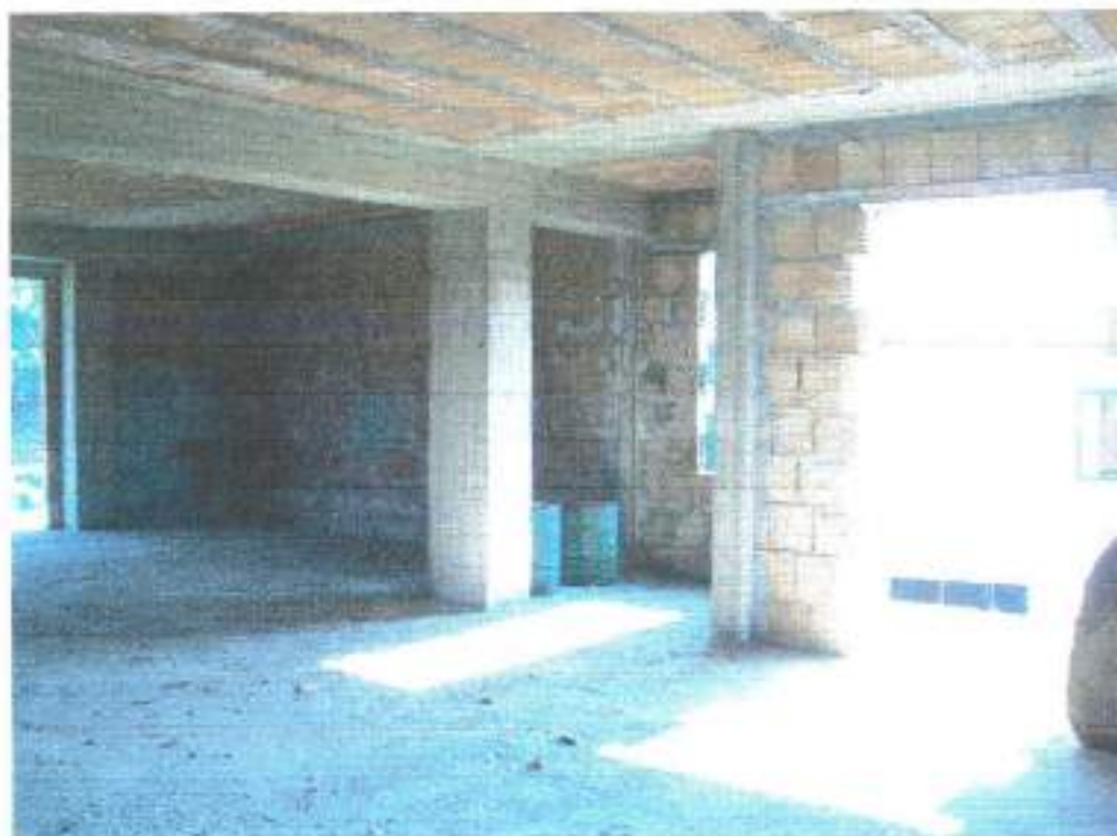
Figura 9 vista interna sub 11
