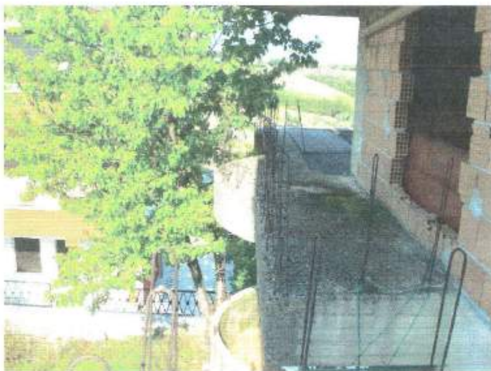
Figura 12 vista esterna sub 12
