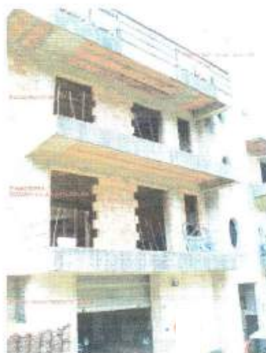
Figura 5 prospetto Sud: ingresso al magazzino
