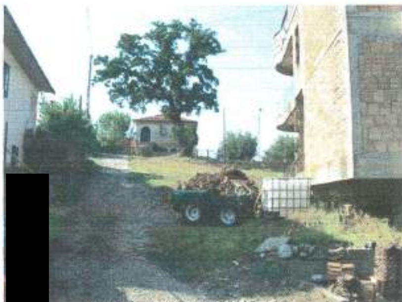
Figura 1 accesso al fabbricato
