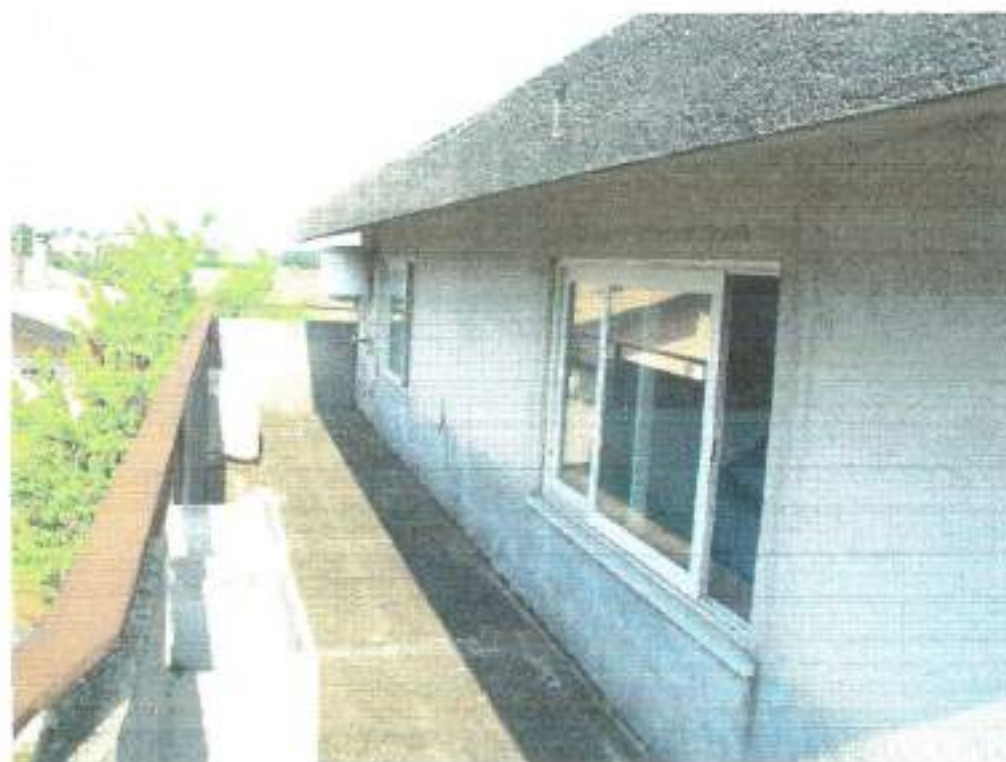
Figura 17 vista laterale locale sottotetto
