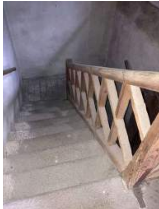
SCALE DI COLLEGAMENTO AL PRIMO PIANO
