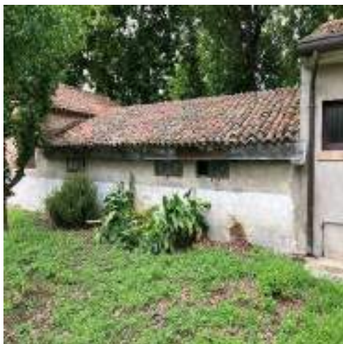
DEPOSITI PERTINENTI ALL'ABITAZIONE SUB.2 – VISTA DAL MAPPALE 1028
