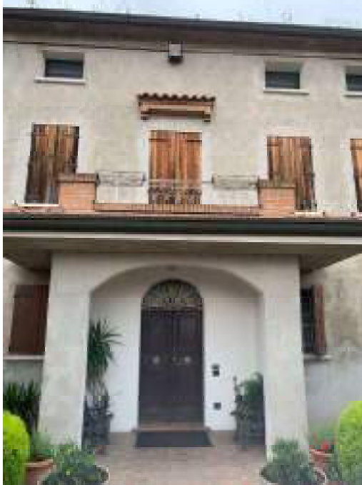
INGRESSO ALL'ABITAZIONE DALLA CORTE COMUNE
