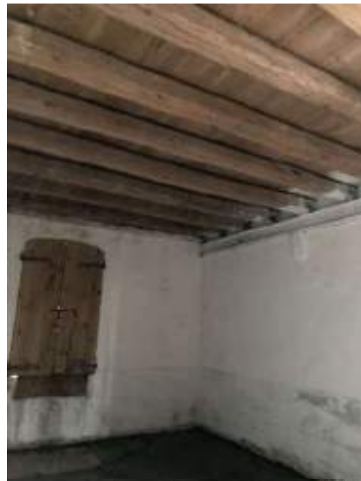
LOCALE DEPOSITO PIANO PRIMO
