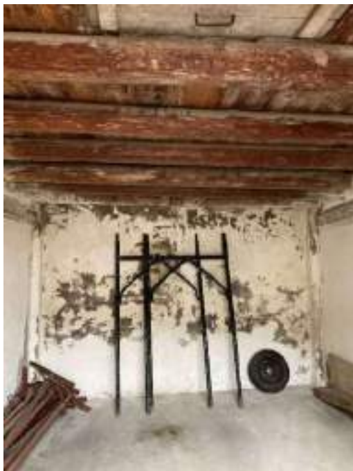
BOX AUTO PIANO TERRA- DEPOSITO
