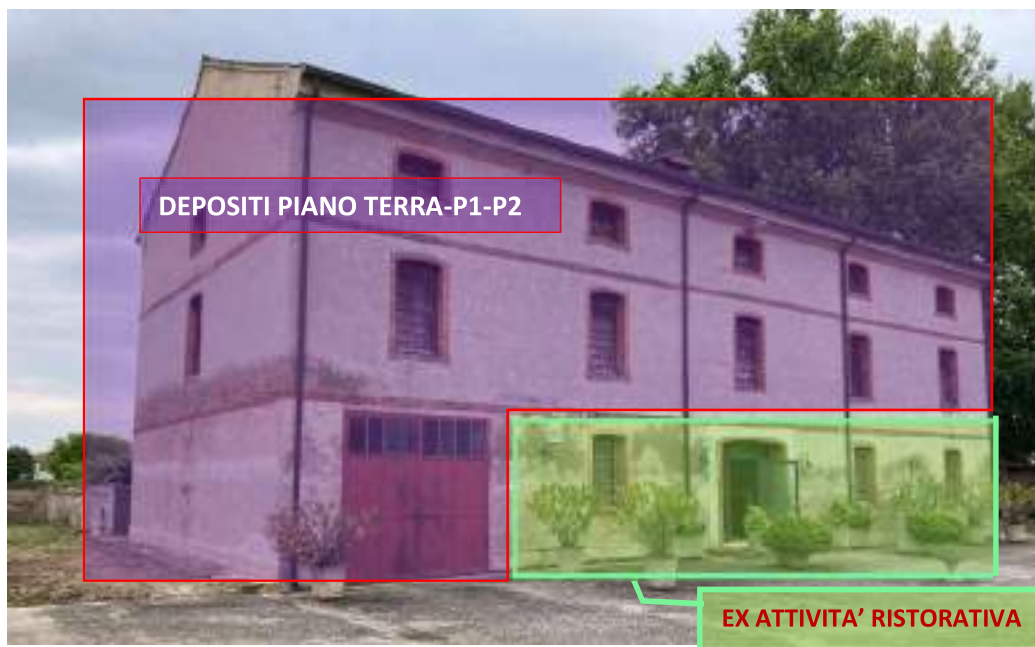
VISTA ESTERNA SUL SUB 8 DEL MAPPALE 1044
