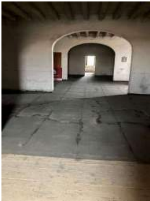
LOCALE DEPOSITO PIANO PRIMO
