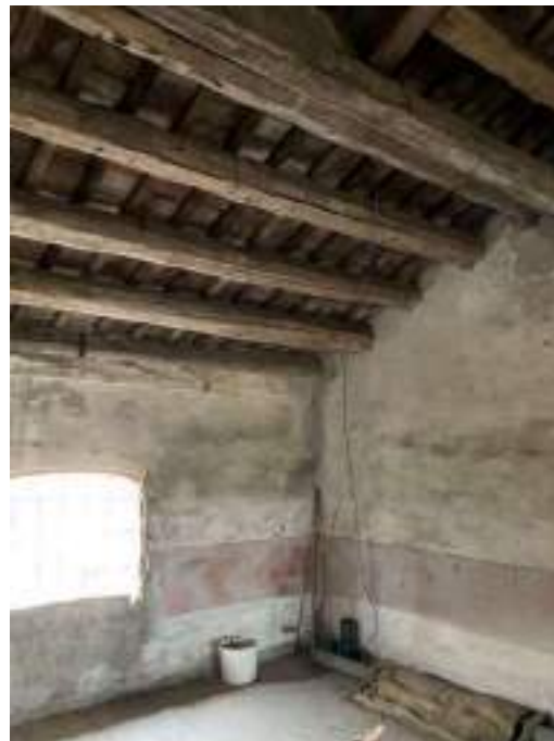
LOCALE DEPOSITO PIANO SECONDO
