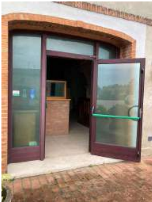
INGRESSO AL SUB. 4
