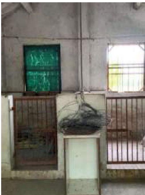
LEGNAIA SUB.2 – NON RISTRUTTURATA
