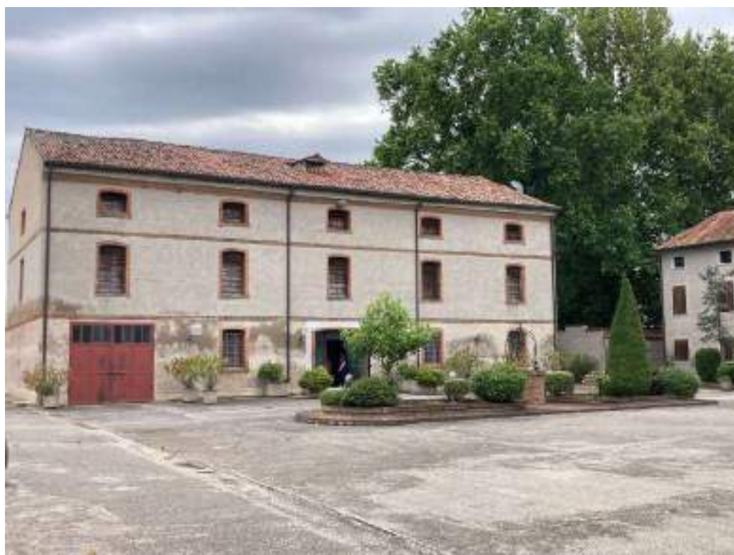
VISTA ESTERNA SUL SUB 8 DEL MAPPALE 1044 E L'ANTISTANTE SPAZIO DI MANOVRA/PARCHEGGIO
