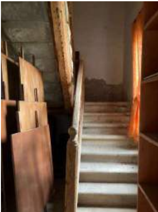
SCALE DI COLLEGAMENTO AL PRIMO PIANO
