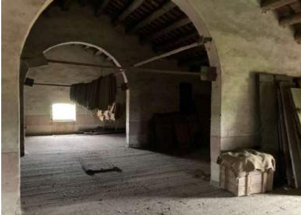
LOCALE DEPOSITO PIANO SECONDO
