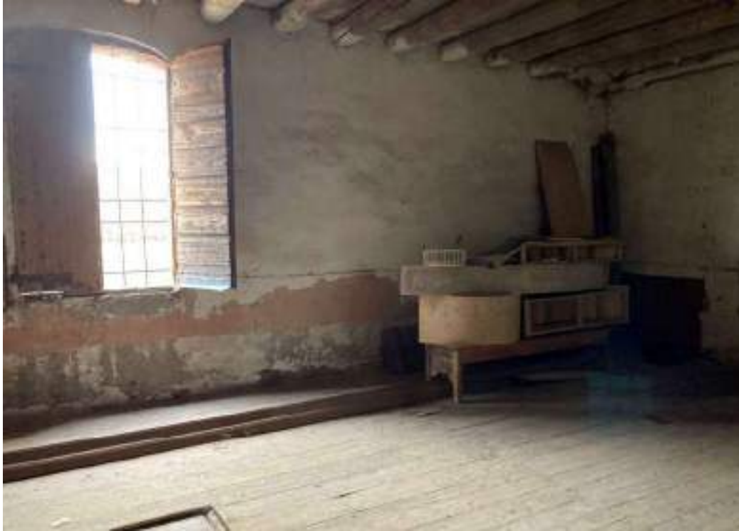
LOCALE DEPOSITO PIANO PRIMO – SOLAIO IN LEGNO
