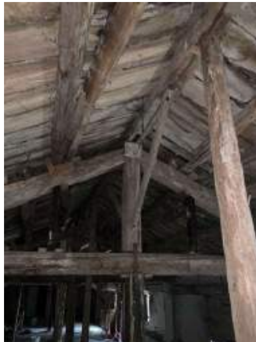
DEPOSITO P1 – DETTAGLIO COPERTURA
