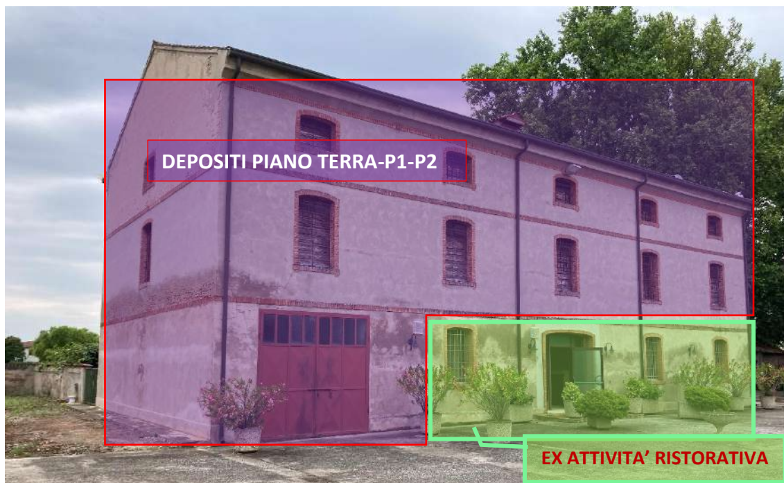
VISTA ESTERNA SUI SUB 18 E 19 DEL MAPPALE 1044
