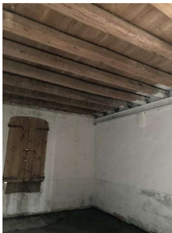
LOCALE DEPOSITO PIANO PRIMO – SUB.18
