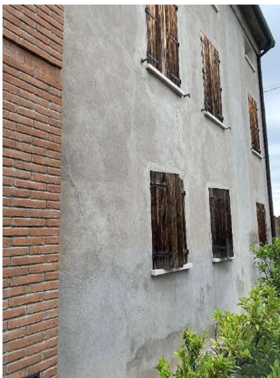
VISTA ESTERNO DELL'ABITAZIONE LATO CORTILE P1-2
