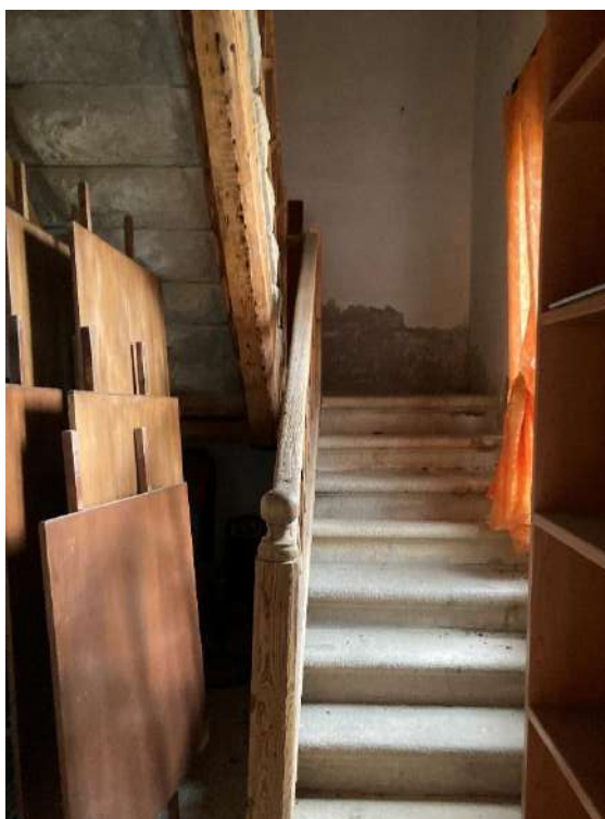
SCALE DI COLLEGAMENTO AL PRIMO PIANO (SUB.18)
