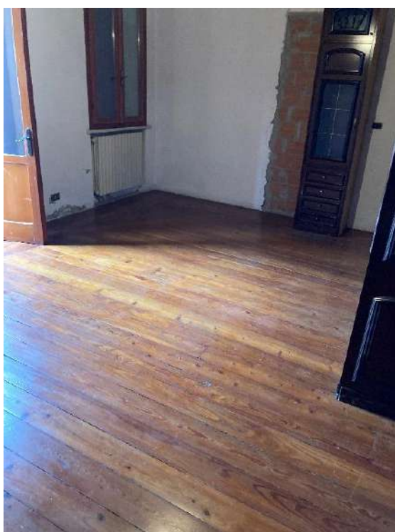
LOCALE NON COMPLETAMENTE RIFINITO P1
