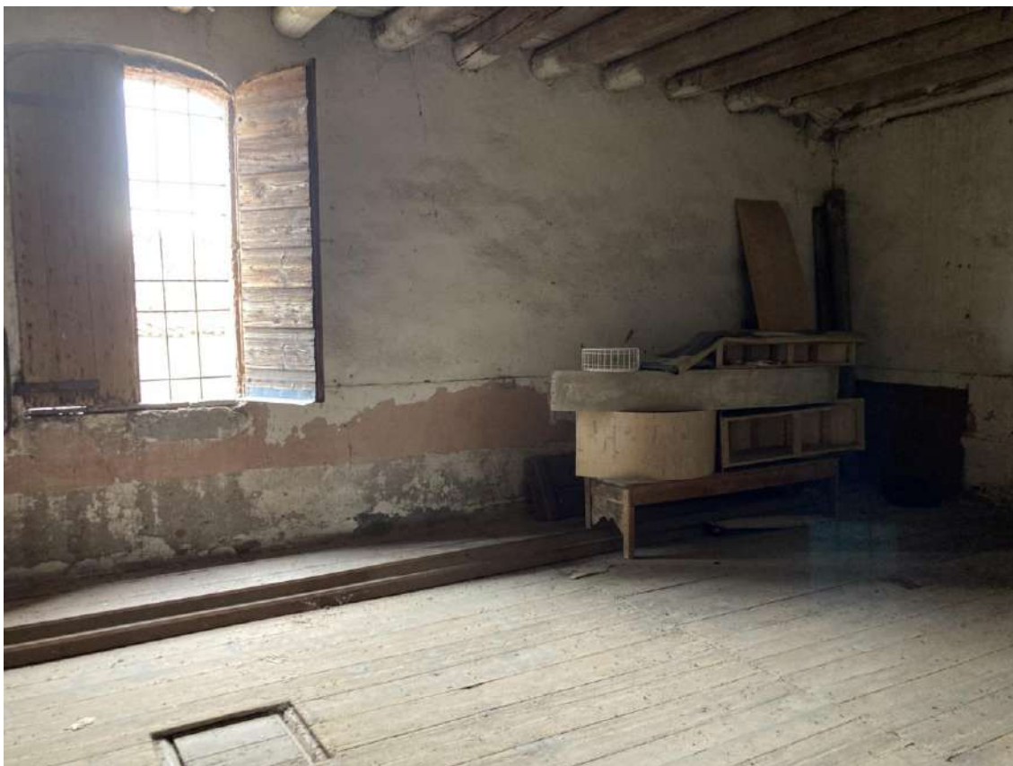
LOCALE DEPOSITO PIANO PRIMO – SOLAIO IN LEGNO
