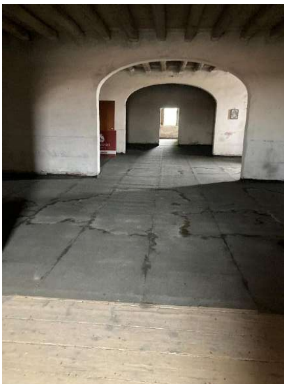
LOCALE DEPOSITO PIANO PRIMO – SUB.18
