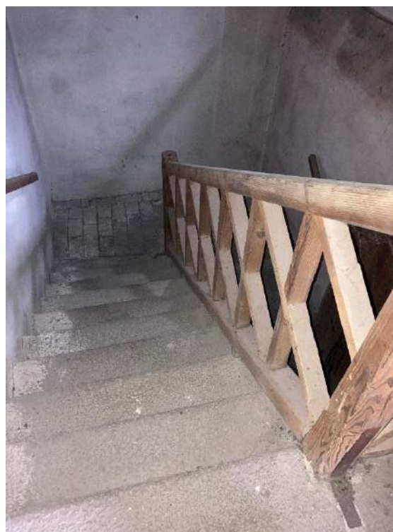
SCALE DI COLLEGAMENTO AL PRIMO PIANO (SUB.18)
