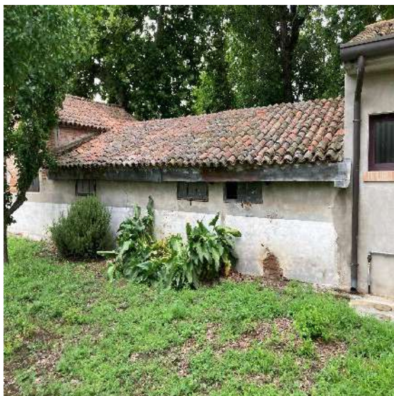
DEPOSITI PERTINENTI ALL'ABITAZIONE SUB.2 – VISTA DAL MAPPALE 1028
