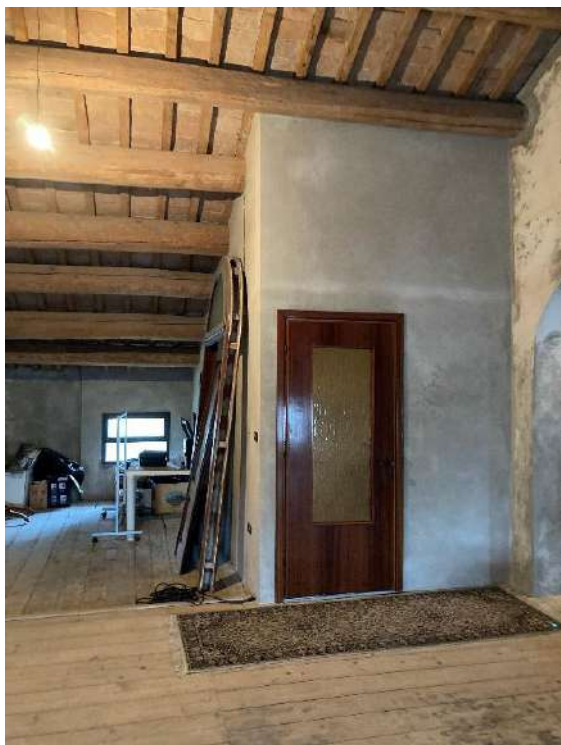
ZONA DI ACCESSO DALLA SCALA AL SOTTOTETTO
