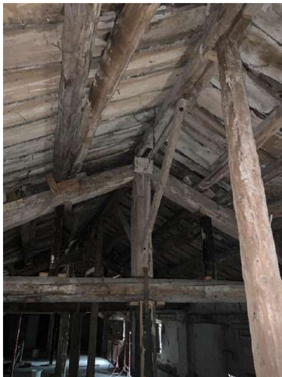
DEPOSITO P1 – DETTAGLIO COPERTURA
