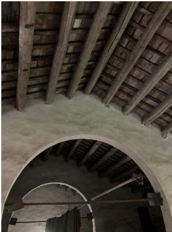
COPERTURA PIANO SECONDO – SUB.18
