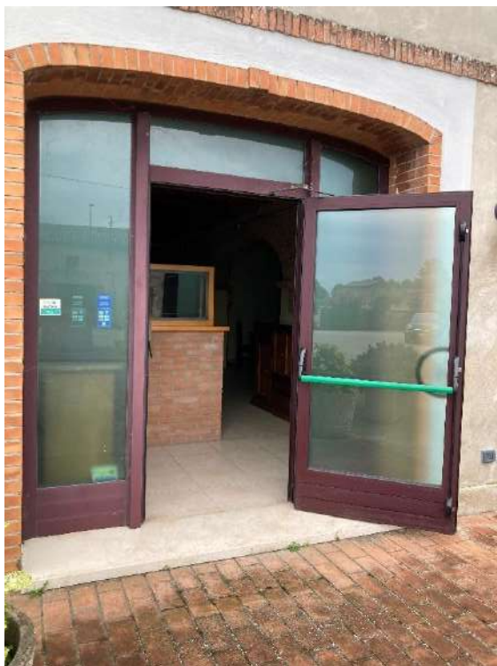
INGRESSO AL SUB. 18
