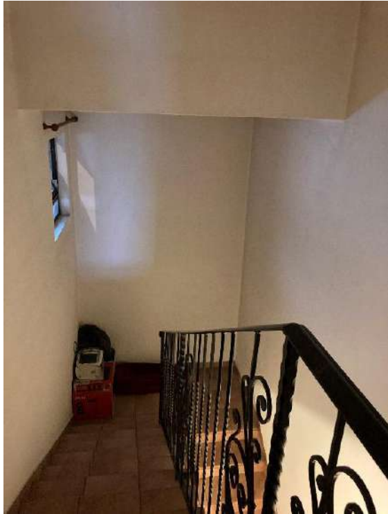
VISTA SULLE SCALE - PIANEROTTOLO DEL PIANO 2
