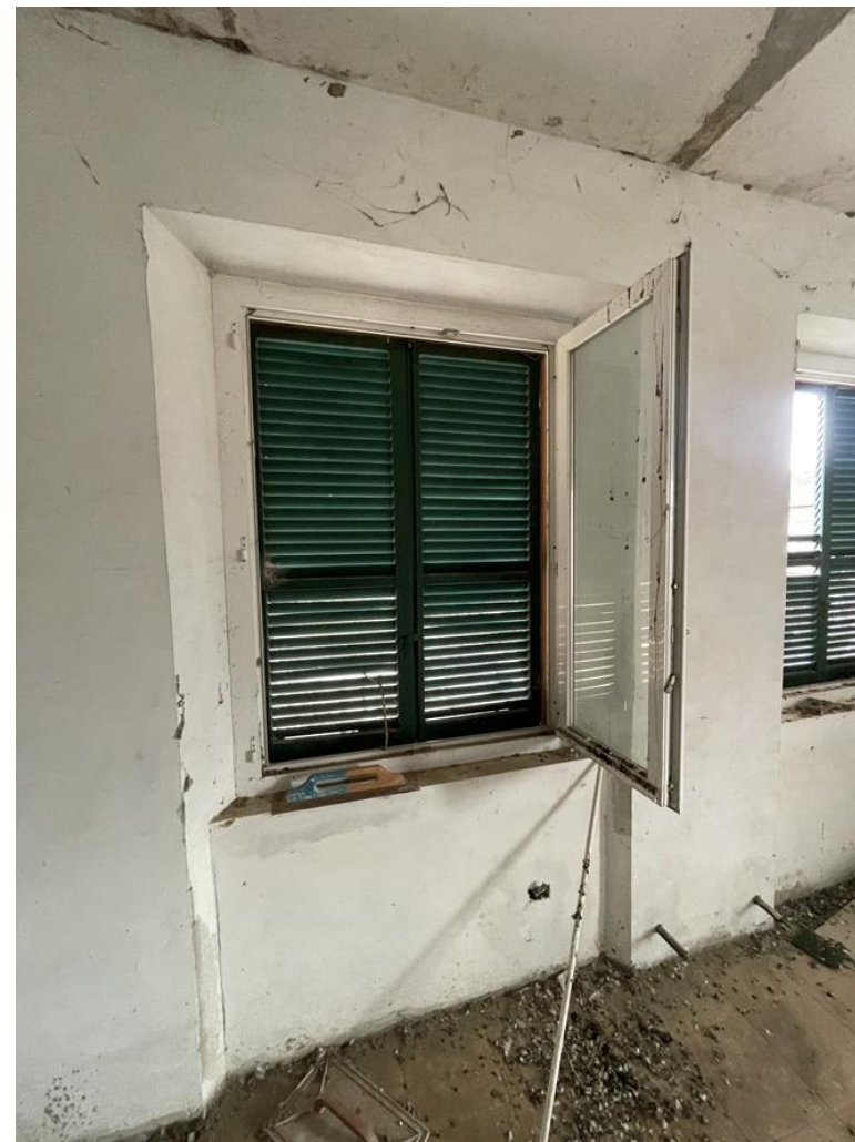
25) C.F. Fg.23 p.IIa 3469 sub.6 – Particolare degli infissi esterni e delle persiane (zona giorno)
