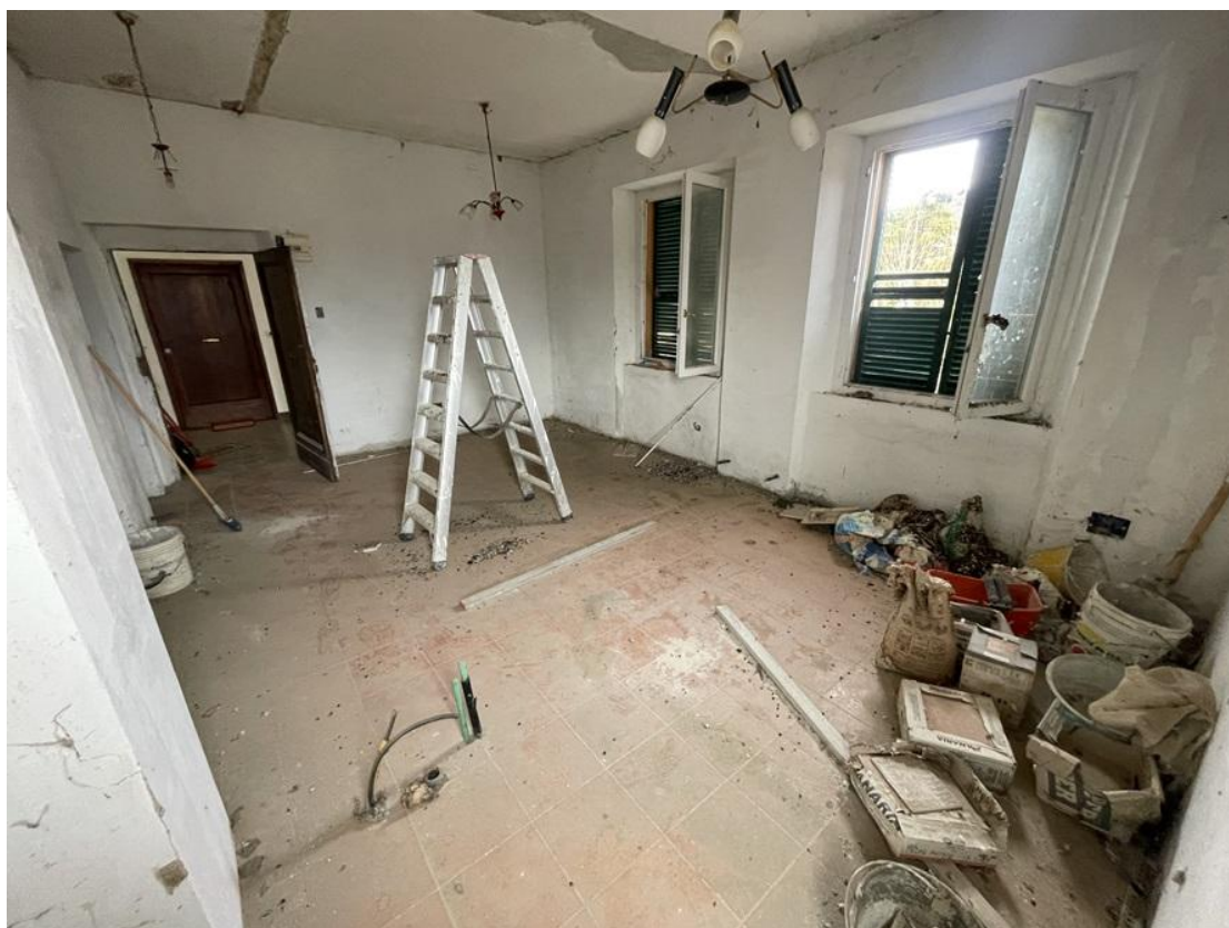
12) C.F. Fg.23 p.Ila 3469 sub.6 – Particolare dei locali cucina-soggiorno
