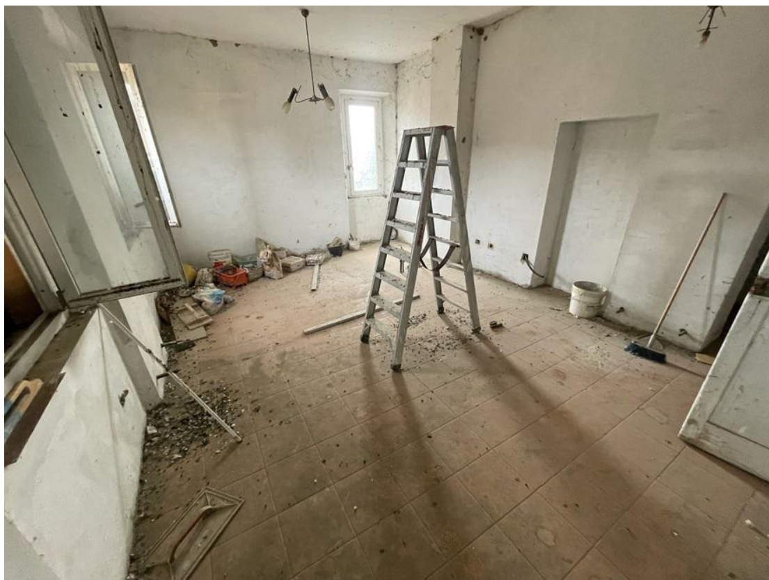
11) C.F. Fg.23 p.Ila 3469 sub.6 – Particolare dei locali cucina-soggiorno
