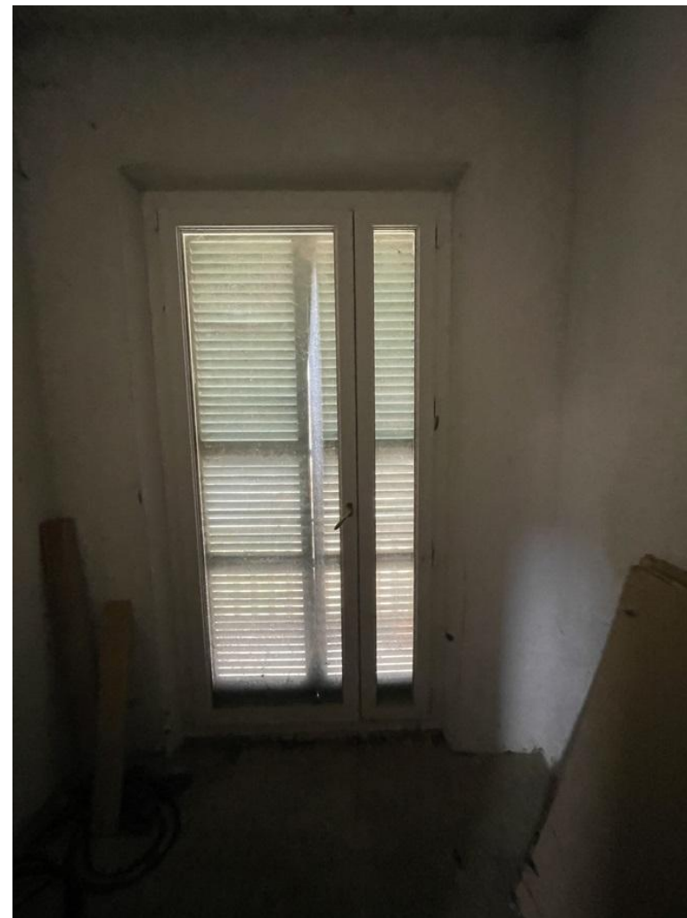
27) C.F. Fg.23 p.IIa 3469 sub.6 – Particolare degli infissi esterni e delle persiane (reparto notte)
