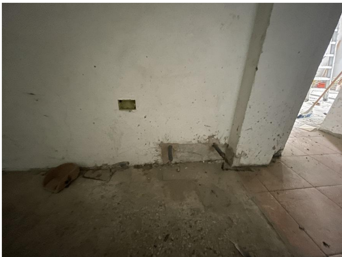
36) Particolare delle opere edili e degli impianti a servizio dell'appartamento da completare
