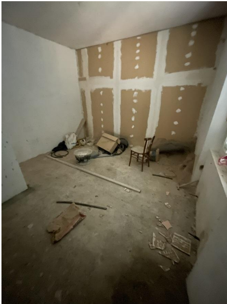
14) C.F. Fg.23 p.Ila 3469 sub.6 – Particolare della camera da letto principale posta a sud-ovest
