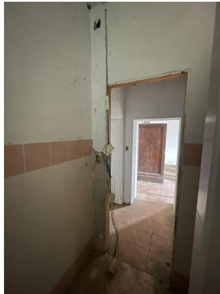
35) C.F. Fg.23 p.IIIa 3469 sub.6 – Particolare delle opere edili e degli impianti a servizio dell'appartamento da completare
