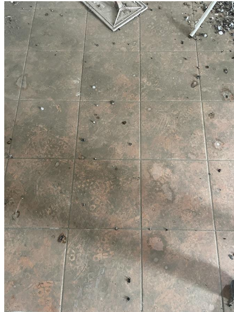
21) C.F. Fg.23 p.Ila 3469 sub.6 – Particolare della pavimentazione dei locali cucina-soggiorno
