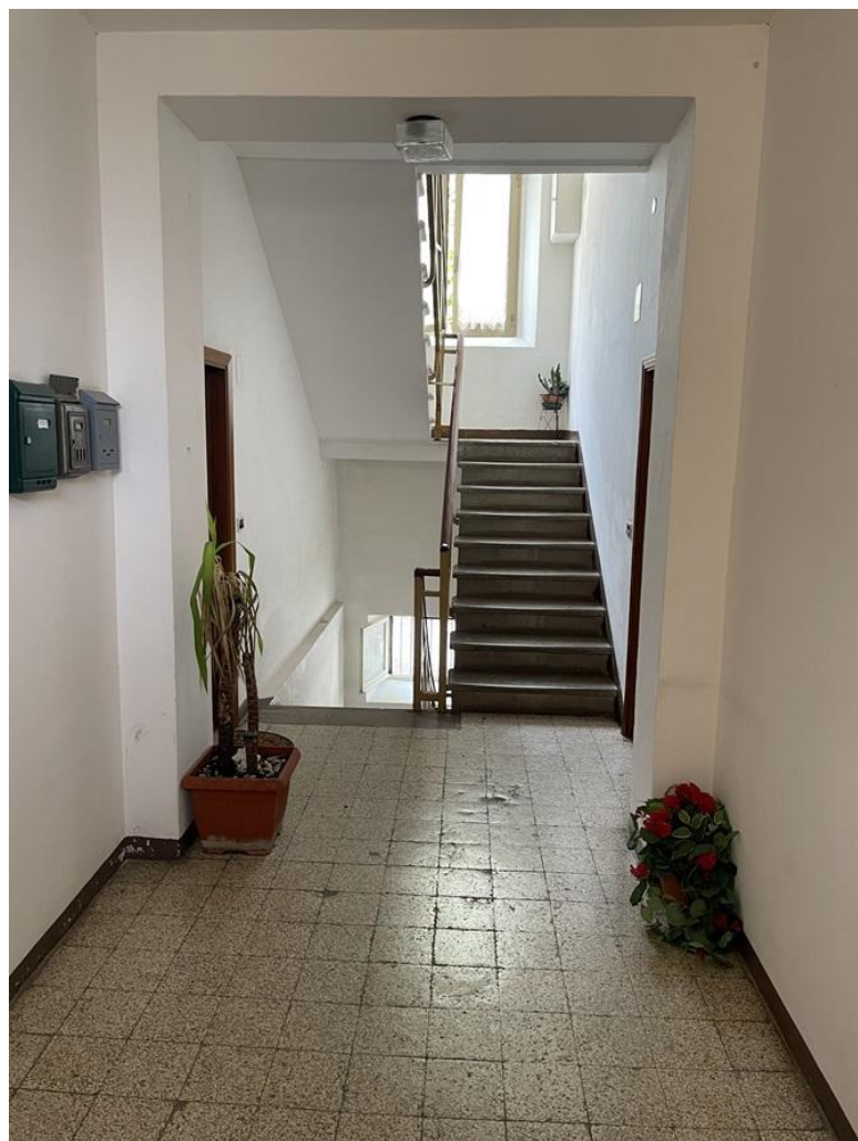
42) C.F. Fg.23 p.IIa 3469 sub.6 – Particolare del vano scala comune che permette il raggiungimento del locale cantina oggetto di stima posto al piano seminterrato
