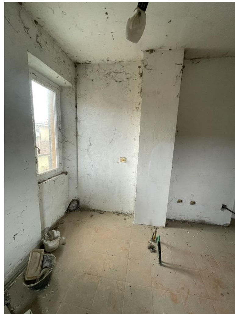
31) C.F. Fg.23 p.IIIa 3469 sub.6 – Particolare delle opere edili e degli impianti a servizio dell'appartamento da completare
