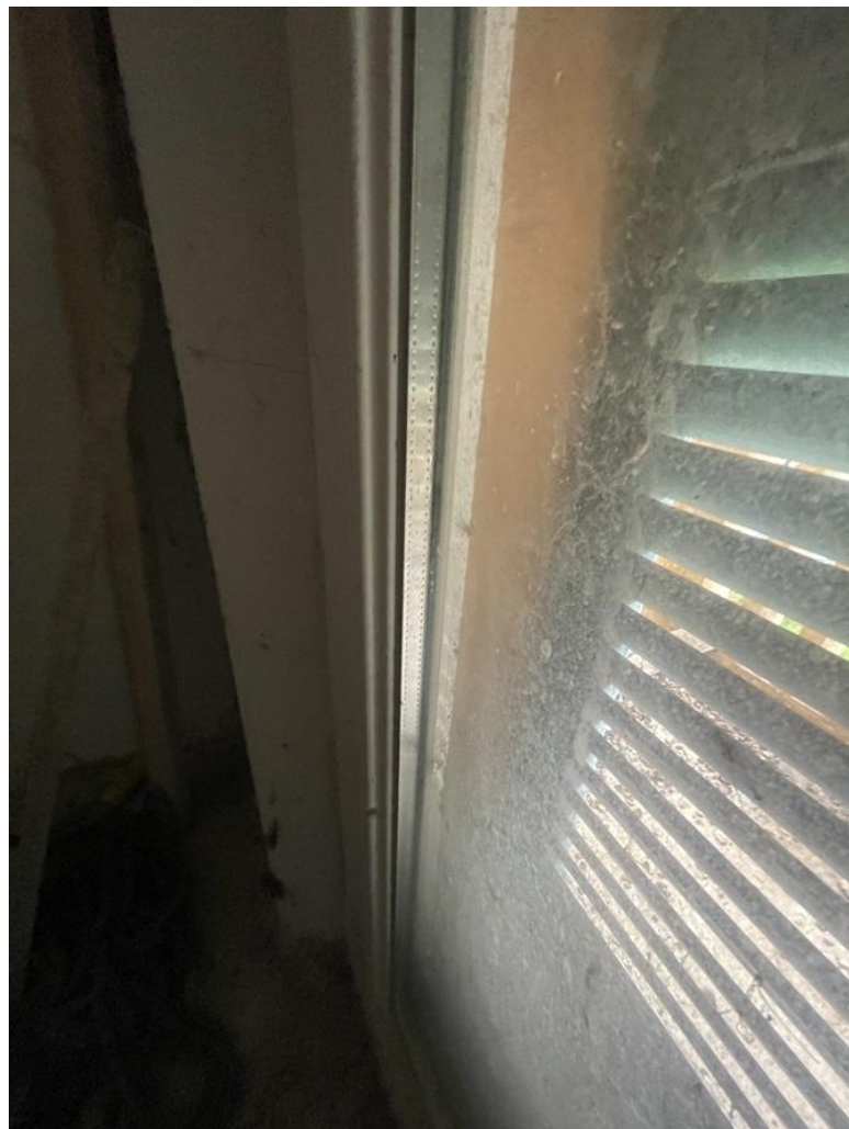
28) C.F. Fg.23 p.IIa 3469 sub.6 – Particolare degli infissi esterni e delle persiane (reparto notte)
