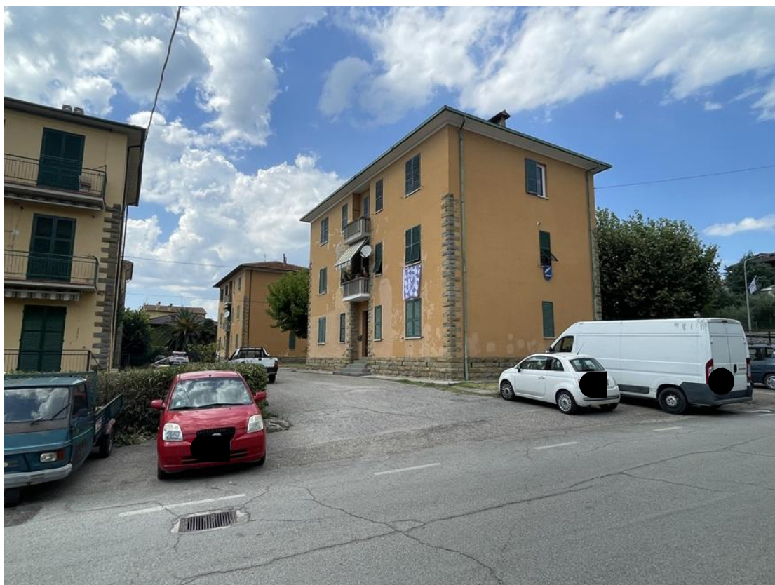
1) C.F. Fg. 23 p.Ila 3469 sub.6 – Vista generale del complesso immobiliare di cui fanno parte i beni oggetto di stima
