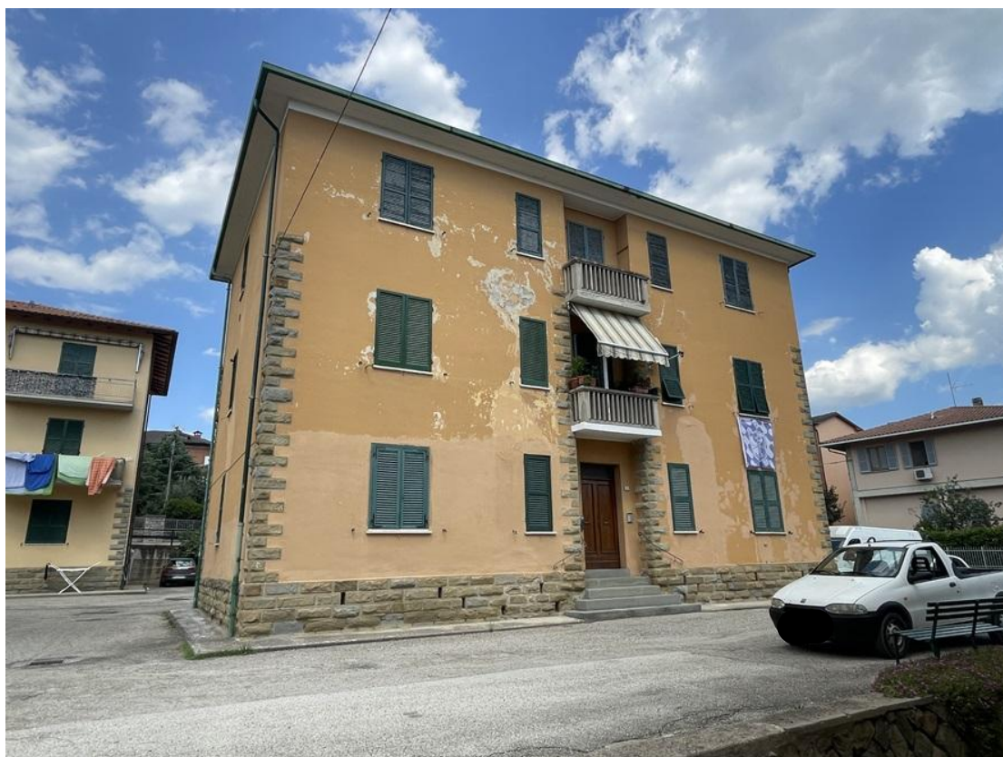
2) C.F. Fg. 23 p.Ila 3469 sub.6 - Vista generale del complesso immobiliare di cui fanno parte i beni oggetto di stima
