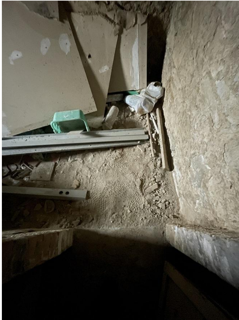
48) C.F. Fg.23 p.Ila 3469 sub.6 – Particolare della pavimentazione della cantina oggetto di stima ubicata al piano
