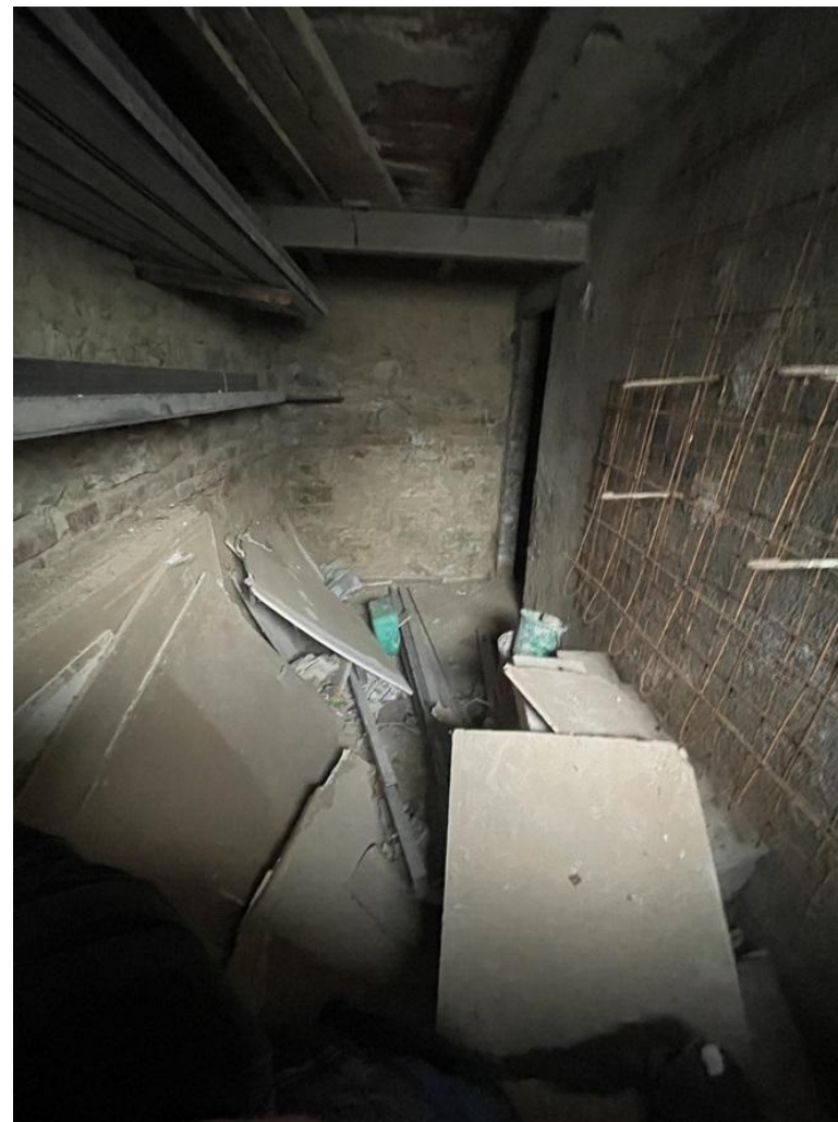
47) C.F. Fg.23 p.IIIa 3469 sub.6 – Particolare della pavimentazione della cantina oggetto di stima ubicata al piano seminterrato
