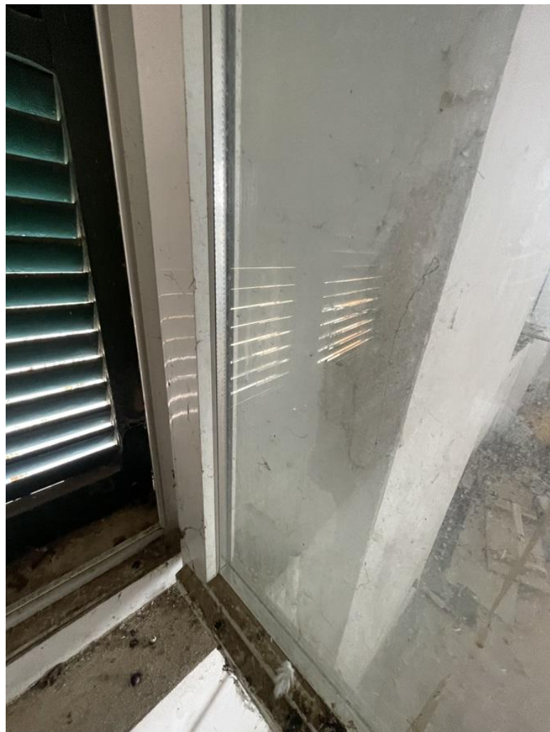
26) C.F. Fg.23 p.IIa 3469 sub.6 – Particolare degli infissi esterni e delle persiane (zona giorno)
