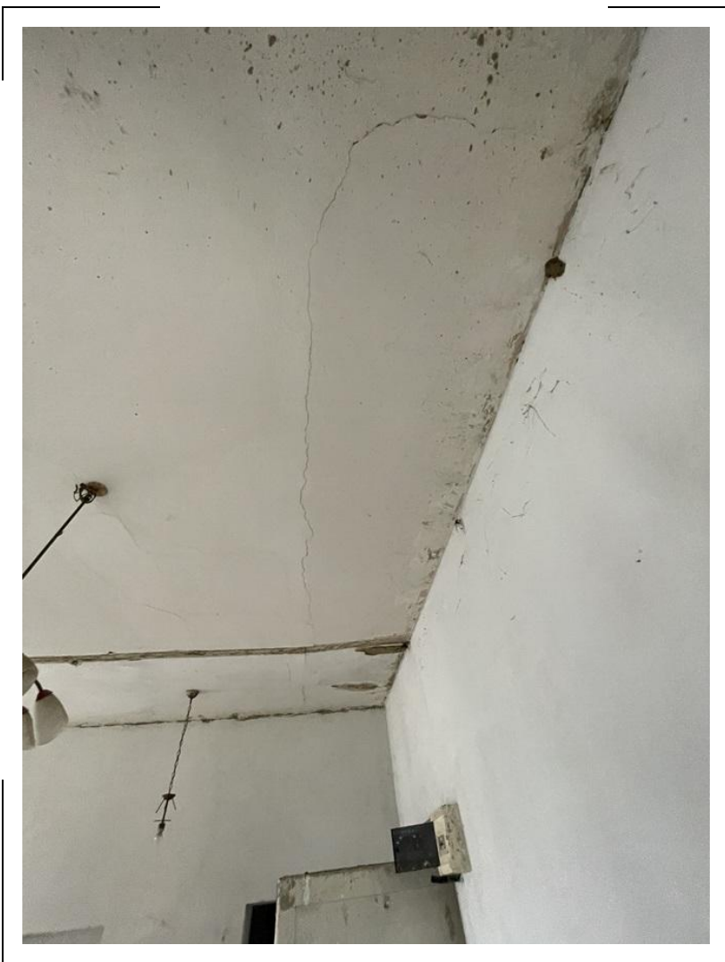
32) C.F. Fg.23 p.Ila 3469 sub.6 – Particolare delle opere edili e degli impianti a servizio dell'appartamento da completare
