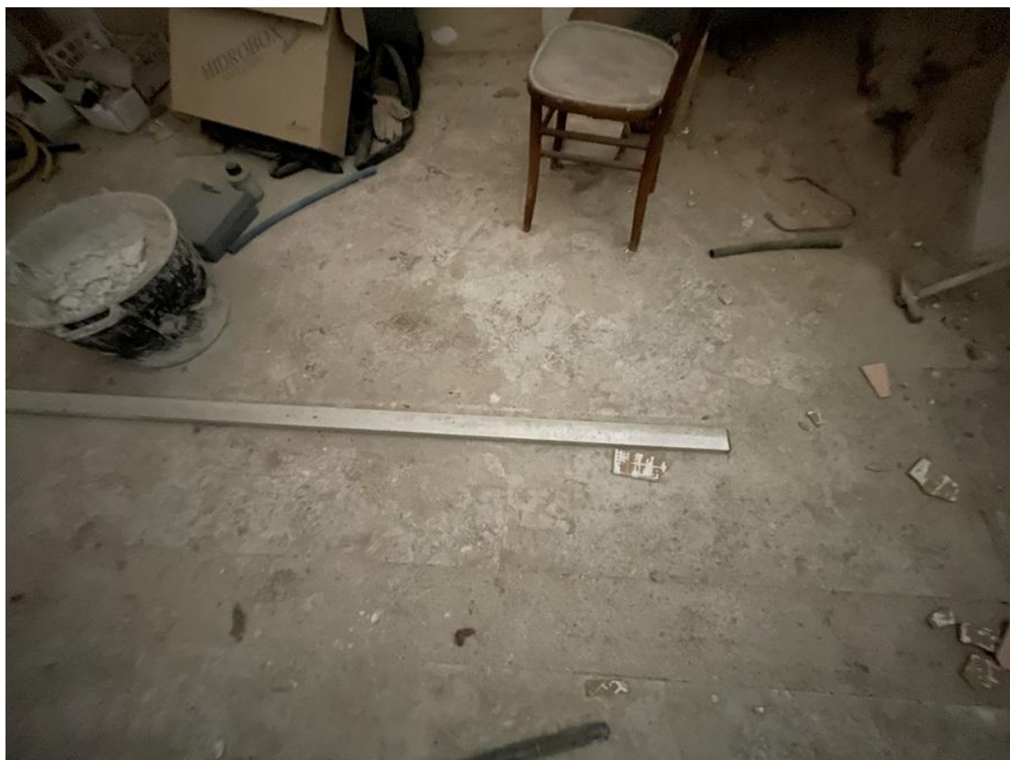
37) C.F. Fg.23 p.IIa 3469 sub.6 – Particolare delle opere edili e degli impianti a servizio dell'appartamento da completare
