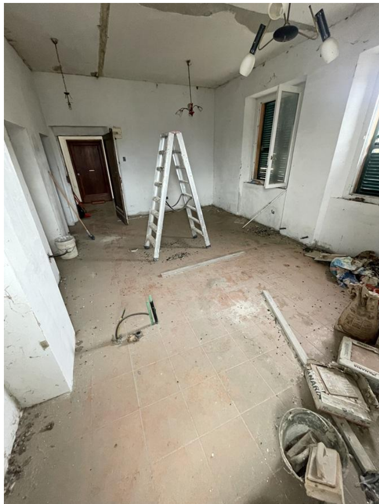
30) C.F. Fg.23 p.IIIa 3469 sub.6 – Particolare delle opere edili e degli impianti a servizio dell'appartamento da completare
