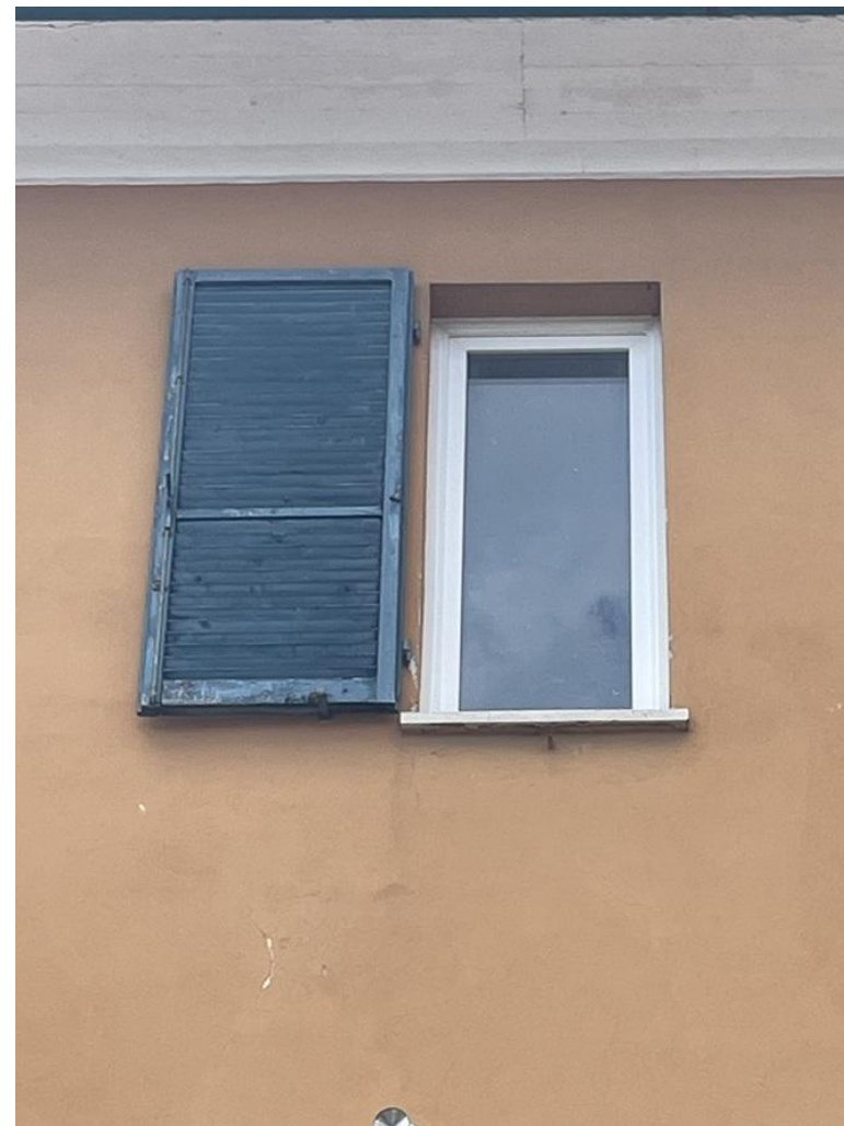
29) C.F. Fg.23 p.IIa 3469 sub.6 – Particolare delle opere edili e degli impianti a servizio dell'appartamento da completare
