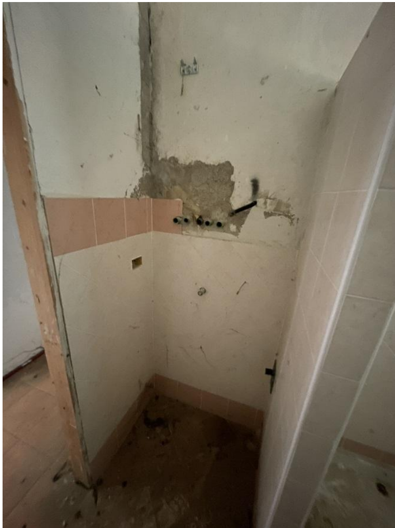
18) C.F. Fg.23 p.la 3469 sub.6 – Particolare del w.c.
