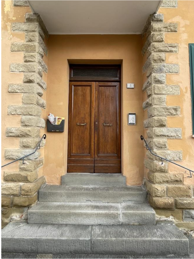
6) C.F. NCEU Fg.23 p.lla 3469 sub.6 – Particolare della porta d'ingresso ad uso comune, che permette attraverso il vano scala condominiale il raggiungimento dei beni oggetto di stima
