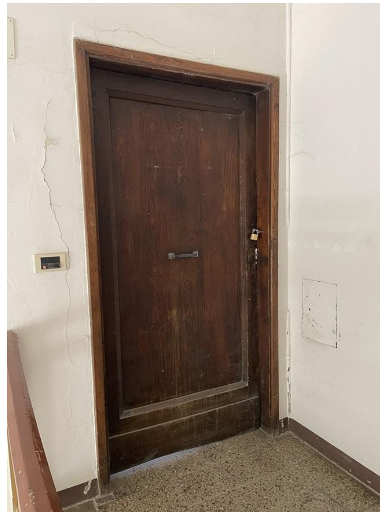
9) C.F. Fg.23 p.lla 3469 sub.6 – Particolare della porta d'ingresso, che permette l'accesso all'appartamento oggetto di stima posto al piano secondo
