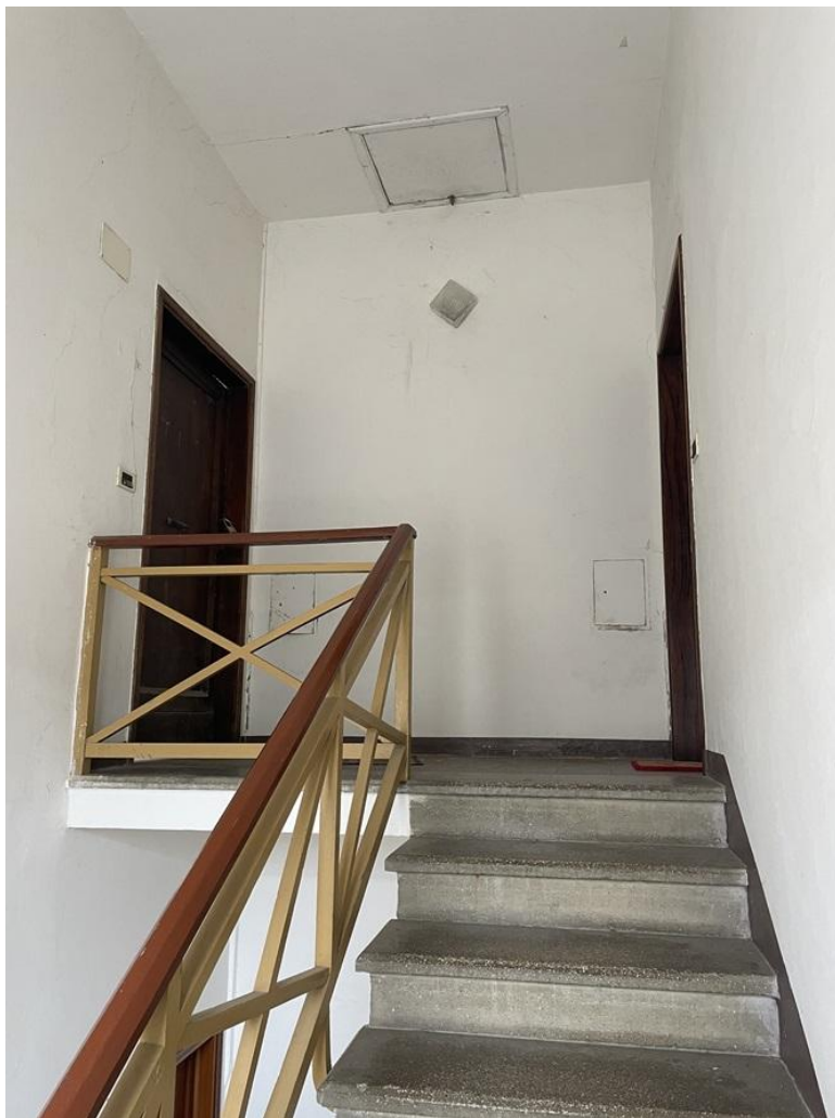
8) C.F. Fg.23 p.lla 3469 sub.6 – Particolare del vano scala ad uso comune, che permette il raggiungimento dei beni oggetto di stima
