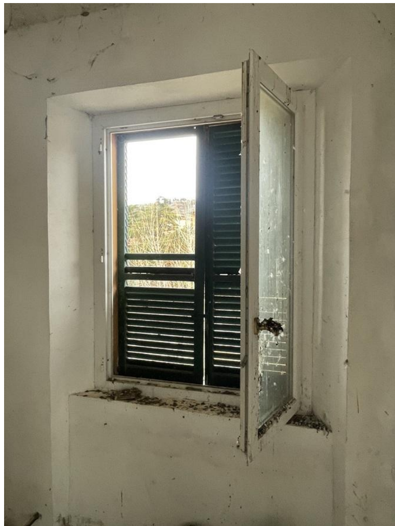
24) C.F. Fg.23 p.IIa 3469 sub.6 – Particolare degli infissi esterni e delle persiane (zona giorno)
