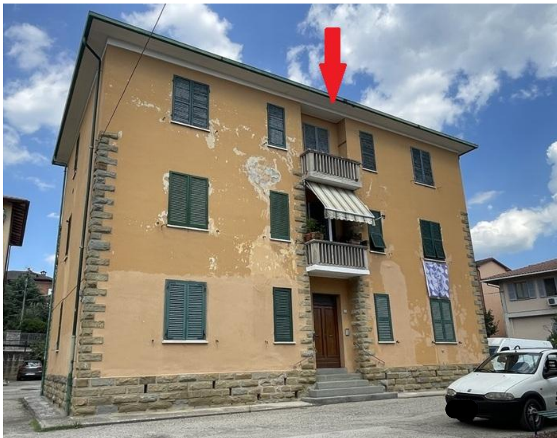
41) C.F. Fg.23 p.IIa 3469 sub.6 - Particolare del balcone ad uso esclusivo dell'appartamento oggetto di stima
