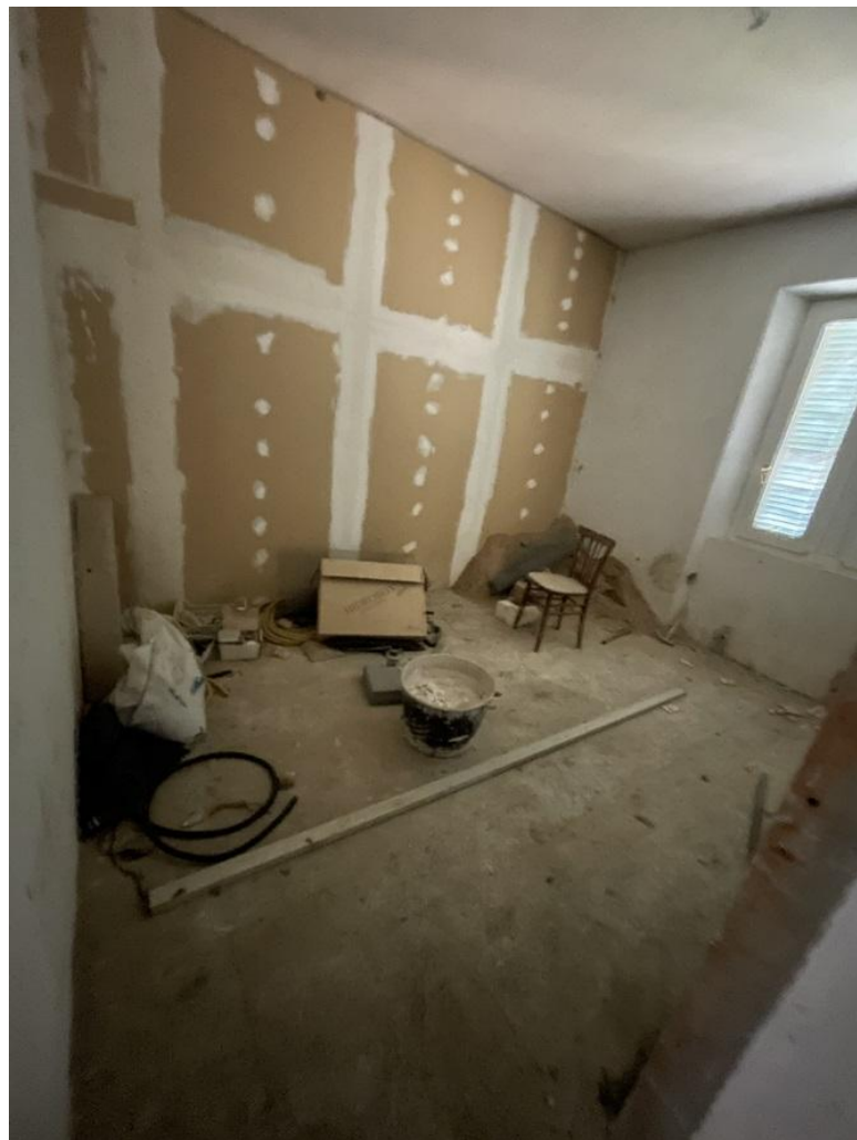
34) C.F. Fg.23 p.IIIa 3469 sub.6 – Particolare delle opere edili e degli impianti a servizio dell'appartamento da completare
