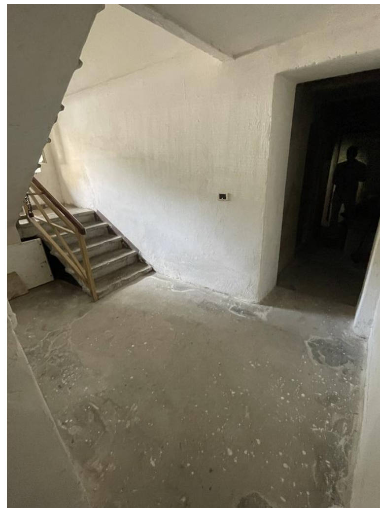
43) C.F. Fg.23 p.IIa 3469 sub.6 – Particolare del vano scala comune che permette il raggiungimento del locale cantina oggetto di stima posto al piano seminterrato
