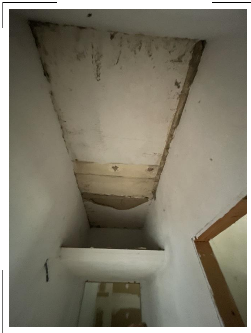
33) C.F. Fg.23 p.Ila 3469 sub.6 – Particolare delle opere edili e degli impianti a servizio dell'appartamento da completare
