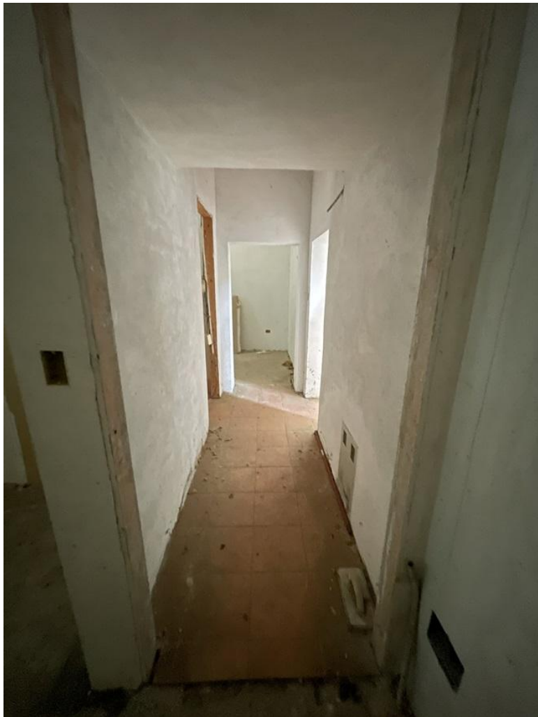
20) C.F. Fg.23 p.Ila 3469 sub.6 – Particolare del disimpegno che collega la zona giorno al reparto notte
