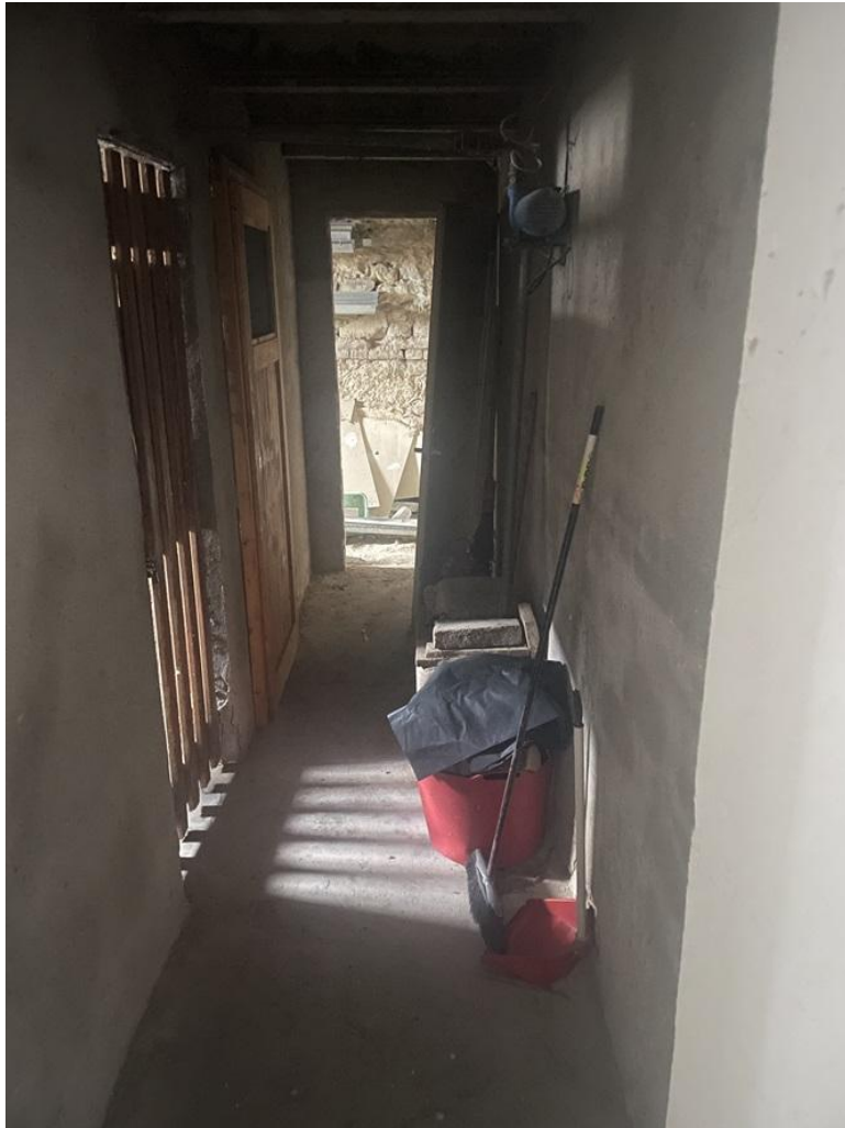
44) C.F. Fg.23 p.IIa 3469 sub.6 – Particolare del vano scala comune che permette il raggiungimento del locale cantina oggetto di stima ubicata al piano seminterrato
