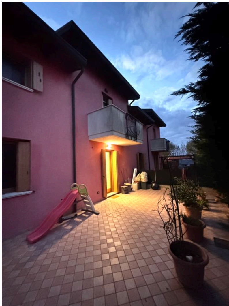
5 - Vista lato nord
