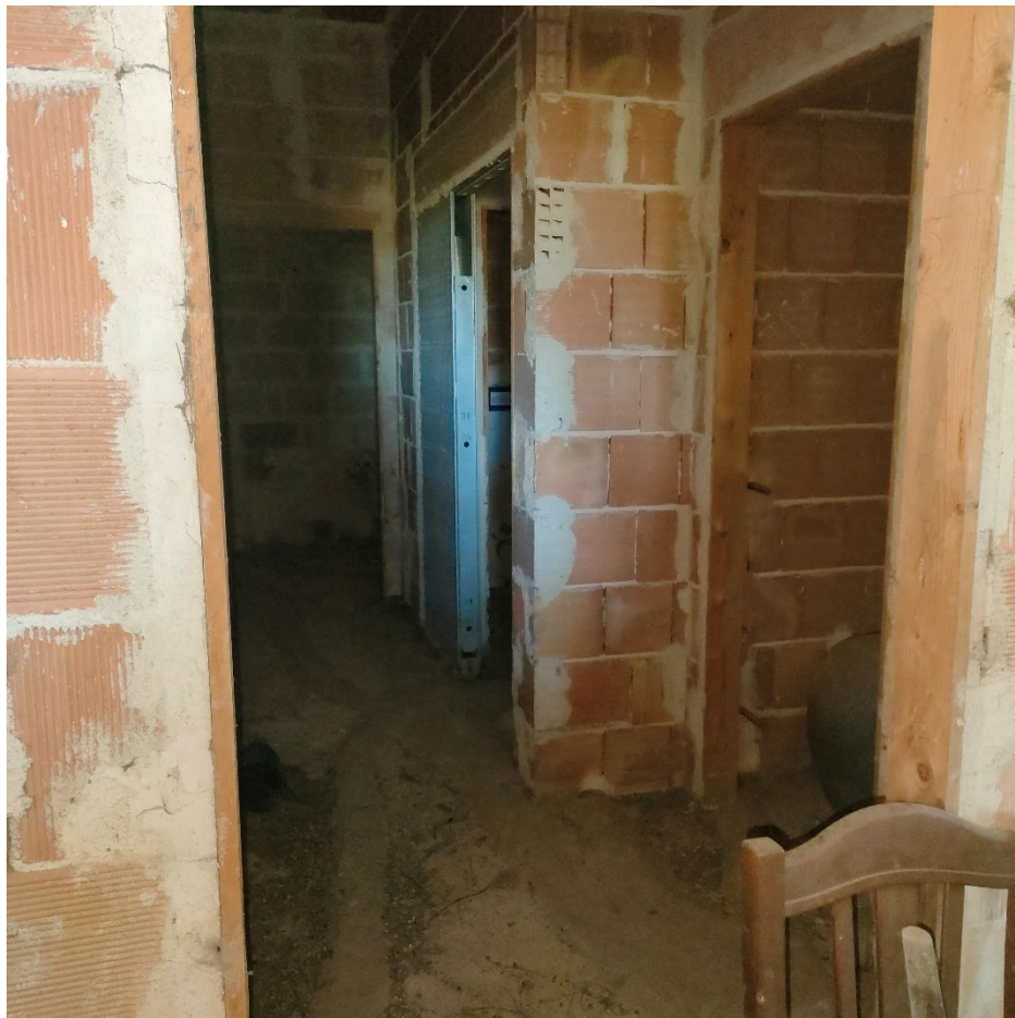
Foto n.19: vista blocco servizi.
