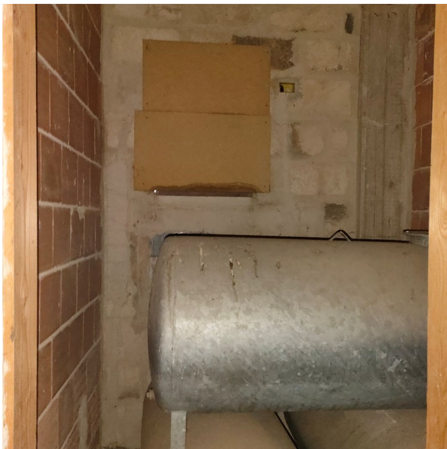
Foto n.20: vista blocco servizi.
