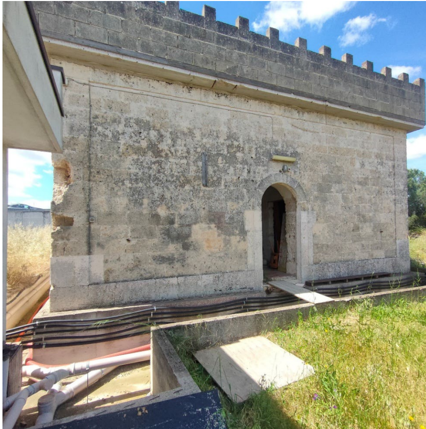
Foto n.3: vista volume A1.
