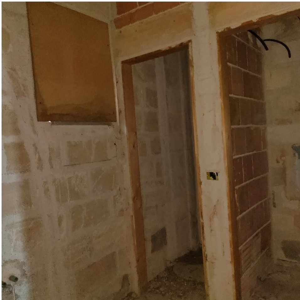
Foto n.22: vista blocco servizi.
