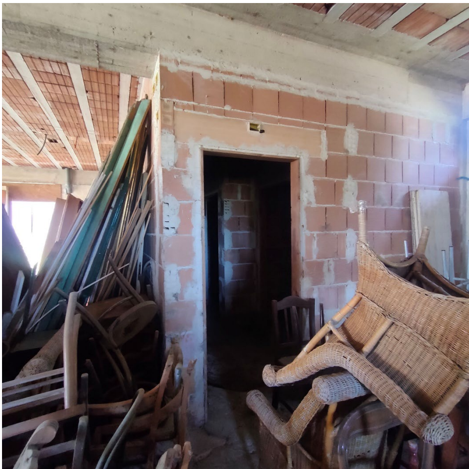
Foto n.18: vista blocco servizi.
