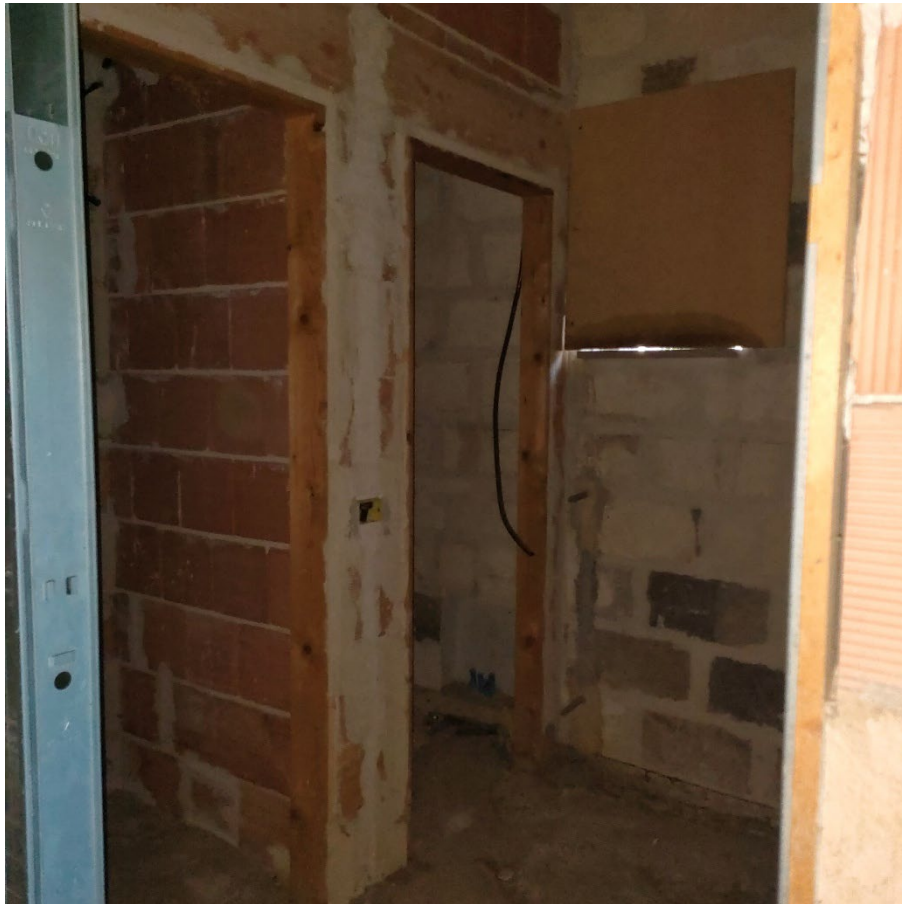
Foto n.21: vista blocco servizi.
