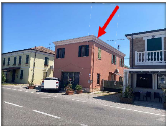
Fabbricato abitativo con due garages e corte
