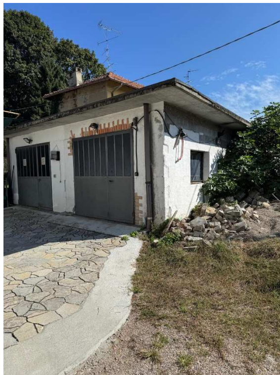
Vista del box dall'esterno
