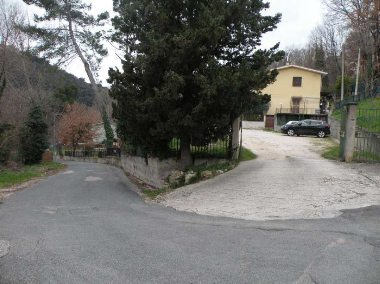
FOTO N°1: Vista esterna della strada di accesso all'immobile/1.
