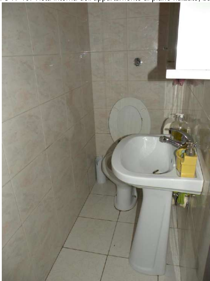
FOTO N°19: Vista interna dell'appartamento al piano rialzato, bagno.
