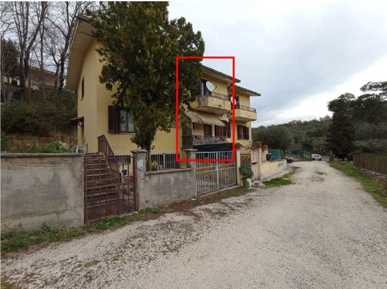
FOTO N°4: Vista esterna della corte comune/3.
