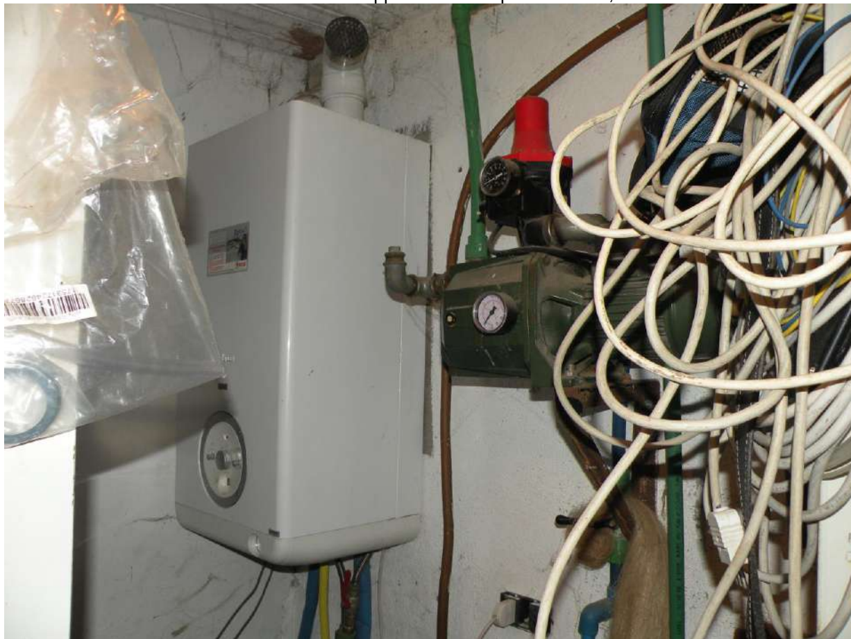
FOTO N°18: Vista esterna dell'appartamento al piano rialzato, locale tecnico/2.
