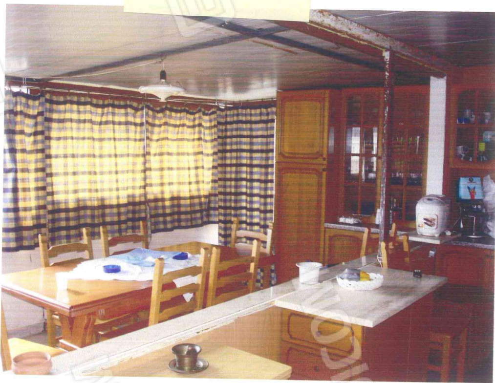
Cucina al primo piano con chiusura e copertura abusivamente realizzate
