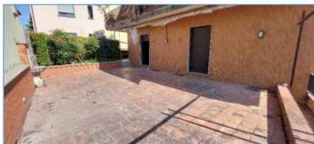
Terrazzo sopra autorimessa
