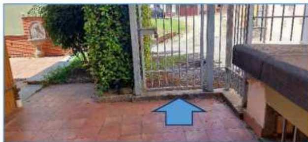
accesso esterno dal sedime di proprietà
