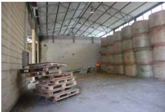
Capannone sud – locali deposito e centrale termica
