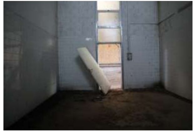
Capannone nord – blocco servizi e locali spogliatoio
