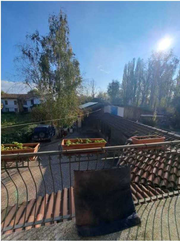
Figura 25- vista delle tettoie e delle pertinenze
