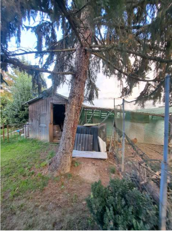
Figura 33- area verde – tettoie da rimuovere
