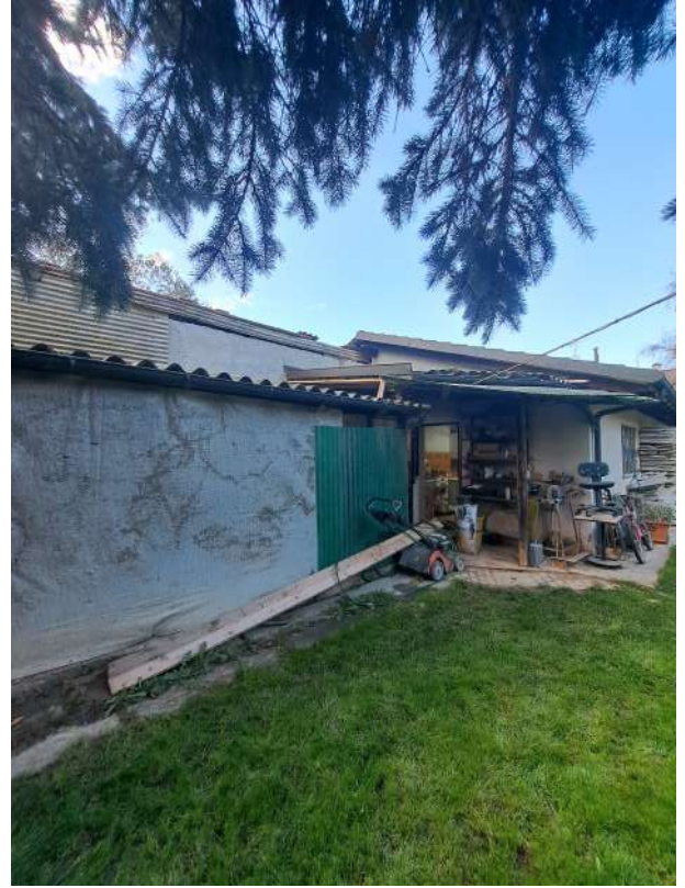
Figura 34- area verde – tettoie da rimuovere
