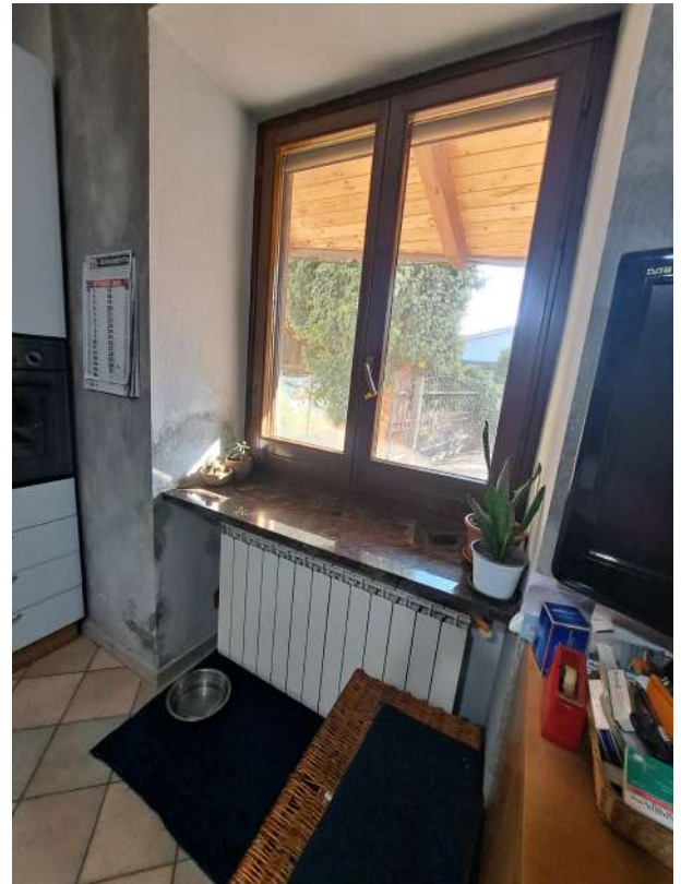
Figura 22- serramenti al piano terra
