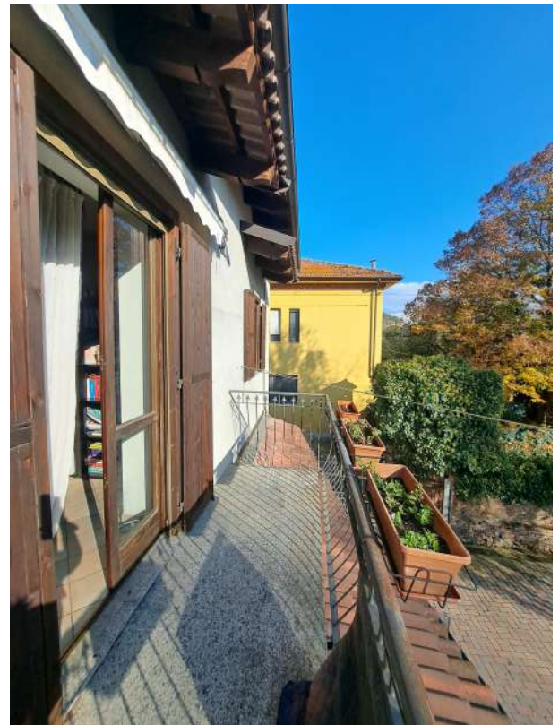
Figura 24- serramenti al piano primo e balcone
