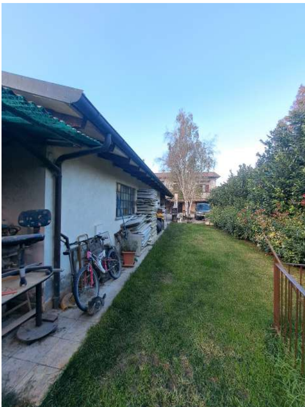
Figura 27- vista del locale di sgombero
