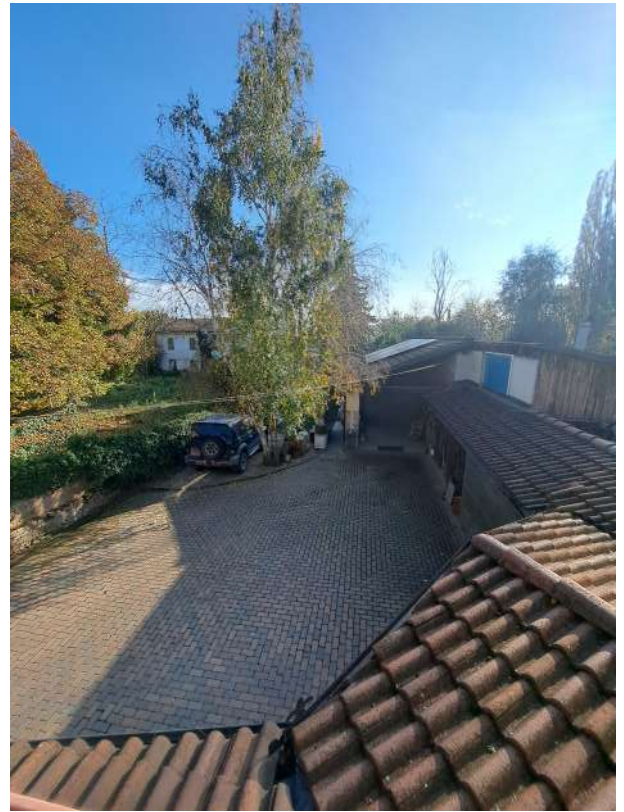
Figura 26- vista delle tettoie e delle pertinenze
