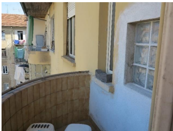
Immagini3/4: particola della finestra e formelle in vetrocemento del servizio igienico.
