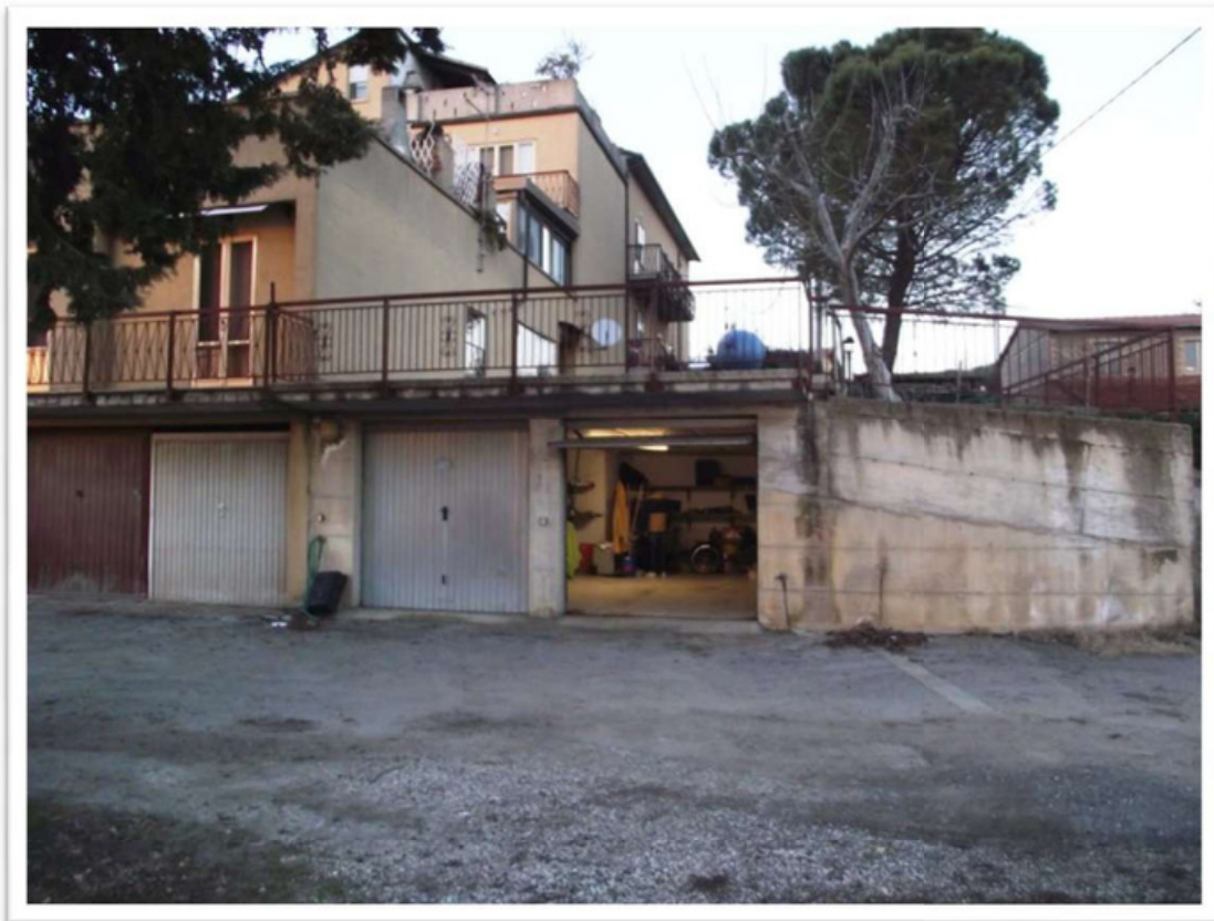
Foto 25 – Lotto B, Via del Frumento, esterno edificio, autorimessa
