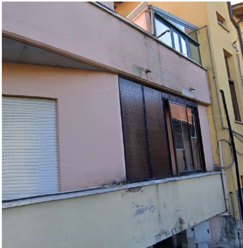
Esterno dell'edificio – retro
