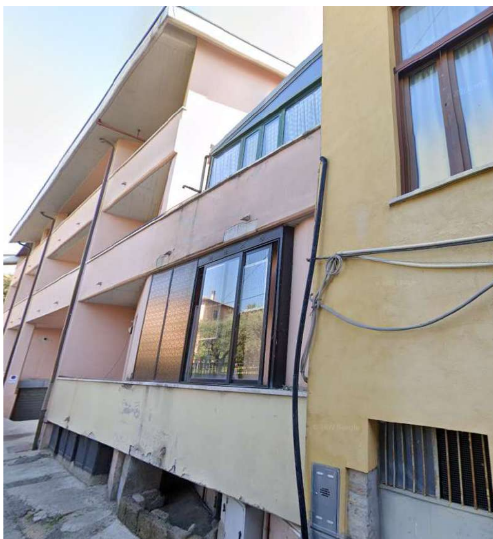
Esterno dell'edificio - retro
