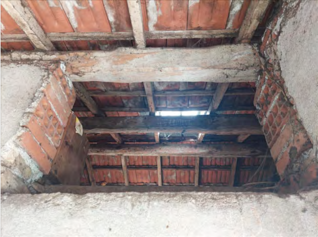
Sottotetto non abitabile
