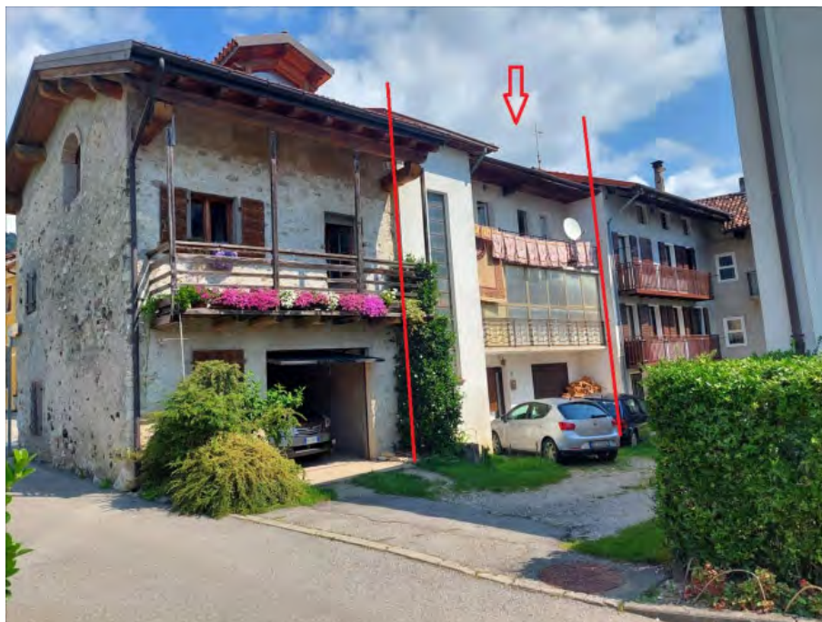
Lato sud da via Della Croce
