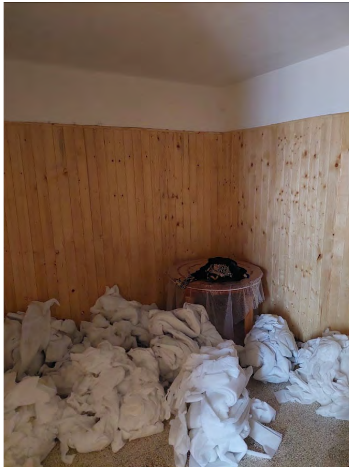
Vano PT lato est
