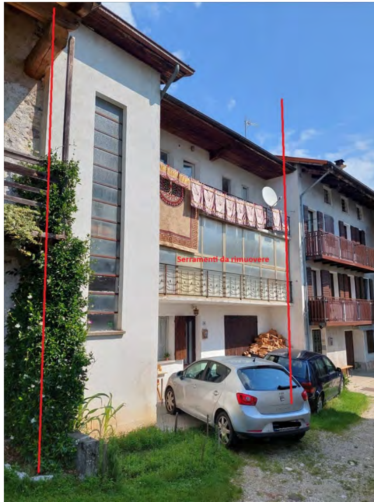
Lato sud con vetrata da rimuovere
