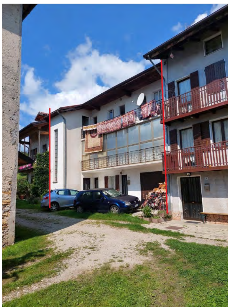
Lato sud dalla corte interna
