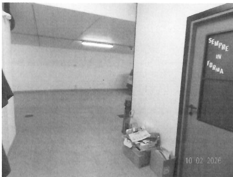
Fotografia 9 - SULLA DESTRA L'INGRESSO AL LOCALE DI SGOMBERO
