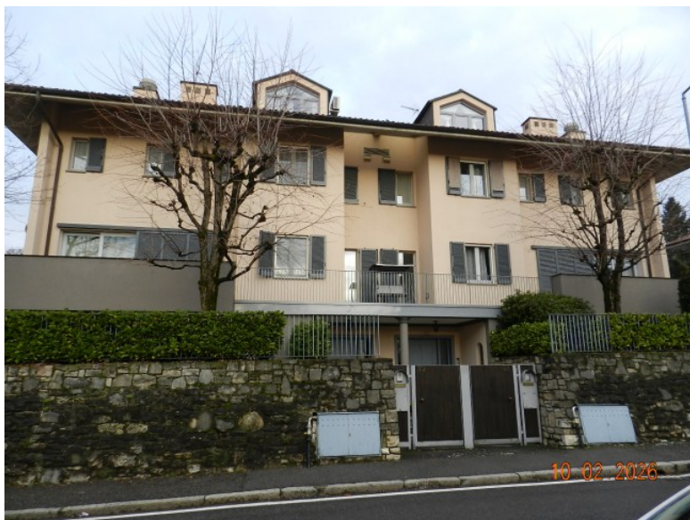
Fotografia 1 – Una vista da via Tomaso Edison
