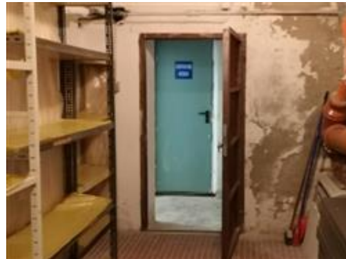
L'interno dell'ampia cantina
