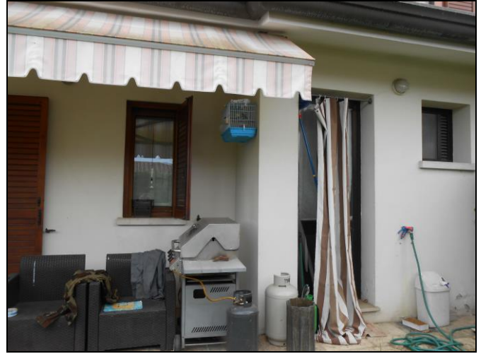
22) Finestra cucina e porta lavanderia
