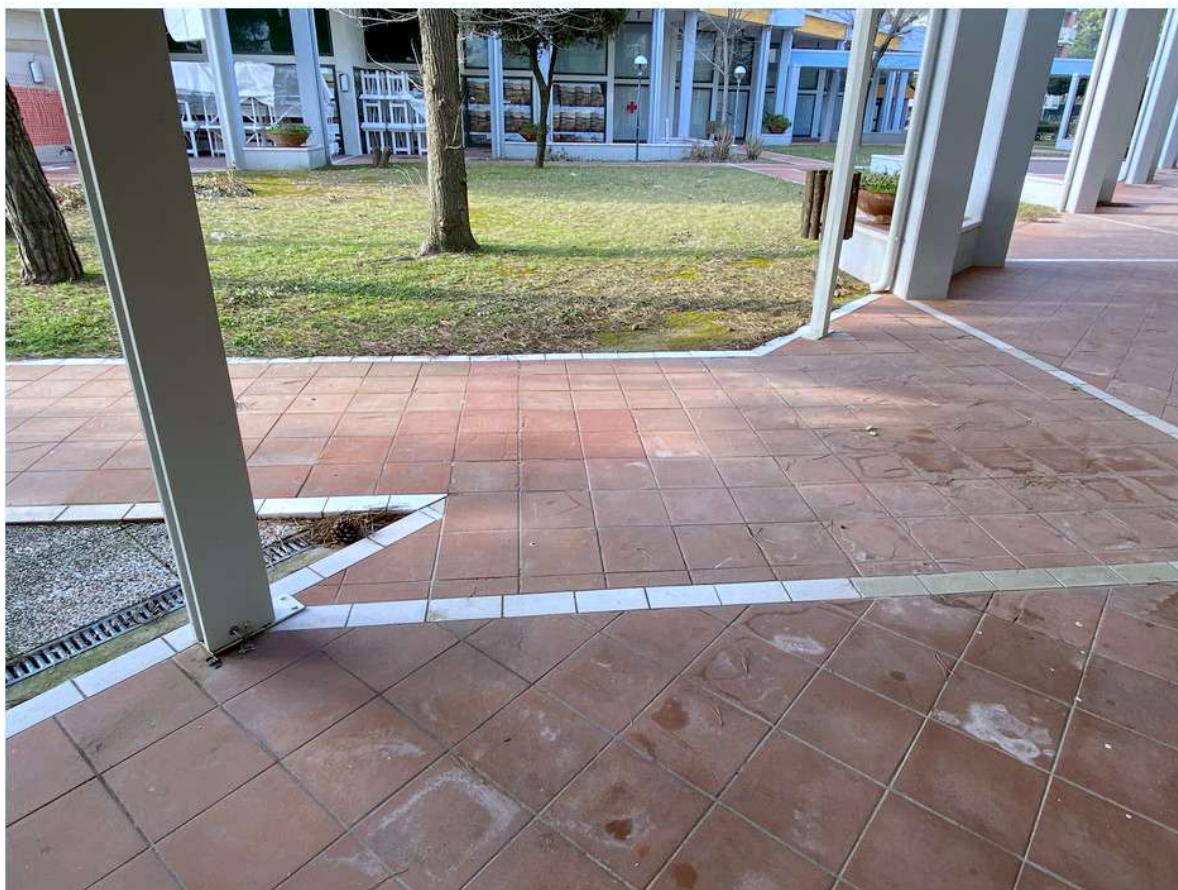
8 - Particolare della pavimentazione esterna del fabbricato sul fianco Ovest
