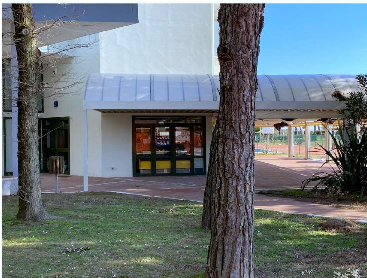
4 - Fianco Ovest dell'unità in oggetto e vista del porticato esterno - dehors
