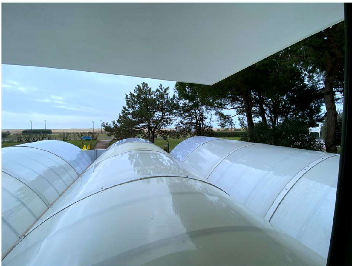
37 - Vista sulla copertura del dehors esterno
